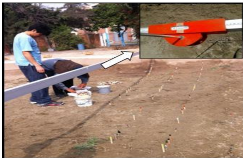
Foto N° 21 Colocación de tarugos mediante la regla y varilla metálica.
