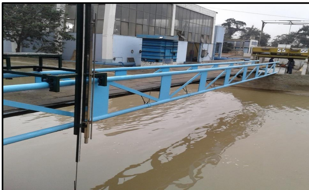
Foto N° 43 Puente y soporte metálico en el cual se instaló el vectrino.
