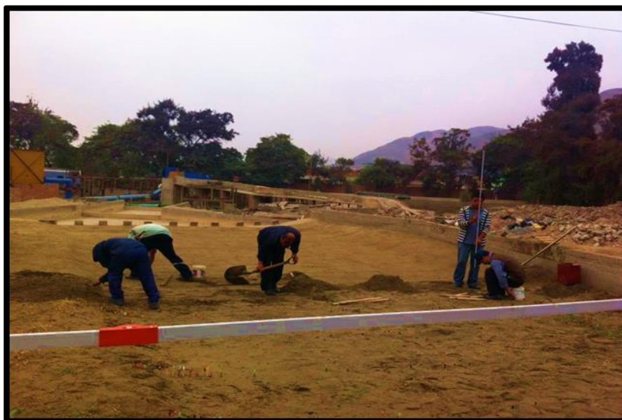
Foto N° 23 Representación en modelo del lecho del cauce.
