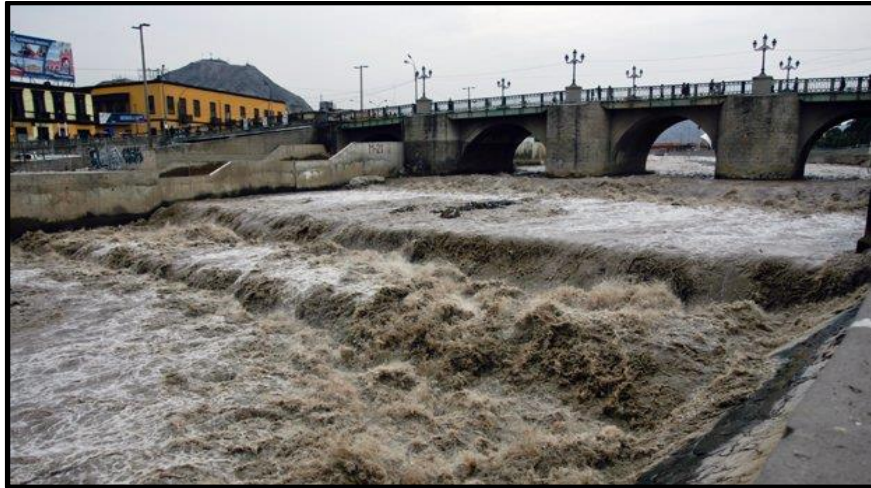
Foto N° 4 Avenida en el río Rímac – Lima con tendencia de desplomar un muro de canalización.
