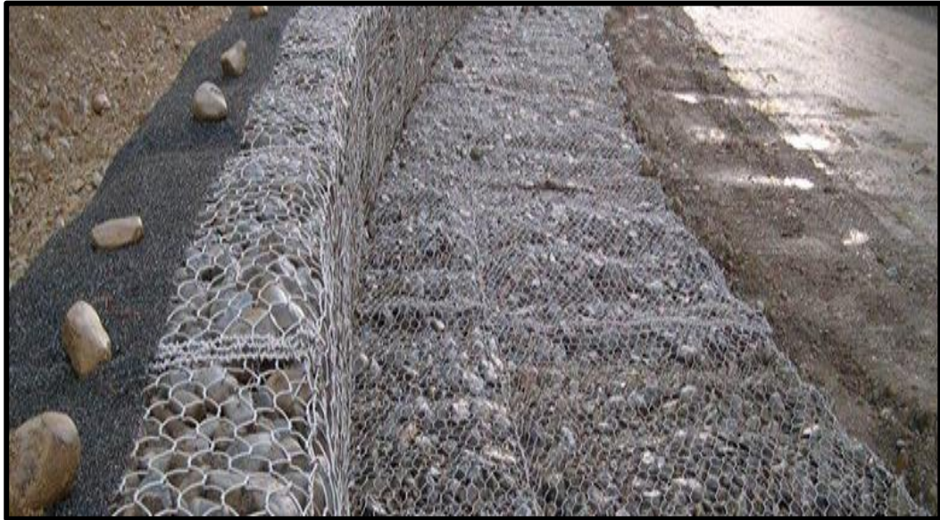
Foto N° 1 Gaviones de malla metálica como defensa ribereña
