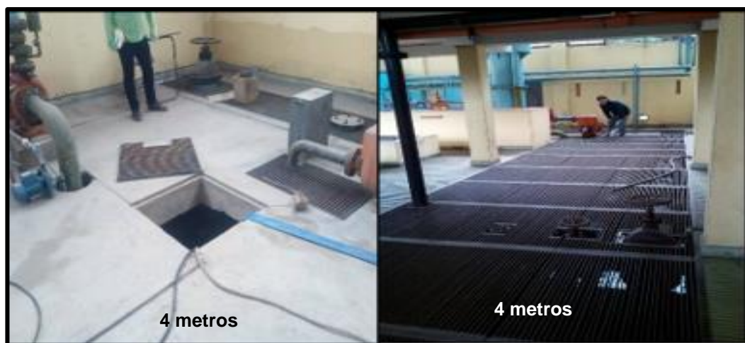
Foto N° 12 Cisternas en el área de didáctica con sus respectivas profundidades.
