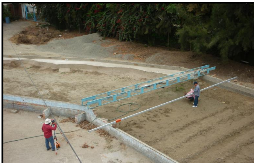
Foto N° 22 Nivelación de tarugos utilizando el nivel de ingeniero.
