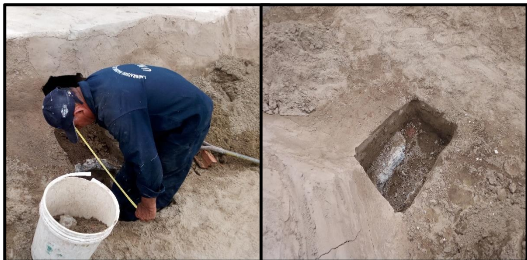
Foto N° 37 Excavación de material de lecho.
