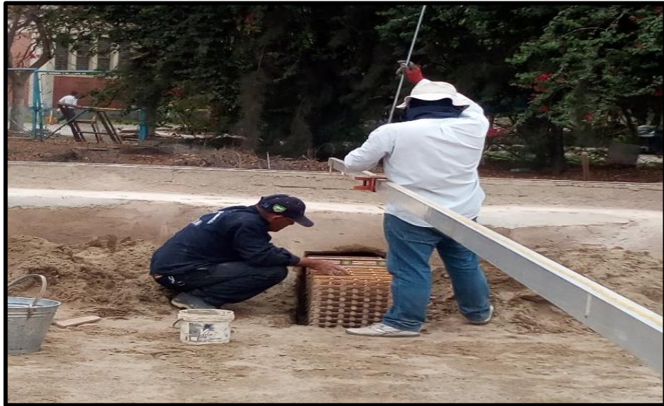
Foto N° 38 Nivelación de espigones con una regla metálica ubicada en el eje normal.
