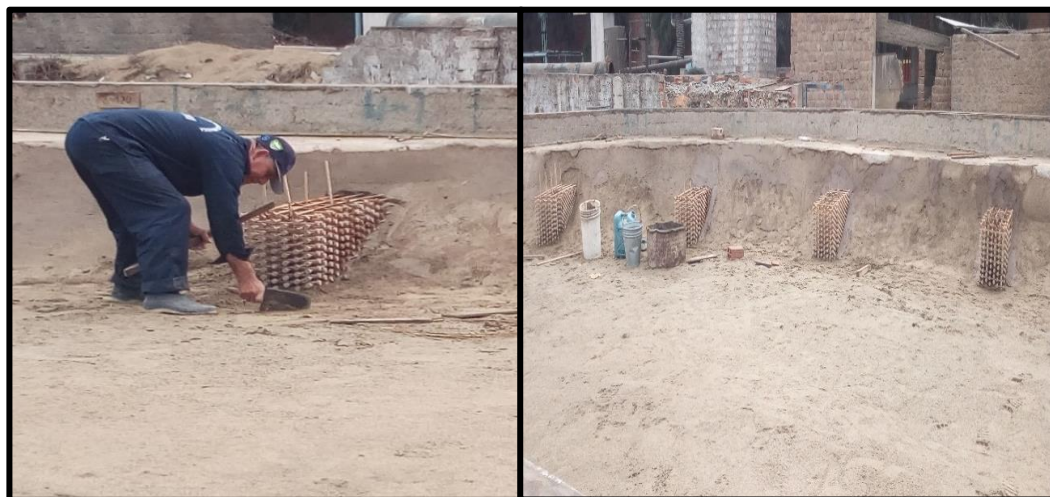
Foto N° 40 Reconstrucción del talud (izquierda) y colocación del sistema de espigones (derecha).
