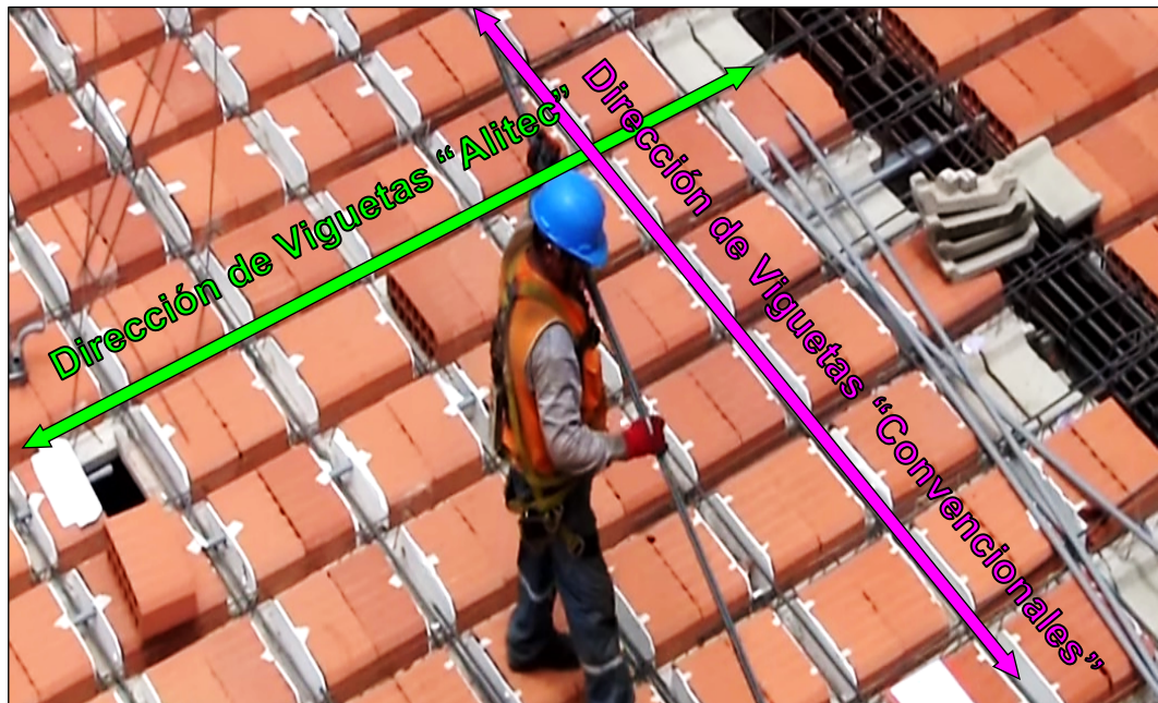
Figura N°5.8 Losa Bidireccional, Utilizando el Sistema Alitec.
