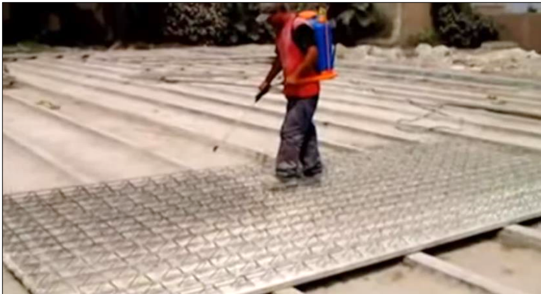
Figura N°4.9 Aplicación de Curador Químico en las Viguetas Alitec, Mediante Mochila Aspersora.
