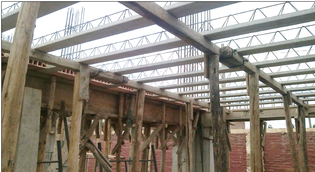
Figura N°4.13 Apuntalamiento y Nivelación de las Viguetas Alitec.
