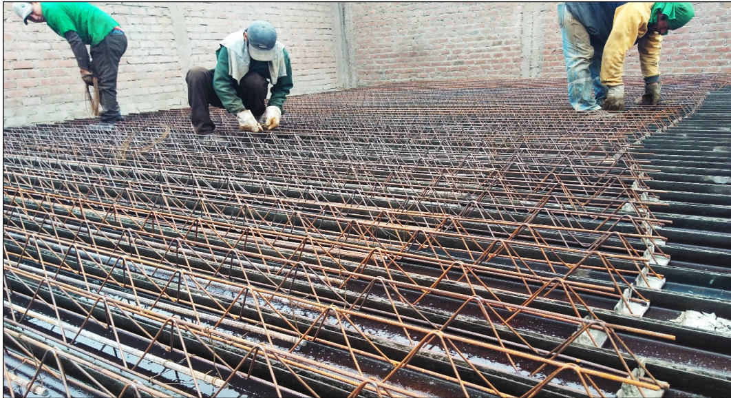
Figura N°4.6 Colocación del Conjunto (Tralicho y Acero de Refuerzo Positivo) en los Moldes.
