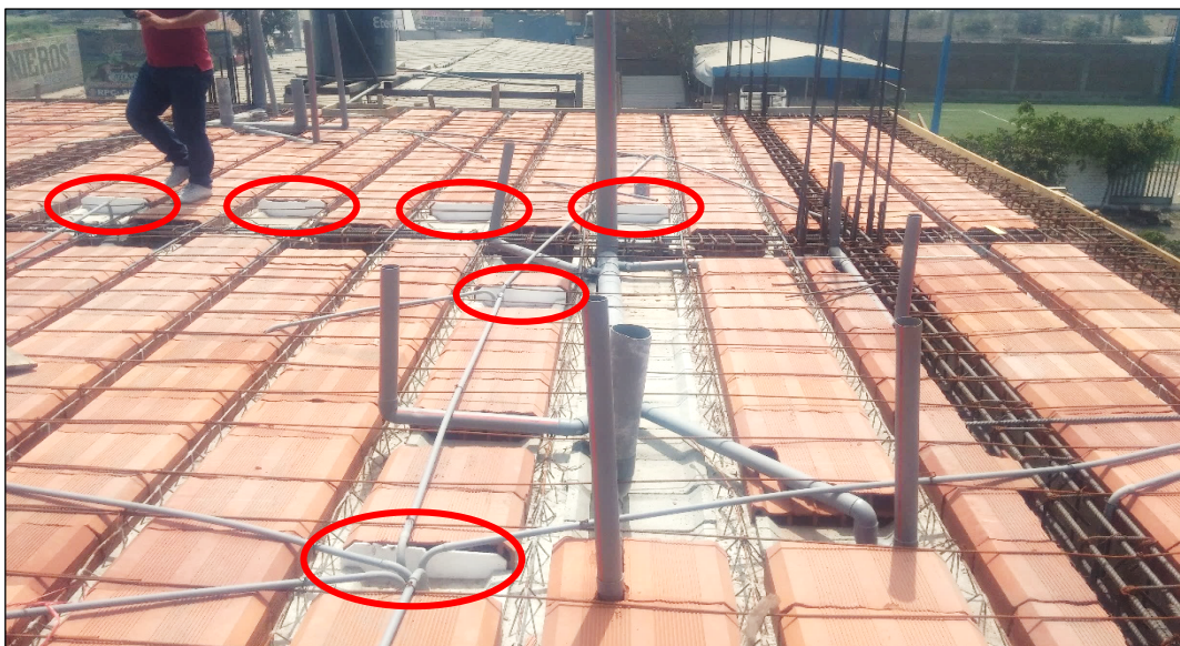
Figura N°4.19 Sellado de los Alveolos de las Bovedillas, usando Tapas de Tecnopor.
