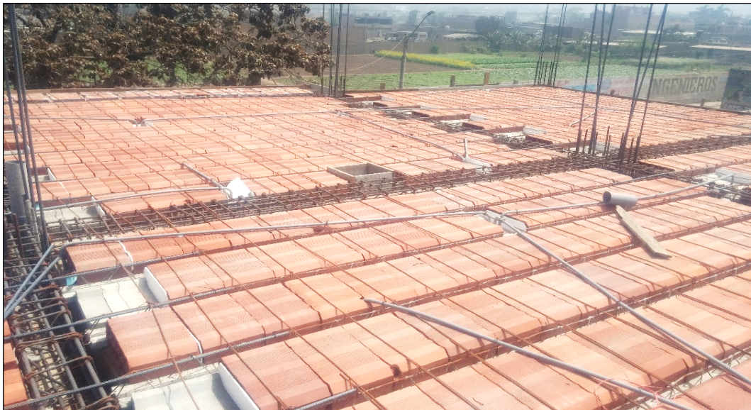
Figura N°4.17 Colocación de la Malla de Temperatura en la Losa Aligerada Alitec.
