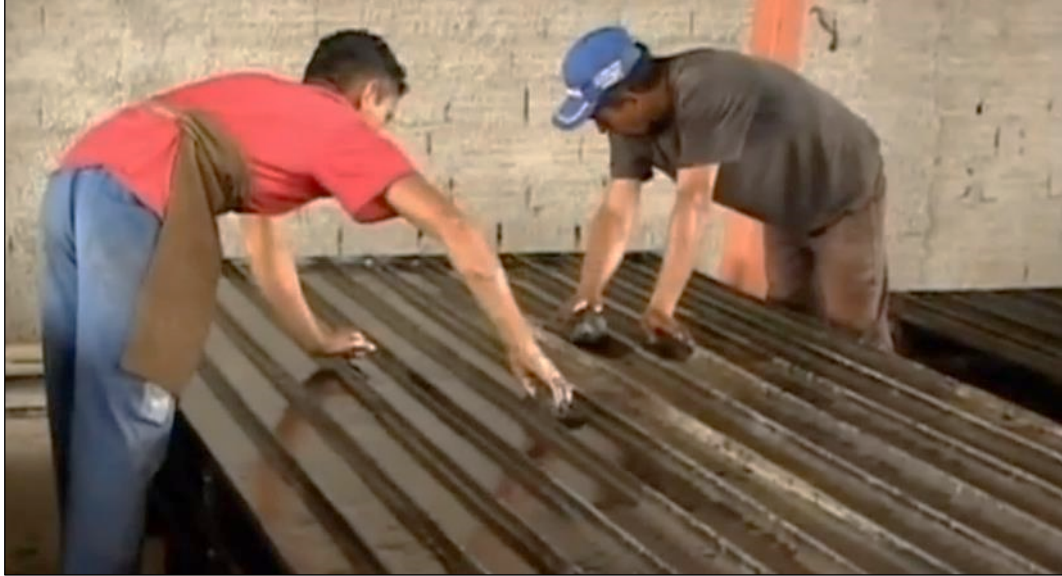
Figura N°4.4 Colocación de Desmoldante en los Moldes de las Viguetas Prefabricadas Alitec.
