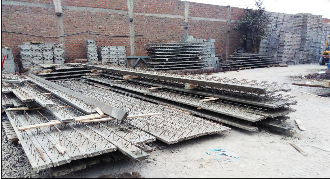
Figura N°4.8 Desencofrado y Almacenaje de Viguetas.
