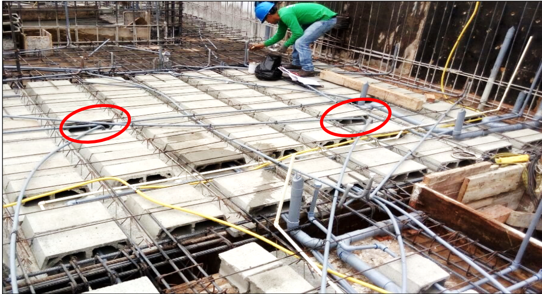
Figura N°4.18 Colocación de las Tuberías de Luz, usando las Bandejas Eléctricas.
