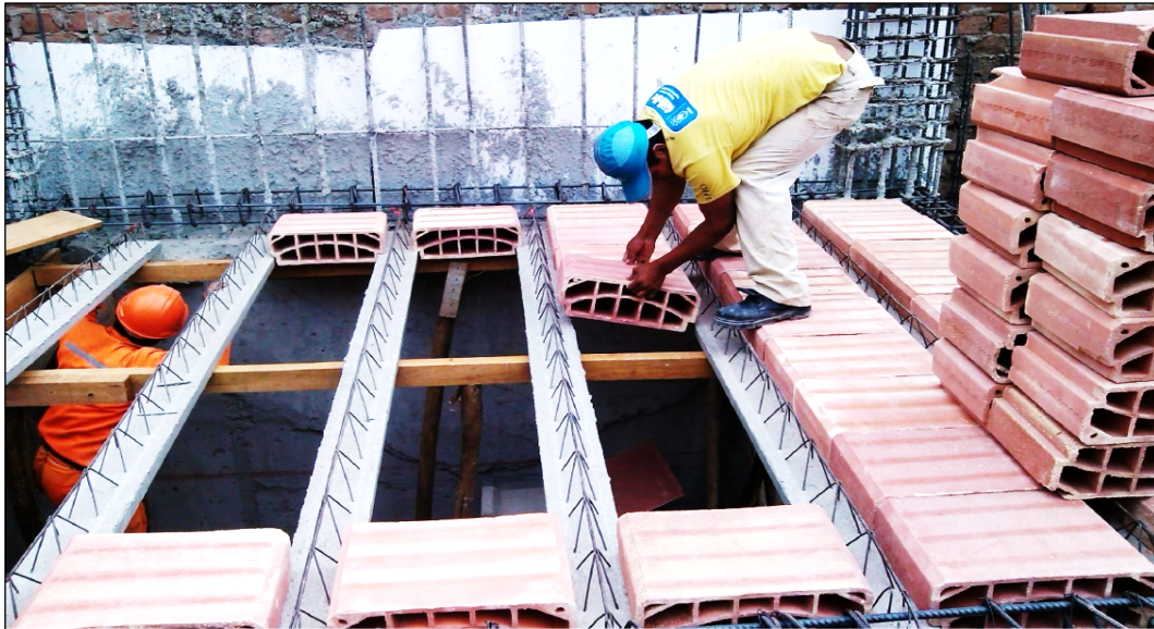
Figura N°4.14 Colocación de Bovedillas de Arcilla en los Extremos, para el Alineamiento de las Viguetas.
