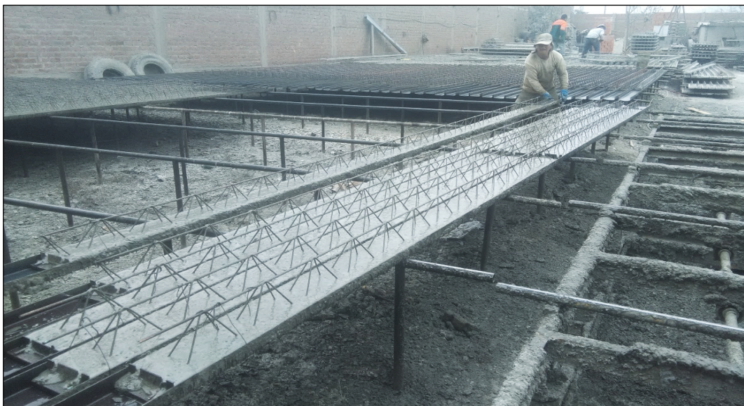
Figura N°4.7 Colocación y Vibrado del Concreto.
