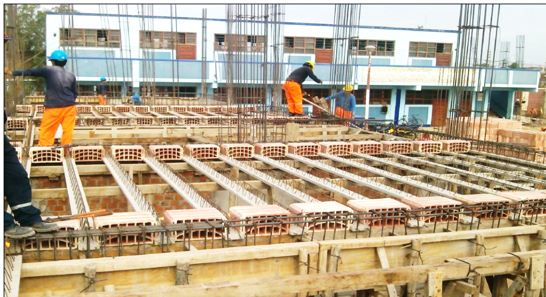
Figura N°4.12 Colocación de Viguetas Alitec en la Losa Aligerada.
