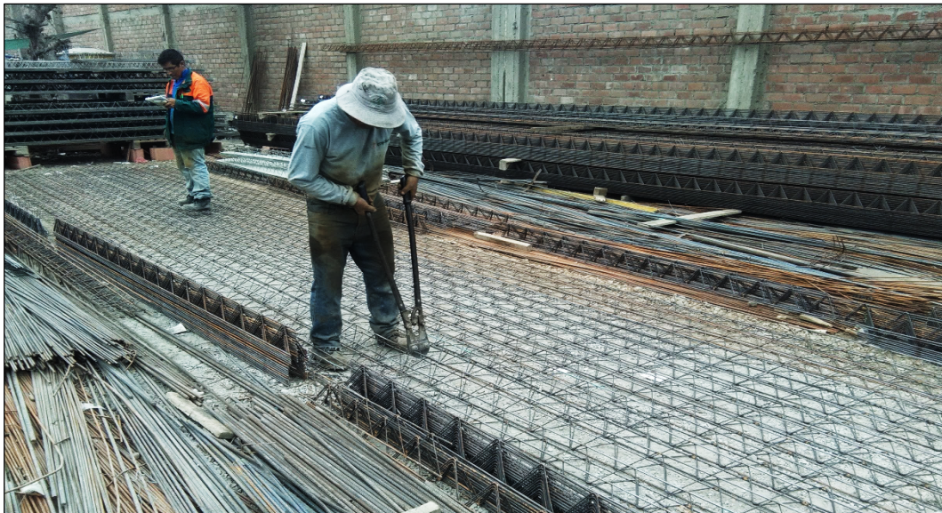
Figura N°4.3 Corte del Tralicho y Acero de Refuerzo.
