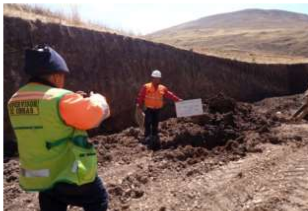
Figura N° 15.- Sector donde se evidencia la necesidad de Mejoramiento de suelo a nivel de SR Fuente: Elaboración Propia
