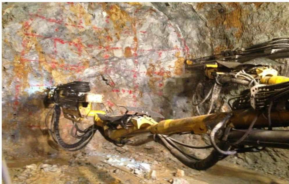
Figura 18: Aplicación del sistema de perforación
