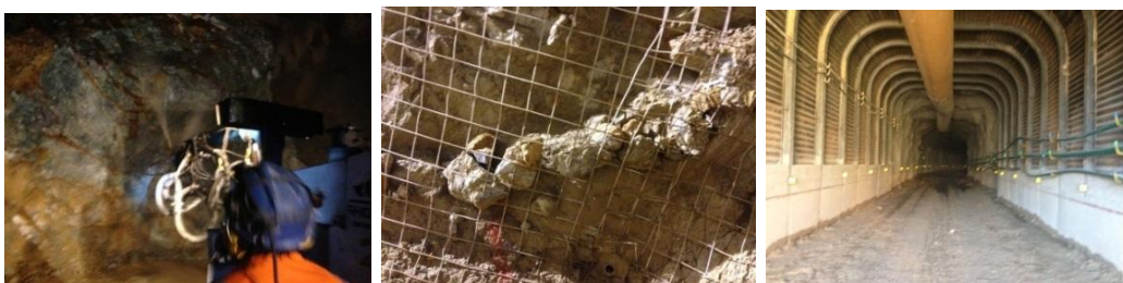
Figura 21: Aplicación del sostenimiento
