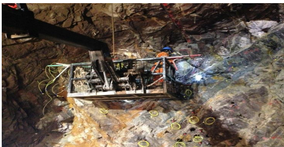
Figura 19: Aplicación del carguío de voladura
