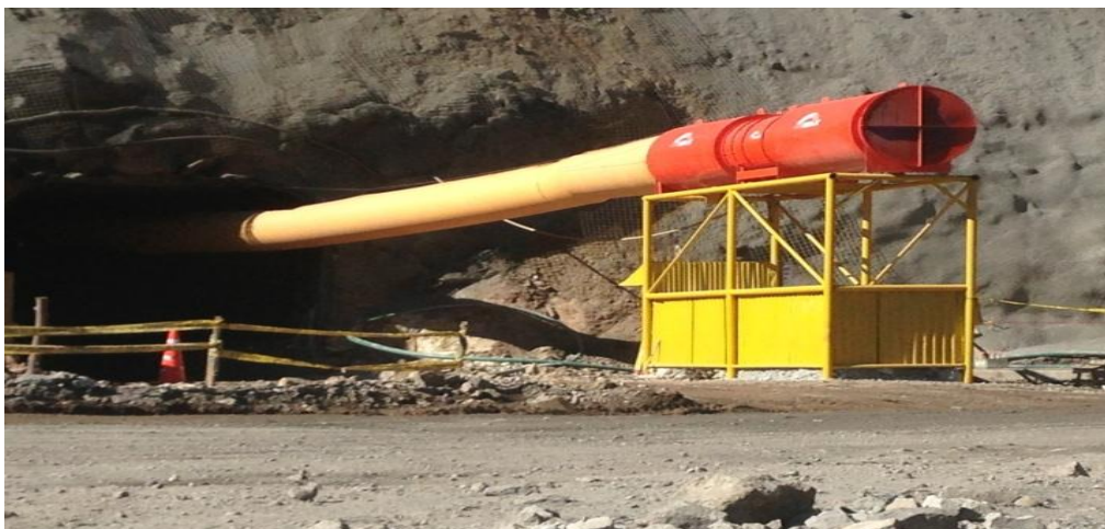
Figura 20: Aplicación del sistema de ventilación
