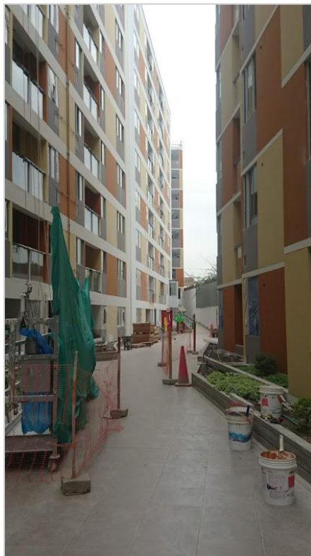
Figura 92: Vista interior visita de Obra Enero 2020 Fuente: Vanessa Alcantara.
