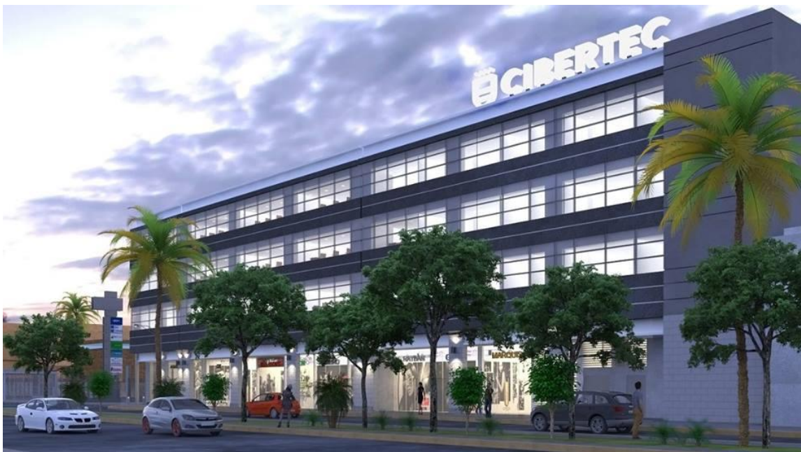
Figura 27: Vista de Fachada en Avenida Benavides. Fuente: Adolfo Chávez & Arquitectos Asociados
