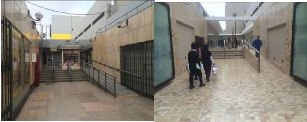
Figura 10: Antes y Después de Ingreso Av. Arenales Fuente: Adolfo Chávez & Arquitectos Asociados
