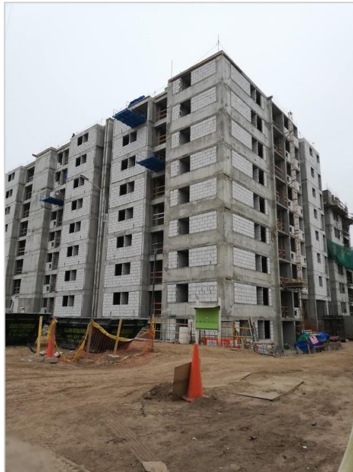
Figura 89: Vista exterior visita de Obra Agosto 2019 Fuente: Vanessa Alcantara.
