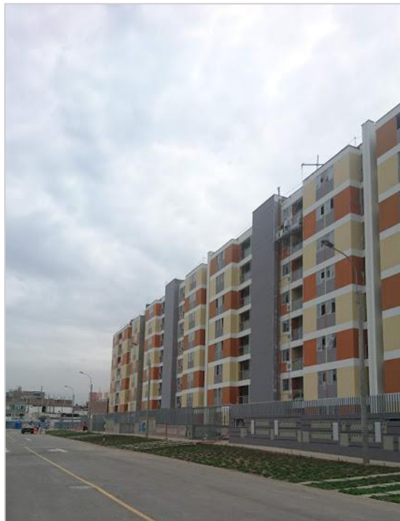
Figura 90: Vista exterior visita de Obra Enero 2020 Fuente: Vanessa Alcantara.
