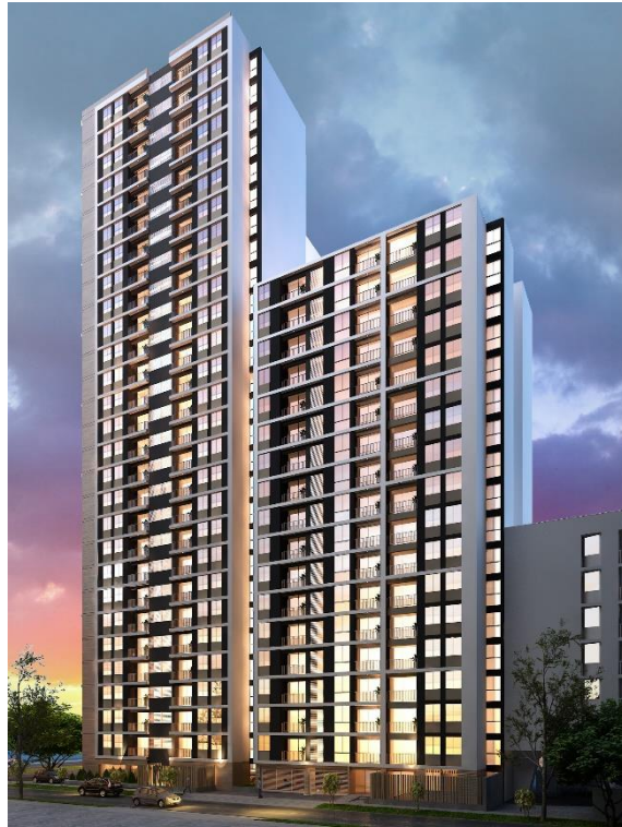
Figura 44: Fachada desde Calle Brillantes Fuente: Miranda Arquitectos
