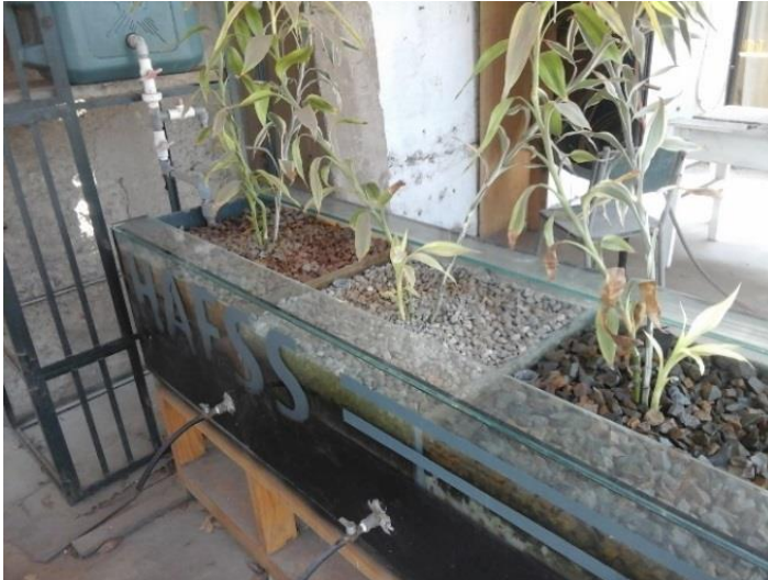
Fig.8: Proceso finalizado de llenado y plantación de cada compartimento, para proceder con la puesta en marcha del humedal artificial.
