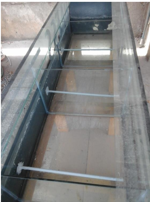
Fig.5: Instalación de tuberías de recolección de 1/2" para toma de muestra en cada compartimento.
