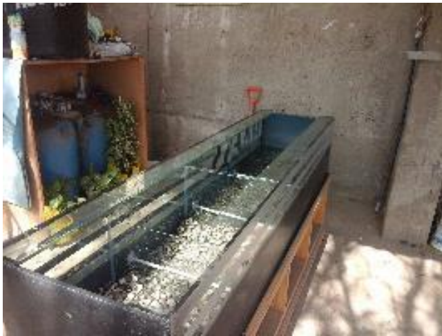
Fig.6: Proceso de llenado de cada compartimento del módulo, con piedra de diferente granulometría hasta el borde de cada pantalla.
