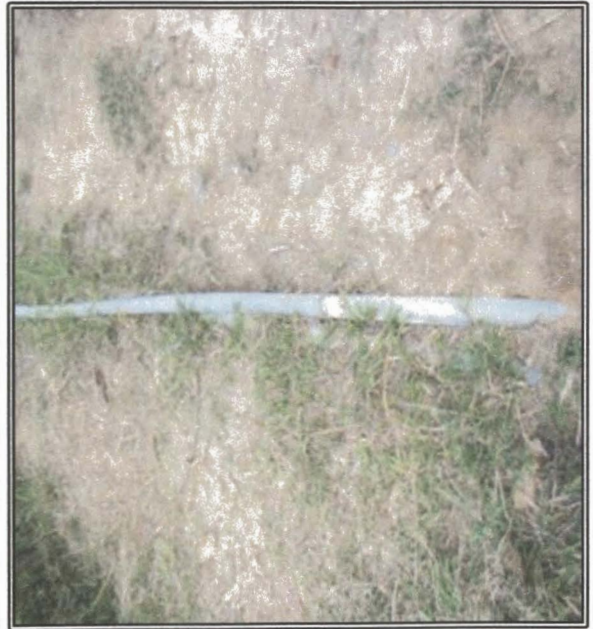
Foto 6. REDES DE DISTRIBUCIÓN CON TUBERÍAS EXPUESTAS.
