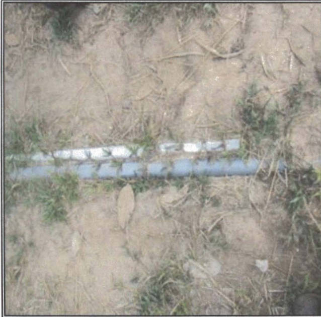
Foto 6. REDES DE DISTRIBUCIÓN CON TUBERÍAS EXPUESTAS.
