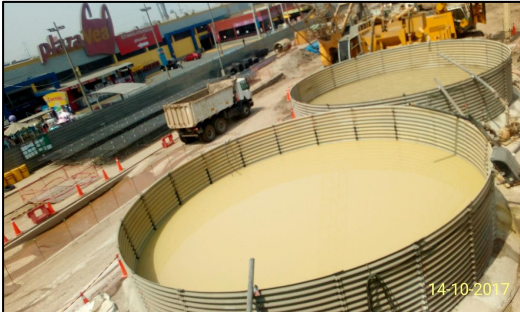
Figura 3.2: Pozos de lodo ventonítico
