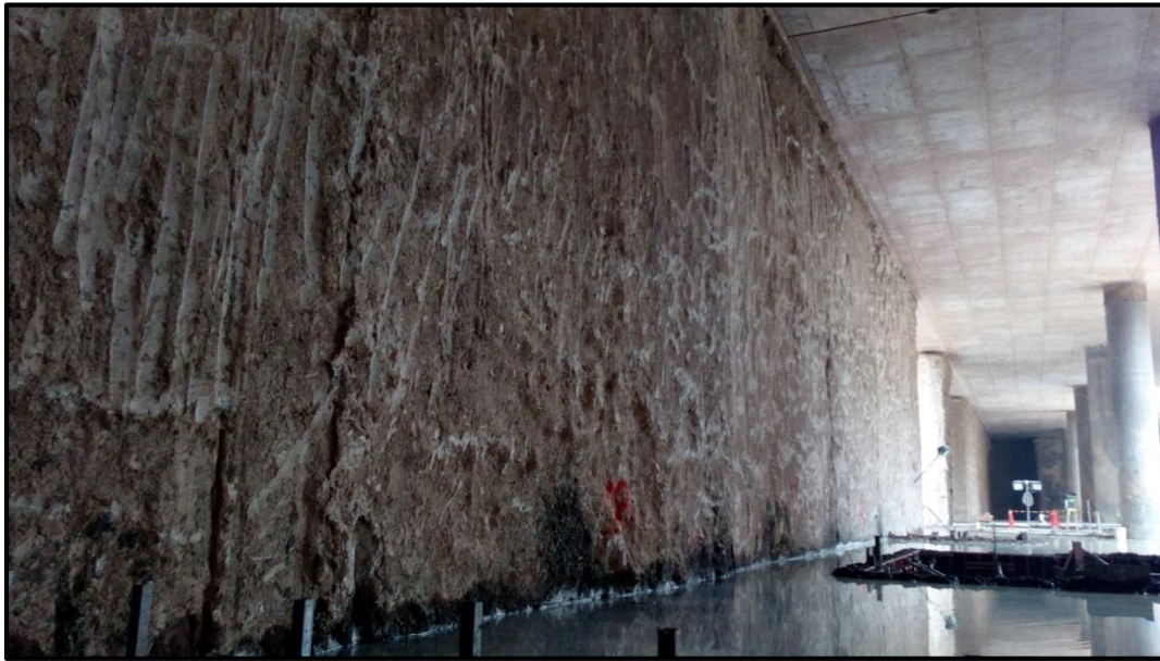
Figura 2.13: Pantallas continuas de concreto armado
