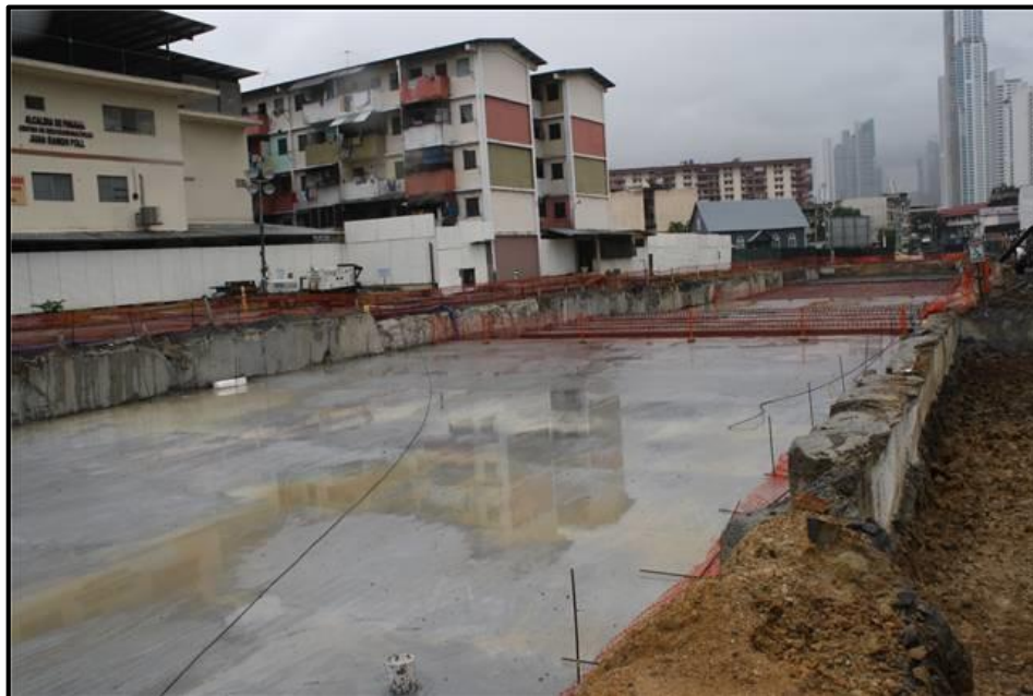
Figura 3.13: Vaciado de concreto sobre elementos prefabricados para la losa de cobertura.
