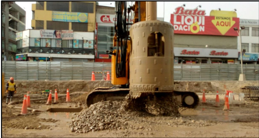
Figura 3.4: Excavación para ejecutar pilote
