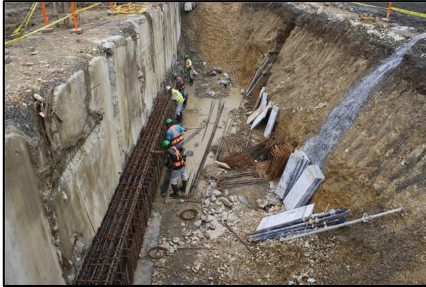
Figura 3.11: Viga de coronación.
