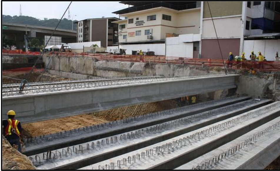
Figura 3.12: Montaje de vigas prefabricadas para la losa de cobertura.
