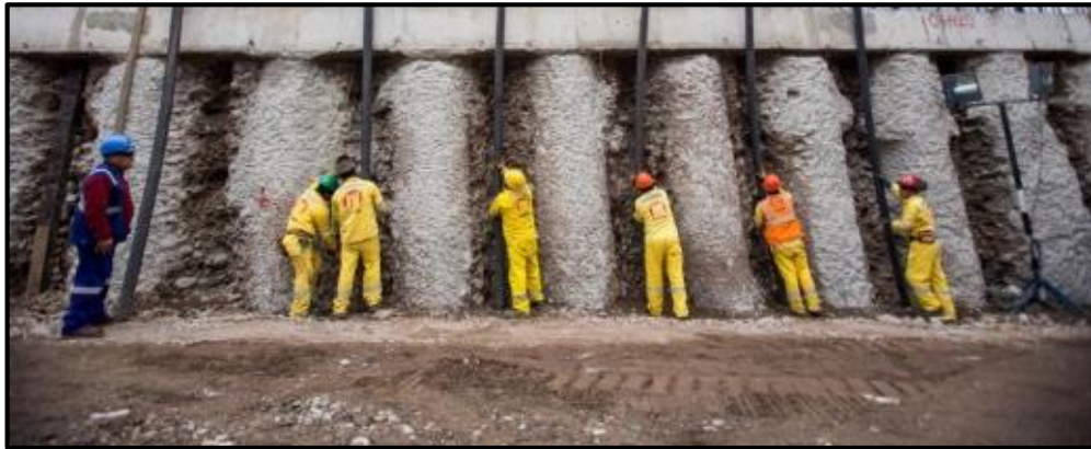
Figura 3.15: Estabilización de pilote
