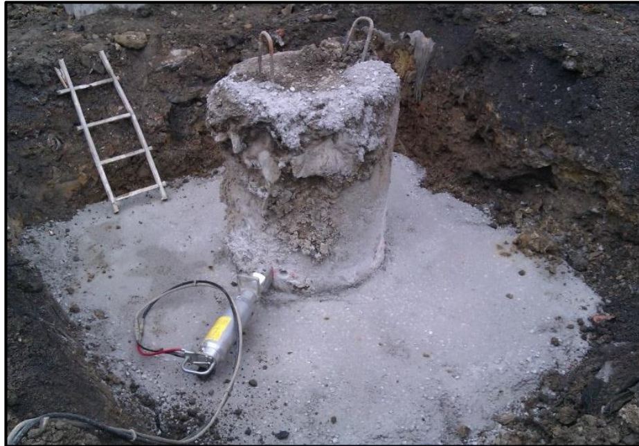
Figura 3.10: Descabezado de parte del pilote contaminado
