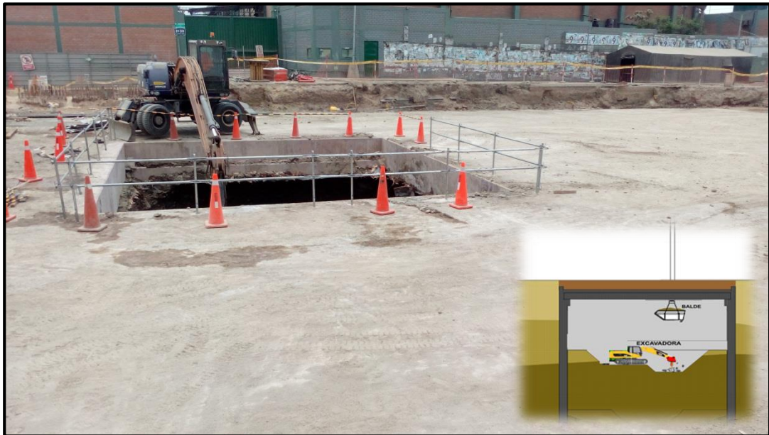
Figura 3.14: Excavación por debajo de losa.
