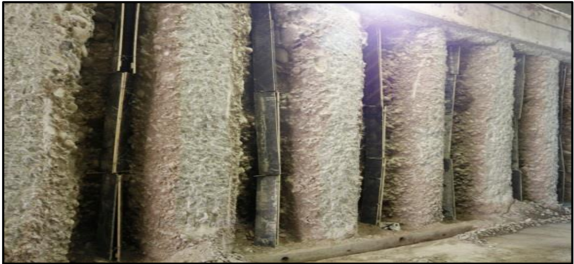
Figura 3.8: Pilotes espaciados
