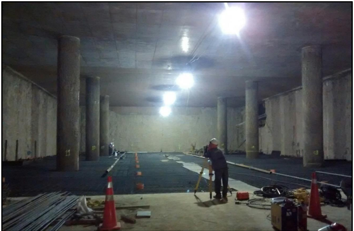
Figura 4.13: Ejecución de losa.
