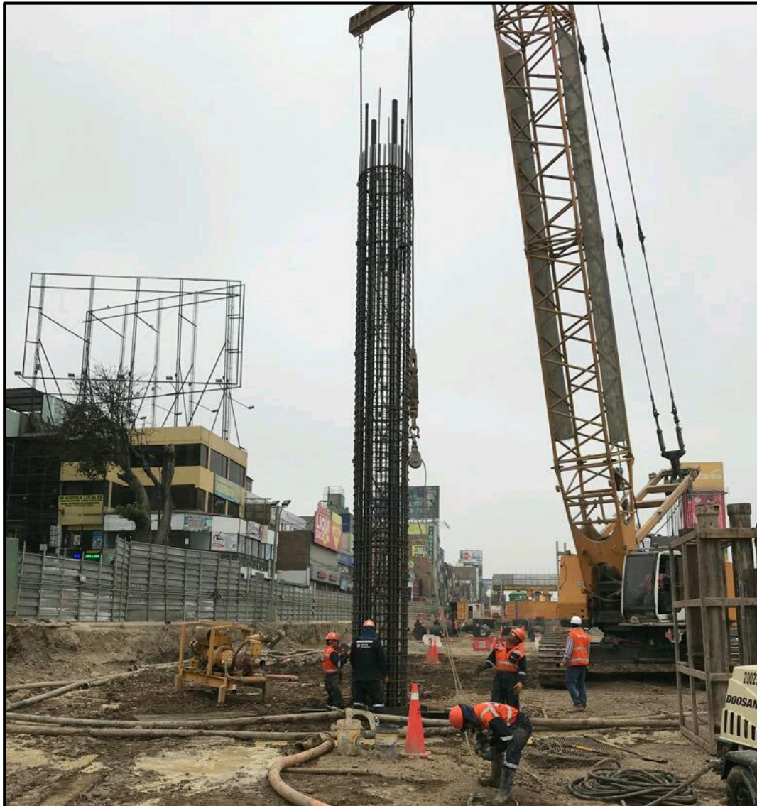
Figura 3.5: Colocación de armadura
