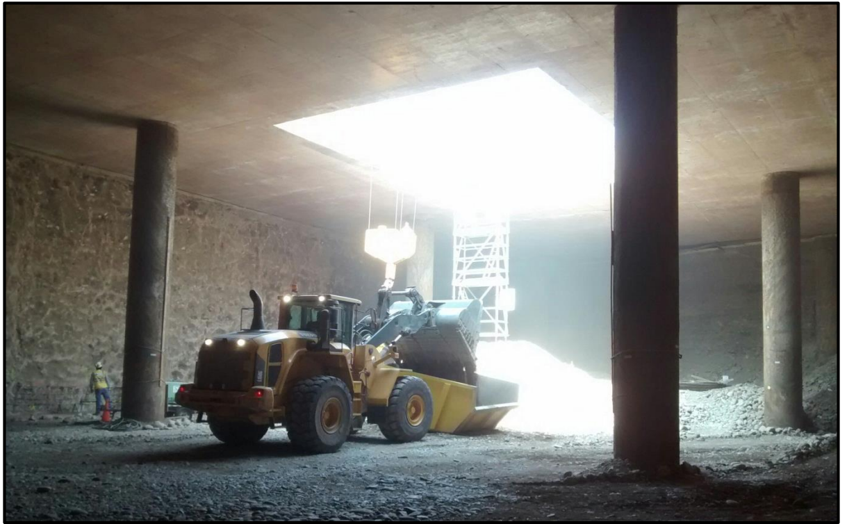
Figura 4.12: Excavación por debajo de la losa de cubierta.
