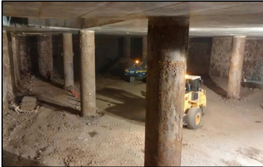
Figura 4.15: Excavación entre losa de vestíbulo y losa de fondo.
