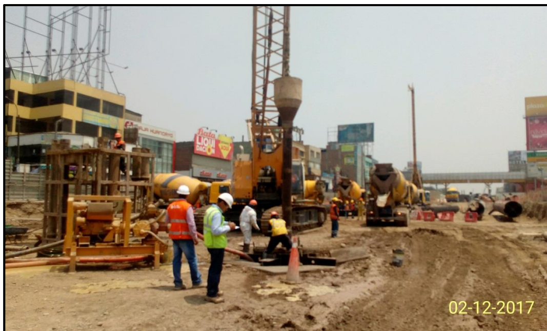
Figura 3.6: Extracción de tubo tremie
