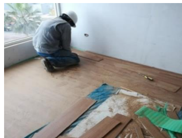
Figura N°7: Colocación de Piso laminado
