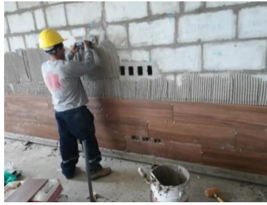
Figura N°6: Colocación de zócalo de Porcelanato
