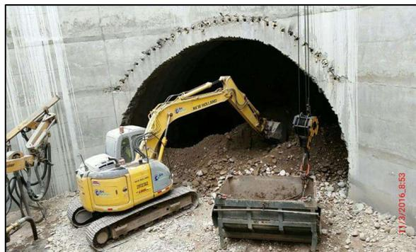
**FIG . A99:** En la foto se aprecia la Excavación del túnel convencional con el método NATM
