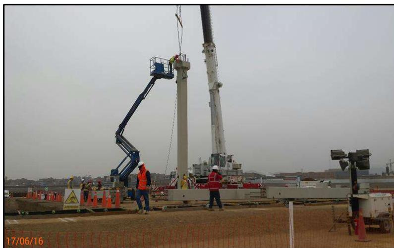
**FIG . A8:** Observamos el montaje de columnas prefabricadas - Nave de Material Rodante
