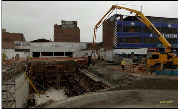
**FIG . A117:** Se aprecia el vaciado de concreto para muros de cámara de ventilación PV21
