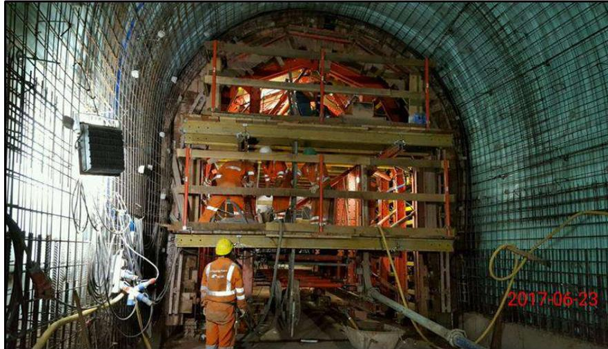
**FIG . A52:** Apreciamos el revestimiento secundario - Túnel Ramal Acceso PTSA
