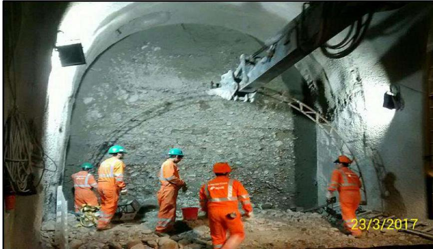
**FIG . A40:** Se observan trabajos de excavación y colocación de cercha para Túnel Ramal Acceso PTSA
