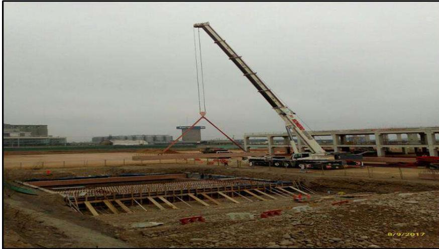
**FIG . A61:** Se observan los trabajos de montaje de vigas de losa de cubierta para pozo de ataque - PTSA
