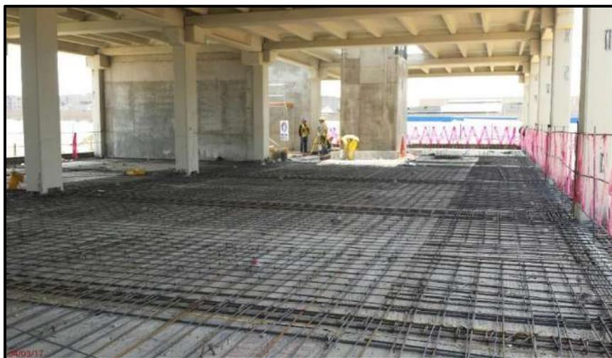
**FIG . A38:** Verificaciones de acero para refuerzo de Losas 2do Nivel - Edificio de Oficinas – PTSA
