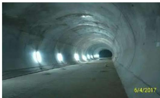
**FIG . A112:** Observamos los trabajos de revestimiento secundario en el túnel convencional
