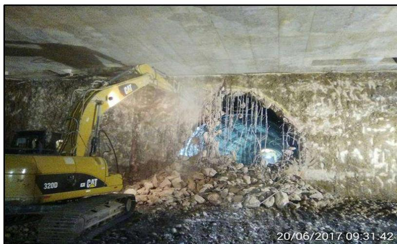
**FIG . A80:** Se observan los trabajos de demolición de muros pantalla para acceso al Túnel
