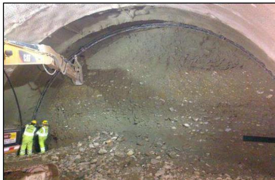
**FIG . A103:** Se observa en la foto la colocación de cerchas en el túnel convencional
