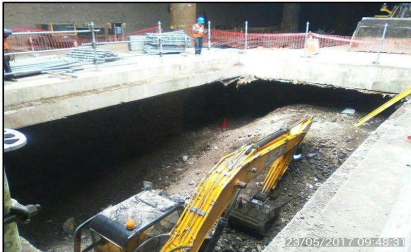
**FIG . A78:** Observamos en la foto trabajos de excavación debajo de la losa de vestíbulo E-23 Hermilio Valdizán
