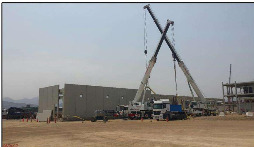
**FIG . A42:** Vista de los trabajos de montaje de paneles - Edificio Técnico - PTSA
