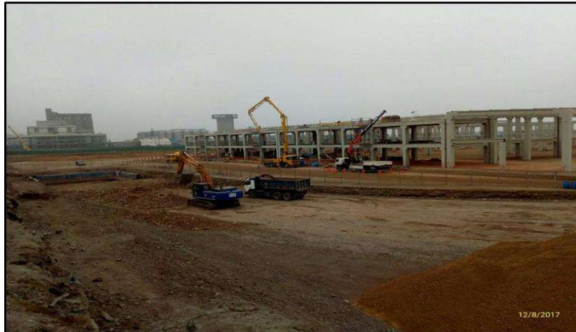
**FIG . A55:** Apreciamos los trabajos de colocación de relleno para Sección Bóveda en Falso Túnel - PTSA
