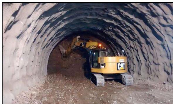
**FIG . A104:** Observamos la excavación del túnel convencional con el método NATM
