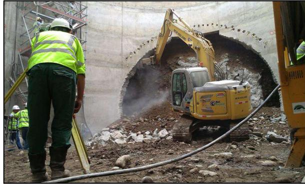
**FIG . A97:** Observamos la excavación del túnel convencional con el método NATM desde el lado Ate del entronque Pozo - Túnel en el PV20
