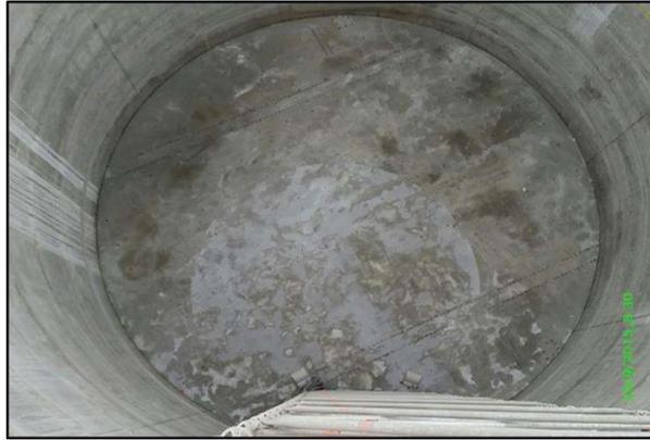
**FIG . A93:** Observamos el curado de la losa de fondo del PV21
