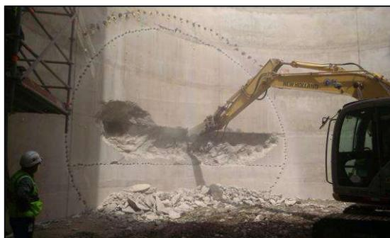
**FIG . A96:** Se observa la demolición del emboquille o entronque Pozo - Túnel en el lado Ate en el PV20
