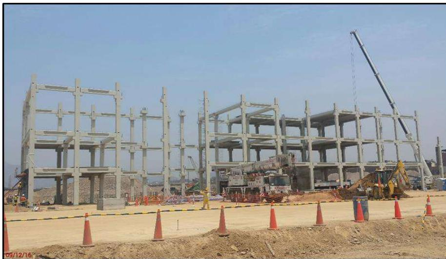
**FIG . A29:** Trabajos de montaje de vigas y losas TT - Edificio de Oficinas
