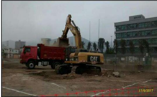
**FIG . A113:** Aquí se observan los trabajos Iniciales de excavación para cámara de ventilación - PV23
