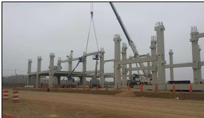
**FIG . A23:** Trabajos de montaje de vigas prefabricadas - Nave de Taller Principal - PTSA
