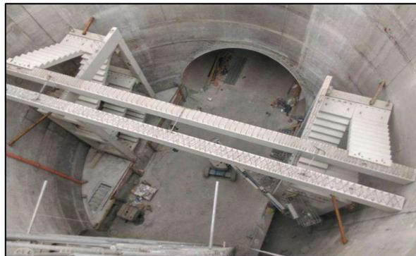
**FIG . A122:** La imagen muestra los trabajos de construcción de escalera, pórticos, muros y vigas en PV21 Fase II
