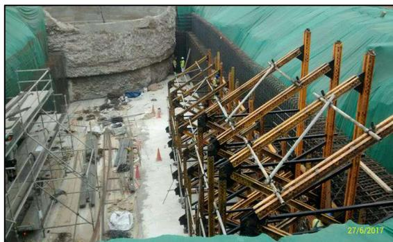
**FIG . A116:** Apreciamos el encofrado para muro de Cámara de Ventilación - PV23 Fase II
