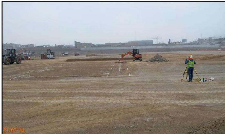
**FIG . A10:** Verificación de trazo, replanteo de ejes y ubicación de cimientos - Edificio Técnico – PTSA
