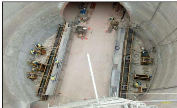
**FIG . A119:** La imagen muestra los trabajos de encofrado para muros y pedestales PV22
