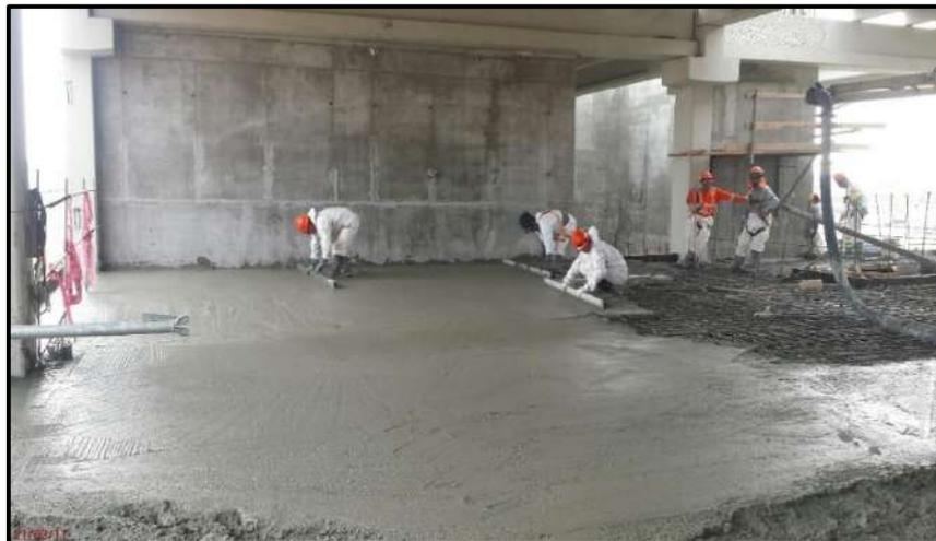
**FIG . A41:** Se observa los trabajos de vaciado de concreto en losas - Edificio de Oficinas - PTSA
