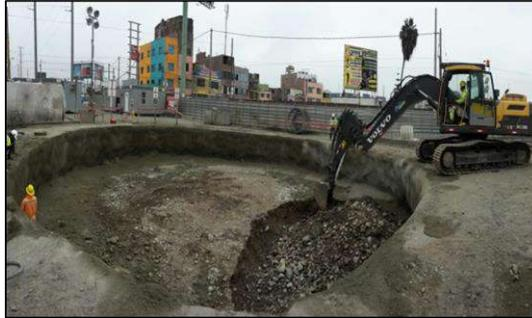
**FIG . A85:** En la foto apreciamos el inicio de la excavación para la construcción del anillo 1 del PV20
