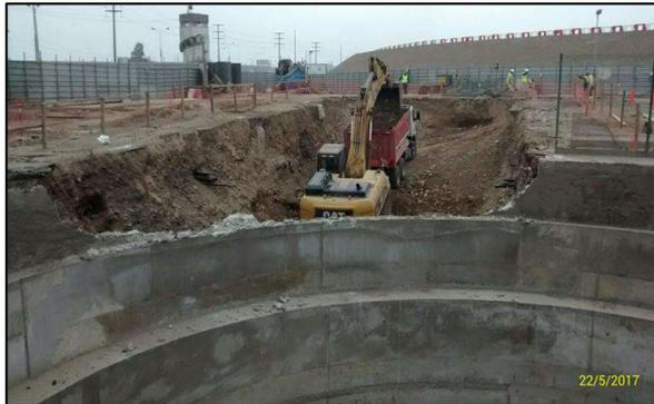
**FIG . A114:** La imagen muestra los trabajos de excavación para cámara de ventilación - PV23
