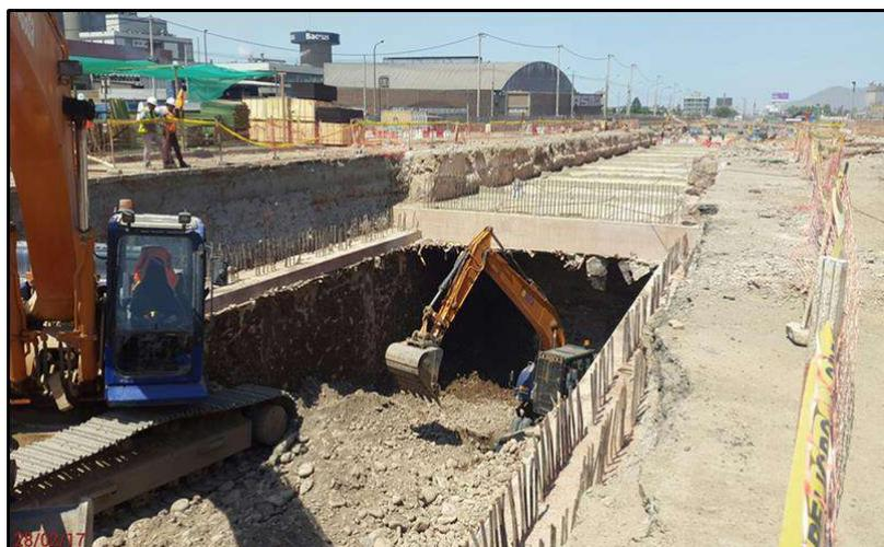
**FIG . A74:** En la foto se aprecia la excavación bajo losa de cubierta Estación E24 - Mercado Santa Anita
