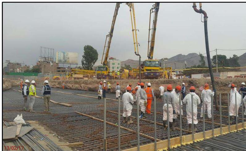
**FIG . A73:** Se observa el vaciado de concreto para losa de cubierta Estación E24 - Mercado Santa Anita
