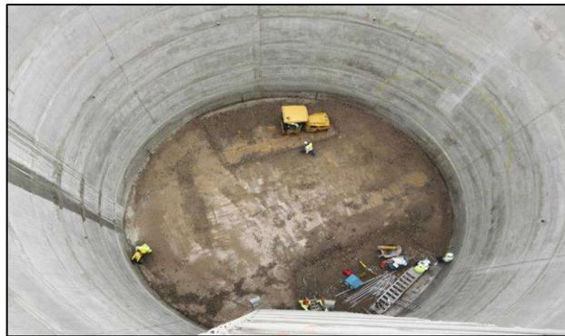
**FIG . A90:** Se observa la compactación del terreno, finalizado la construcción del anillo 7B del PV21
