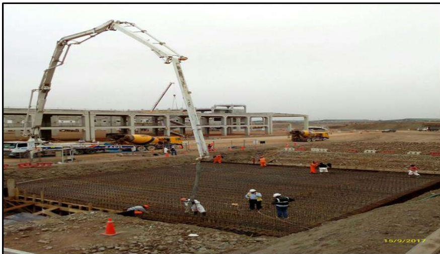
**FIG . A62:** Apreciamos los trabajos de vaciado de concreto para cubierta del Pozo de Ataque - PTSA
