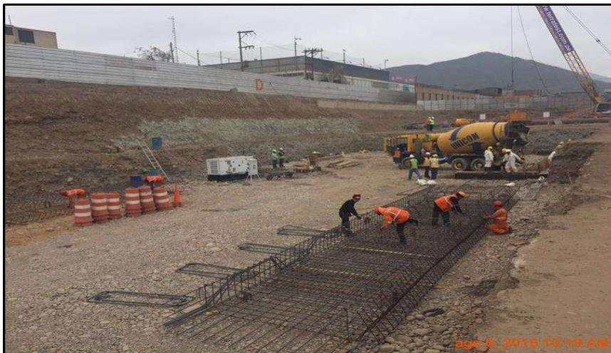
**FIG . A14:** Vista del armado del acero de refuerzo de la pantalla del Pozo de Ataque
