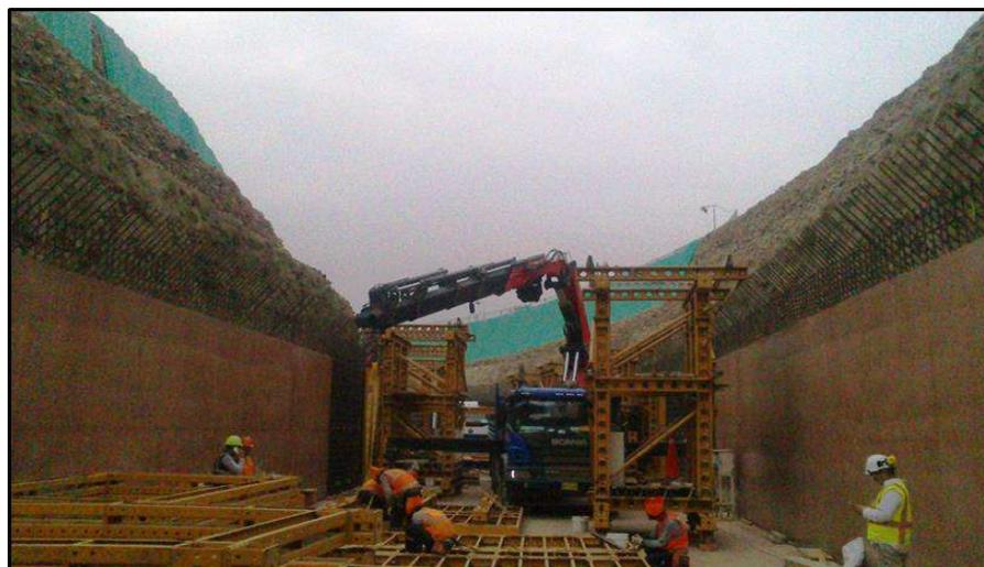
**FIG . A33:** Se puede apreciar los trabajos de desencofrado de hastiales en Falso Túnel - Túnel Ramal
