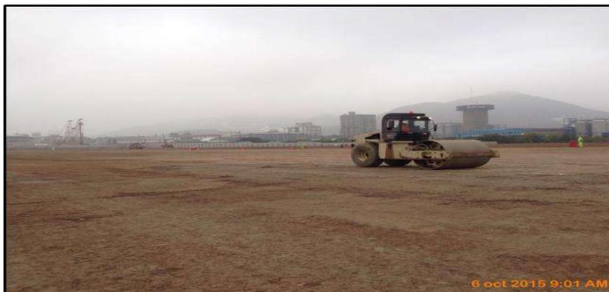
**FIG . A2:** Se observa la compactación del relleno - Patio Taller Sta. Anita
