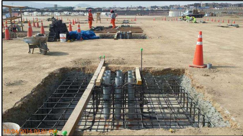
**FIG . A4:** Vistas de armado de acero de zapata y pedestal - Nave de Material Rodante - PTSA
