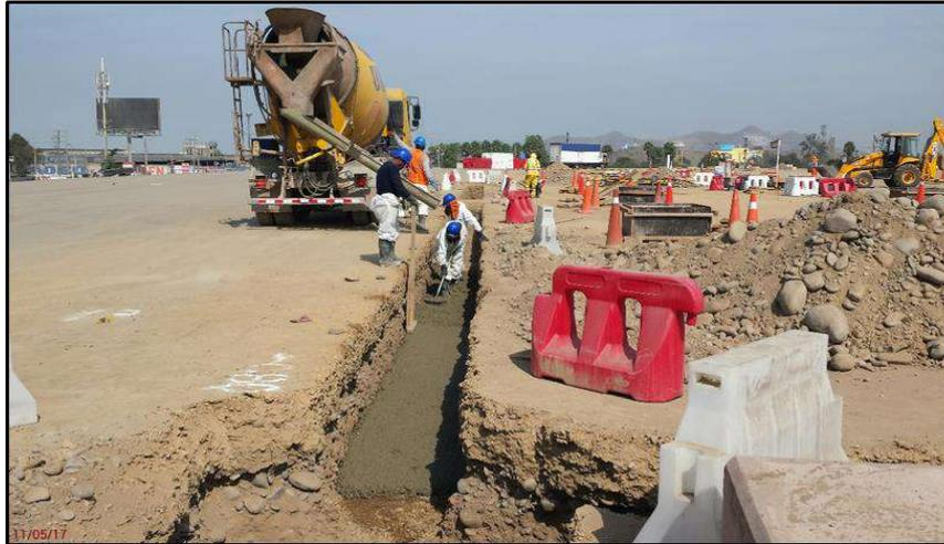
**FIG . A46:** Se observan los trabajos de vaciado de concreto para canalizaciones eléctricas - PTSA
