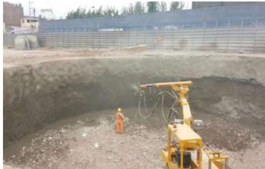
**FIG . A86:** Observamos la colocación de concreto proyectado en PV21
