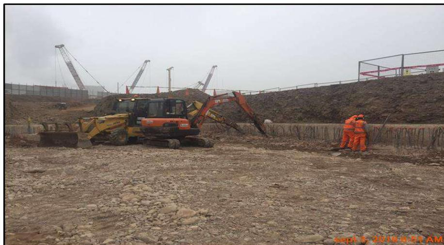
**FIG . A18:** Trabajos de descabezado de pantallas - Pozo de Ataque
