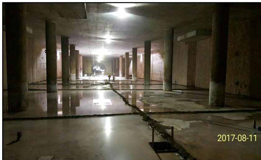
**FIG . A82:** Apreciamos los trabajos de curado de concreto en losa de fondo E-23 Hermilio Valdizán
