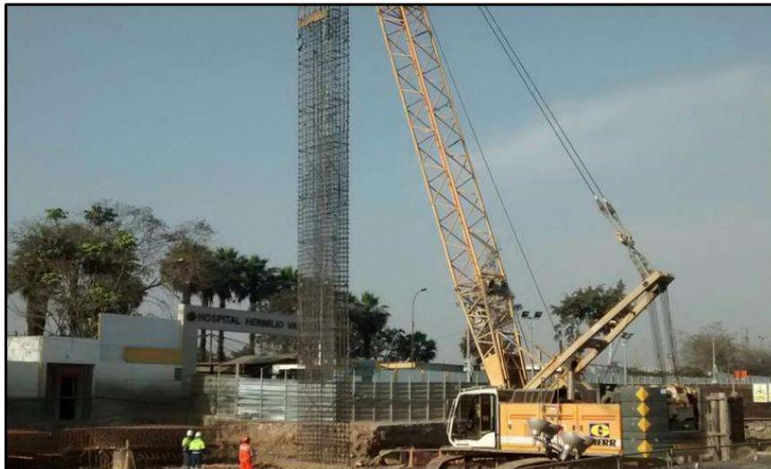
**FIG . A69:** Se puede apreciar el izaje de la armadura del muro pantalla Estación E24 - Mercado Santa Anita
