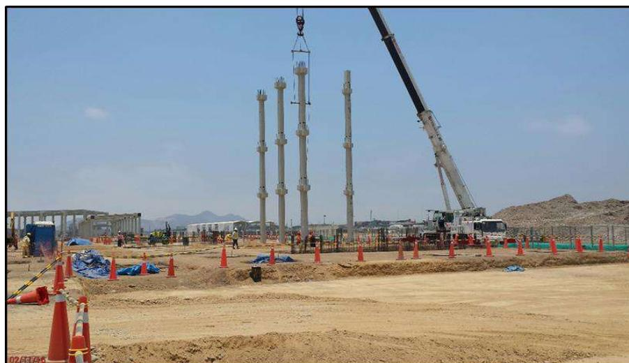
**FIG . A24:** Montaje de Pilares Edificio de Oficinas - PTSA
