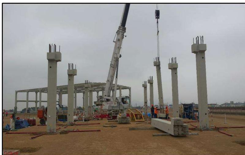
**FIG . A21:** Observamos el montaje de columnas prefabricadas - Edificio Técnico – PTSA
