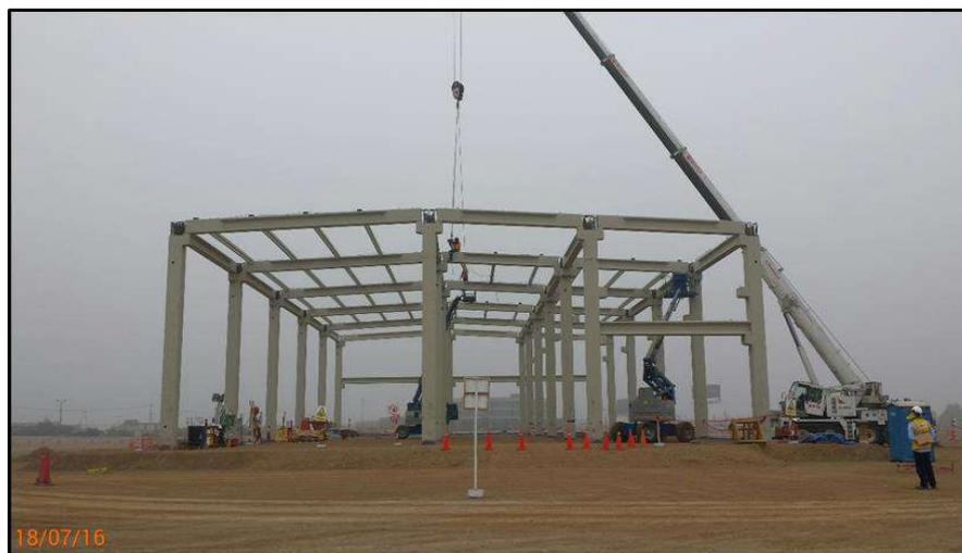
**FIG . A11:** Se observa el montaje de correas prefabricadas (viguetas) - Nave de Material Rodante
