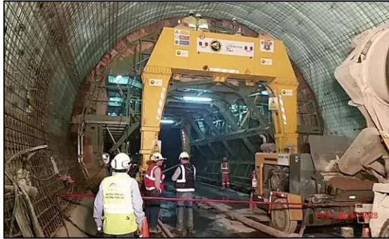
**FIG . A109:** Observamos la colocación de concreto para revestimiento secundario con carro de avance
