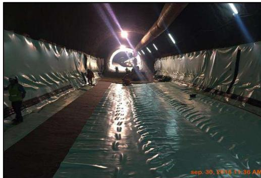
**FIG . A106:** Imagen de la colocación de la lámina de PVC para la impermeabilización del Túnel - PV23
