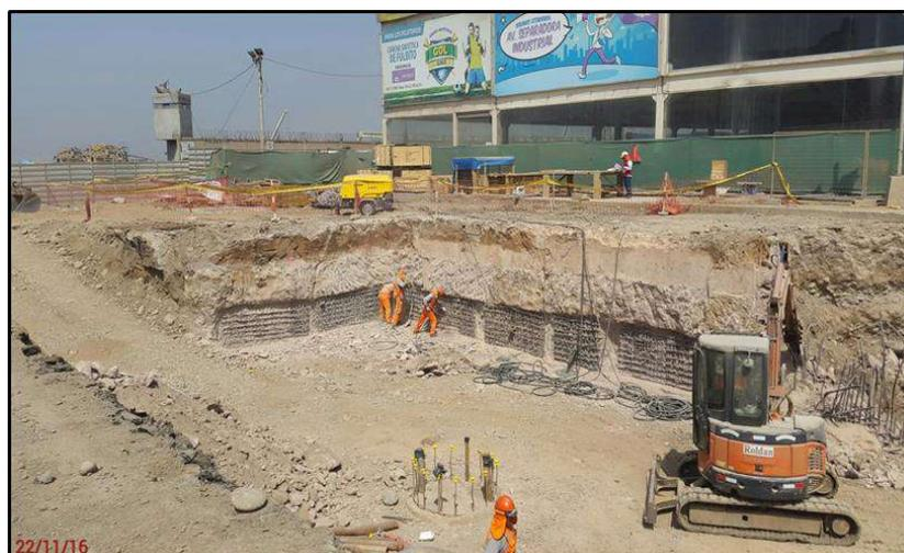
**FIG . A71:** Se observa el picado de muro pantalla para posterior anclaje y vaciado de losa cubierta
