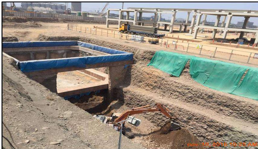
**FIG . A26:** Se observan los trabajos de excavación para el pozo de ataque - Túnel Ramal
