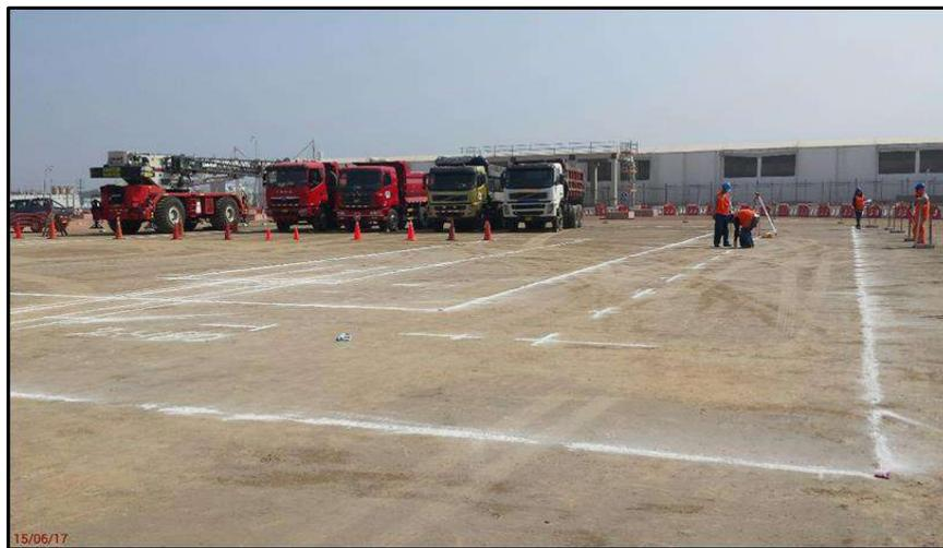
**FIG . A50:** Apreciamos los trabajos de trazo y replanteo para la SEAT – PTSA
