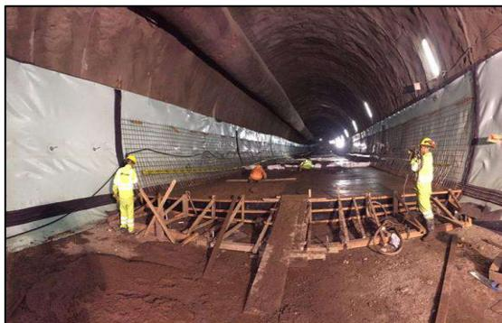
**FIG . A108:** Se aprecia el vaciado de concreto de losa de contrabóveda del túnel convencional
