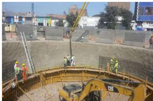
**FIG . A88:** Se observa el vaciado de concreto en la etapa 1 del anillo 1, del PV21
