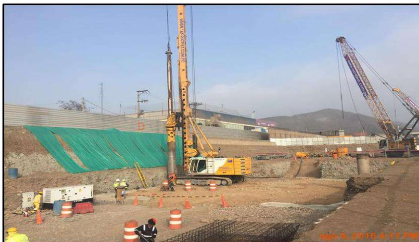
**FIG . A15:** Vista de la excavación para la construcción de muro pantalla - Túnel Ramal
