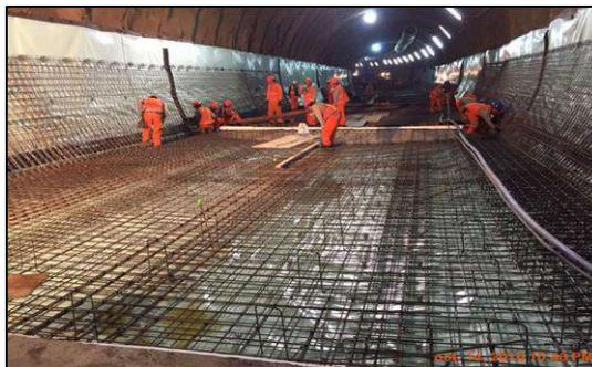
**FIG . A107:** Se observan trabajos de armado del acero de refuerzo para contrabóveda en el túnel convencional con el método NATM
