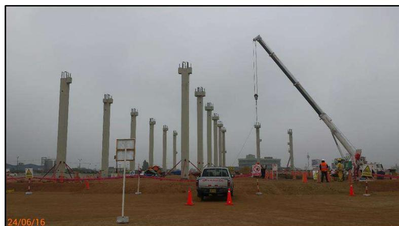
**FIG . A9:** Vista de las columnas prefabricadas montadas - Nave de Material Rodante
