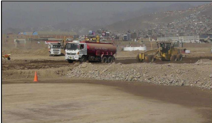
**FIG . A1:** Se observan trabajos de nivelación de terreno - Patio Taller Sta.Anita
