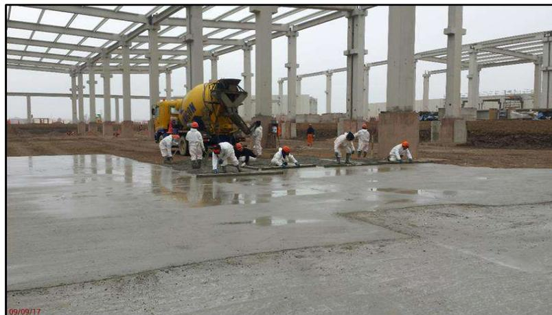
**FIG . A59:** Se aprecia trabajos de vaciado de concreto para solado de losa de piso - Nave Taller Principal - PTSA
