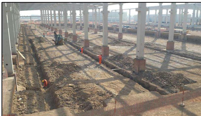
**FIG . A57:** Trabajos de excavación de zanja para instalación de malla para puesta a tierra Nave Taller Principal
