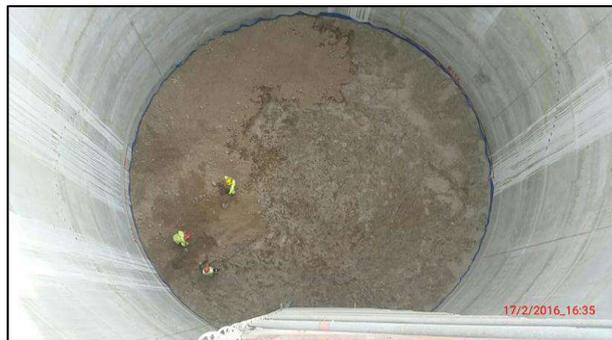
**FIG . A94:** En la foto se ven los trabajos de protección de la losa de fondo del PV21
