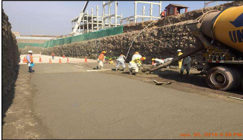
**FIG . A28:** Observamos el vaciado de concreto para solera de la trinchera -
