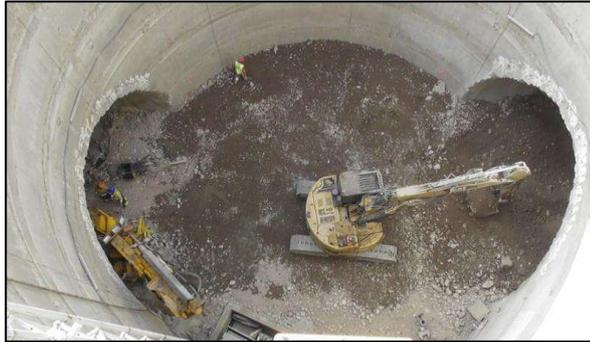
**FIG . A101:** Se observa en la foto la excavación del túnel convencional con el método NATM
