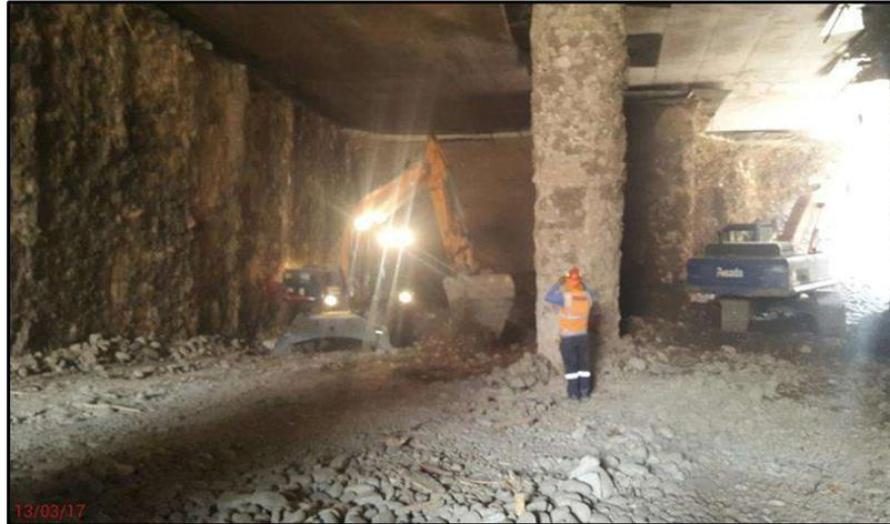
**FIG . A75:** En la foto apreciamos la excavación bajo losa de cubierta Estación E24 - Mercado Santa Anita
