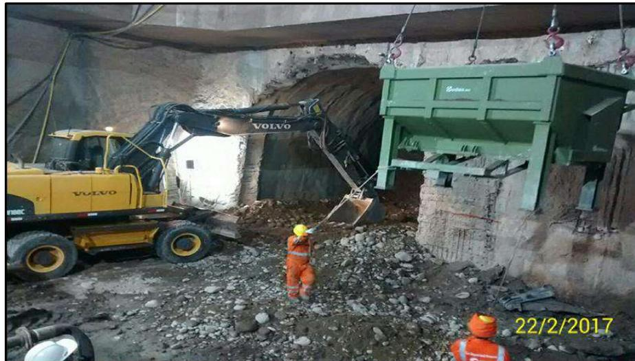
**FIG . A37:** Observamos trabajos de excavación en el Túnel Ramal Acceso PTSA
