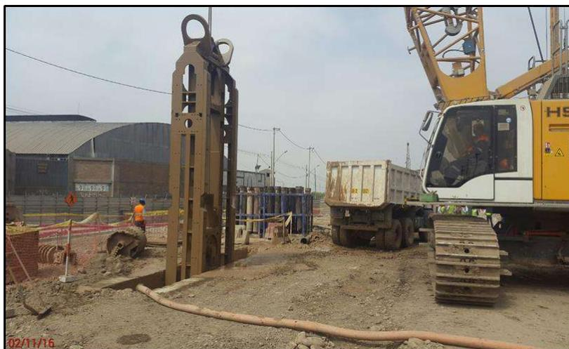
**FIG . A68:** Observamos los trabajos de excavación para el muro pantalla
