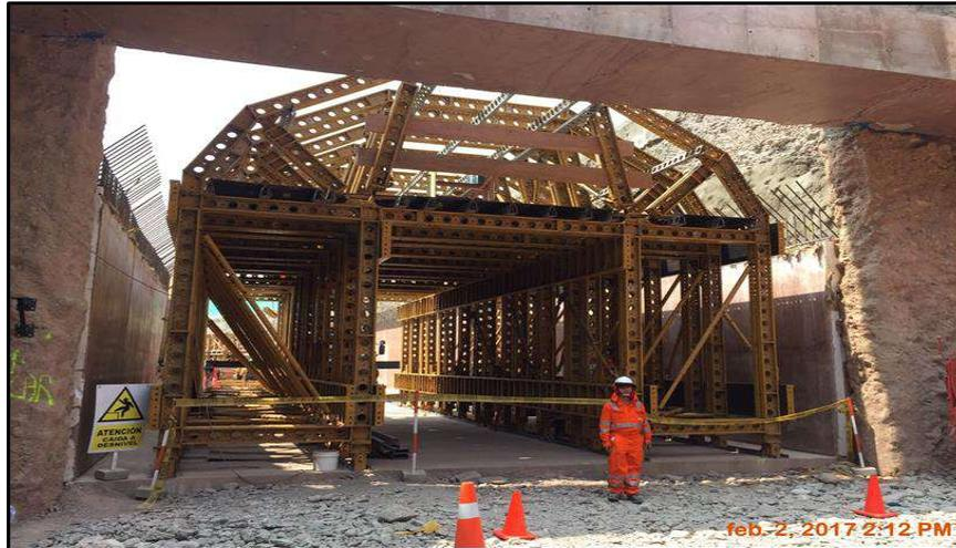
**FIG . A34:** Observamos el encofrado bóveda para Falso Túnel - Túnel Ramal Acceso - PTSA
