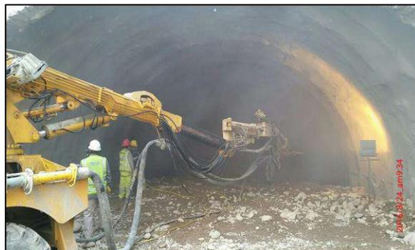
**FIG . A100:** Aquí se observa la colocación de shotcrete en el túnel convencional
