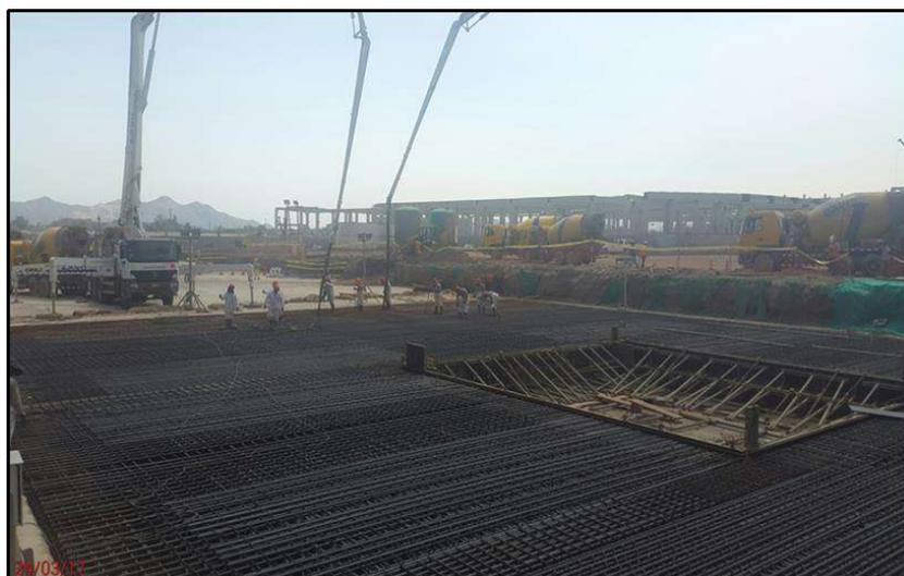
**FIG . A77:** Vista panorámica de los trabajos de vaciado de concreto para losa de cubierta Estación E24 - Mercado Santa Anita
