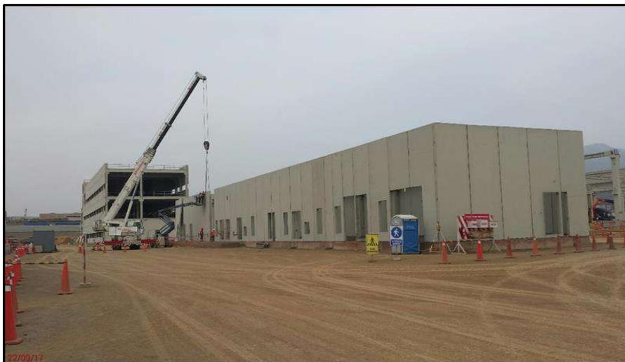
**FIG . A65:** Vista de trabajos de montaje de paneles prefabricados para fachada - Edificio Técnico - PTSA
