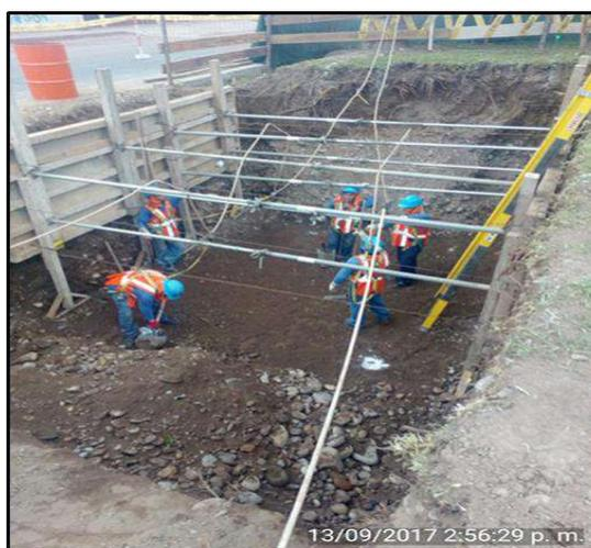
**FIG . A63:** Se observan trabajos de excavación para cámara de empalme de la LT 1x60kV en la Av. Huarochirí.
