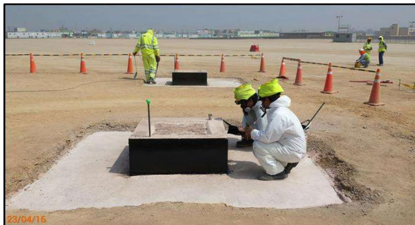
**FIG . A5:** Observamos la aplicación de pintura bituminosa en pedestales - Nave de Material Rodante – PTSA
