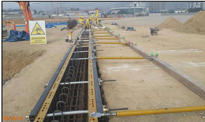
**FIG . A7:** Vista de armado de cemento corrido - Nave de Material Rodante - PTSA
