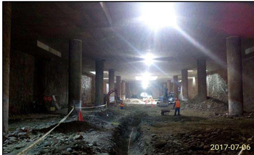
**FIG . A81:** En esta foto se observan los trabajos de excavación para puesta a tierra en losa de fondo E-23 Hermilio Valdizán
