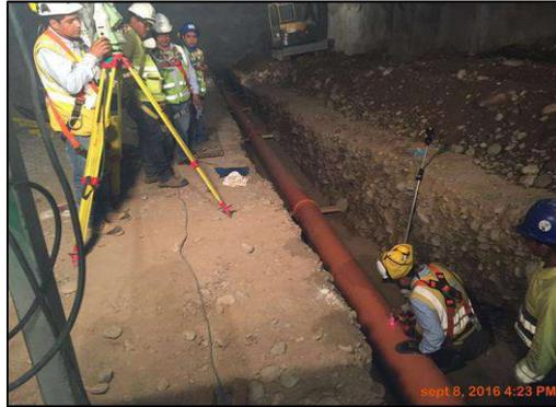
**FIG . A105:** Se observan los trabajos de nivelación de la tubería de drenaje en el túnel convencional
