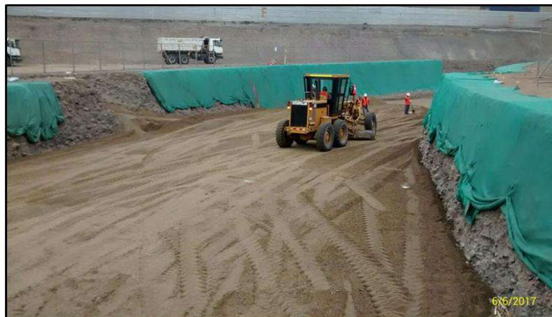
**FIG . A48:** Observamos los trabajos de relleno de Falso Túnel Sección Bóveda - Túnel Ramal Acceso PTSA
