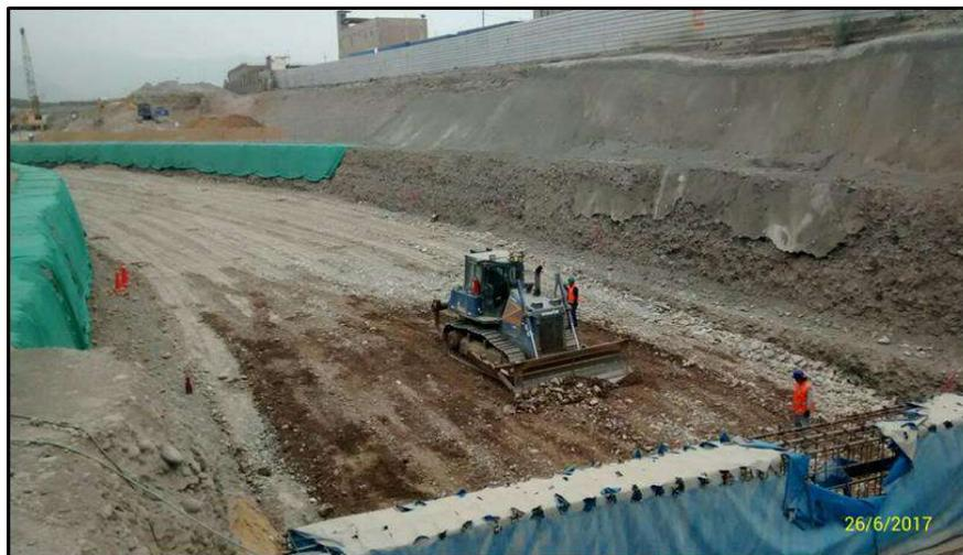
**FIG . A53:** Trabajos de relleno en Sección Bóveda - Falso Túnel Ramal Acceso PTSA
