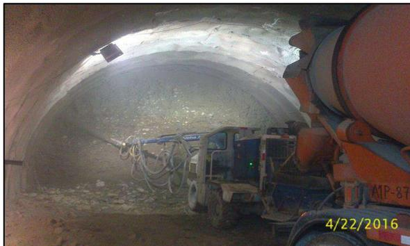
**FIG . A102:** Apreciamos la colocación de shotcrete en el túnel convencional
