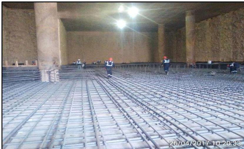
**FIG . A76:** Se observan los trabajos de armado de acero de losa de vestíbulo E-23 Hermilio Valdizán
