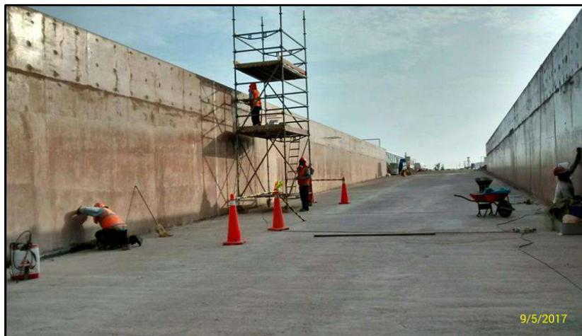
**FIG . A44:** Se puede apreciar trabajos de resanes en Trinchera - Túnel Ramal Acceso PTSA
