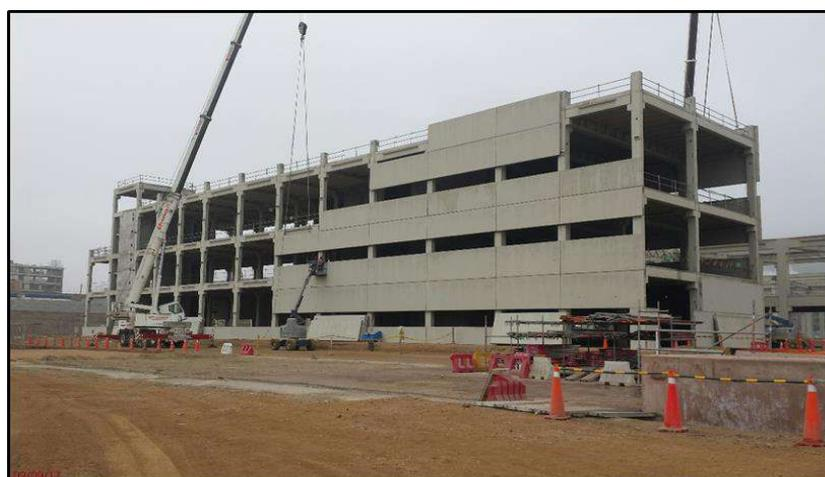
**FIG . A60:** Se aprecian trabajos de montaje de paneles para fachada - Edificio de Oficinas - PTSA
