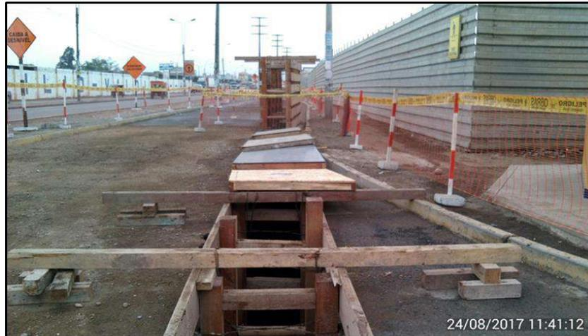
**FIG . A58:** Se puede observar los avances de las obras de excavación de la Línea de Transmisión 60 KV en la Av. Cultura rumbo a la SEAT - MSA (Mercado Santa Anita)
