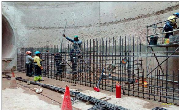
**FIG . A118:** Observamos los trabajos de armado de acero para muros longitudinales
