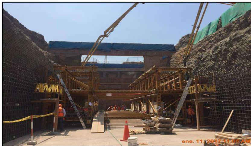
**FIG . A32:** Trabajos de vaciado de concreto de hastiales para Falso Túnel - Túnel Ramal
