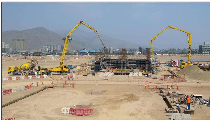
**FIG . A56:** Vista panorámica del vaciado de concreto para muros corta fuego del primer nivel - SEAT - PTSA
