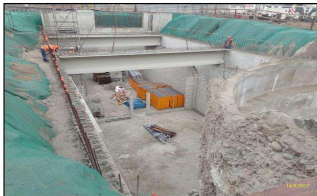
**FIG . A123:** Observamos los trabajos de montaje de vigas en la cámara de ventilación de Pozo - PV23 FASE II
