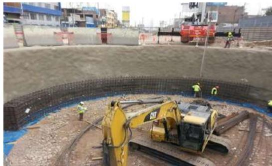
**FIG . A87:** Aquí vemos la colocación de acero de refuerzo en el anillo 1, del PV21
