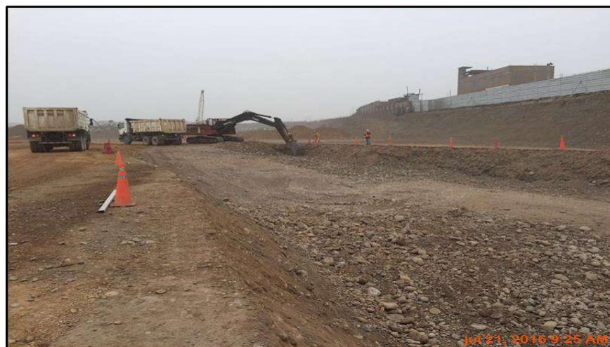
**FIG . A12:** Vista de la excavación de pozo de ataque para inicio de construcción de Falso Túnel
