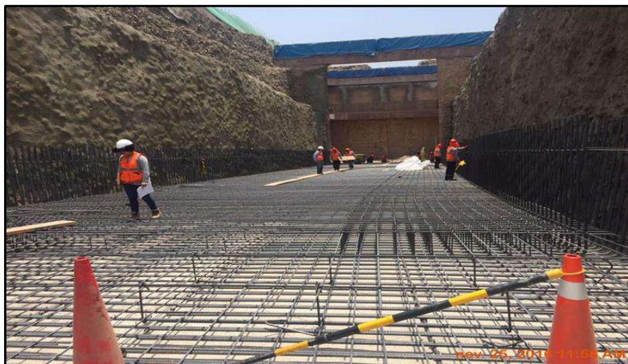
**FIG . A27:** Se observan los trabajos de armado del acero de refuerzo de losa en el Falso Túnel - Túnel Ramal
