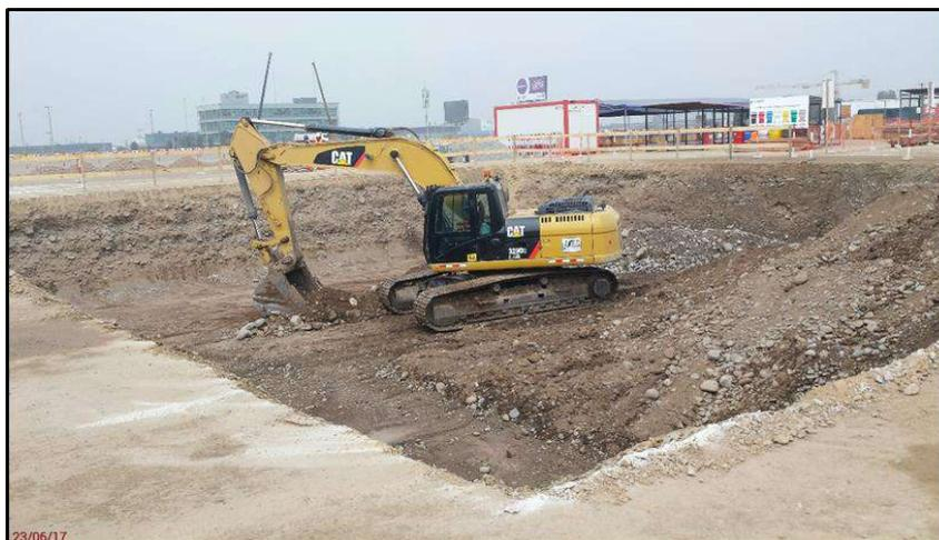
**FIG . A51:** Se observan trabajos de excavación para cimentación de la SEAT - PTSA
