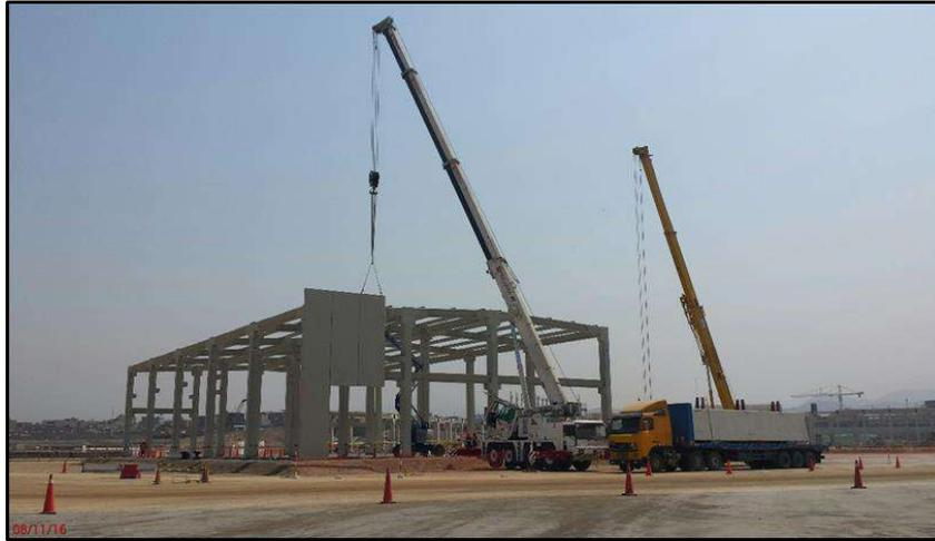
**FIG . A25:** Vista de trabajos de montaje de paneles para cobertura - Nave Material Rodante
