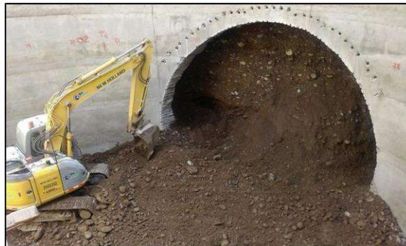
**FIG . A98:** Se observa en la foto la excavación del túnel convencional con el método NATM desde el lado Callao del entronque Pozo - Túnel en el PV20
