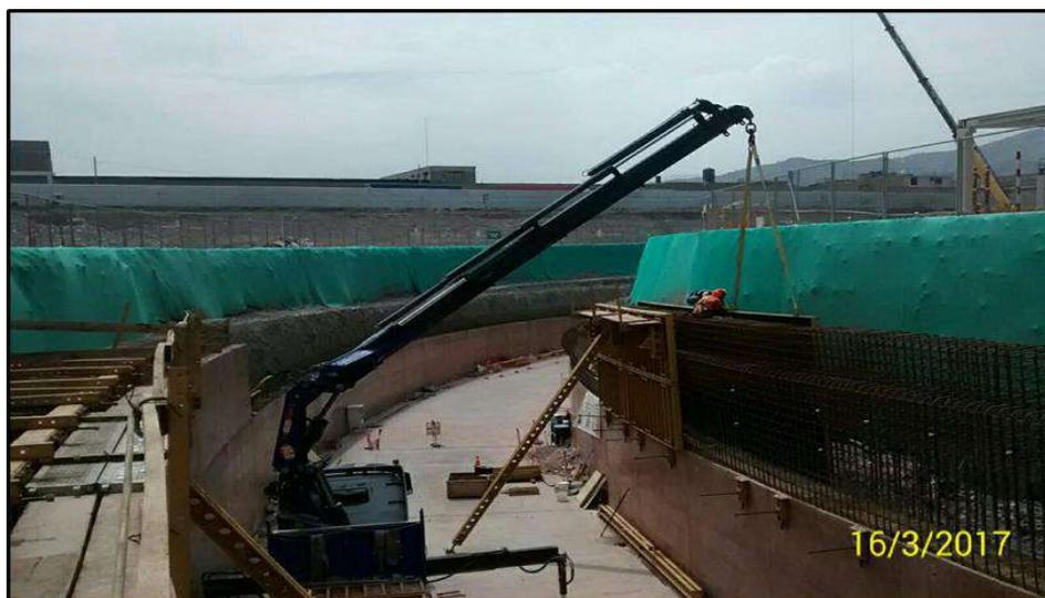
**FIG . A39:** Vista del encofrado para hastiales Falso Túnel - Túnel Ramal Acceso PTSA
