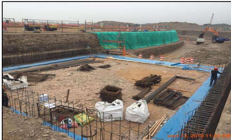
**FIG . A20:** Armado del acero de refuerzo de la viga de coronación del Pozo de Ataque
