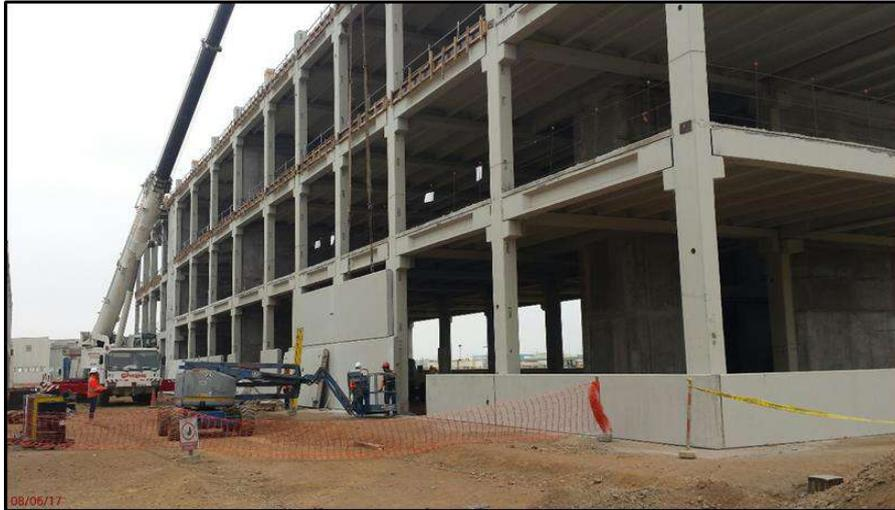
**FIG . A49:** Se observa el montaje de paneles para cobertura exterior - Edificio de Oficinas - PTSA
