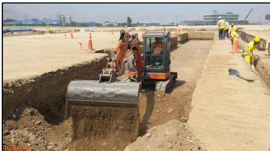
**FIG . A6:** Se observa la excavación para vía en foso - Nave Material Rodante – PTSA
