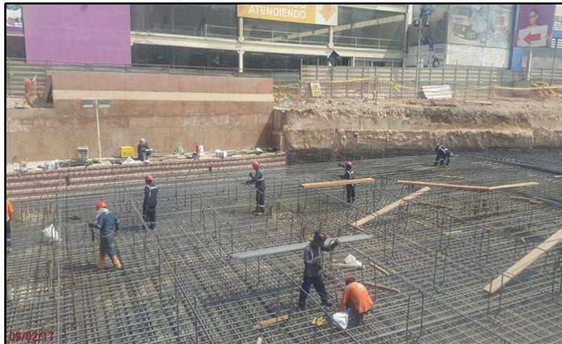
**FIG . A72:** Se aprecian los trabajos de armado de acero para losa de cubierta Estación E24 - Mercado Santa Anita
