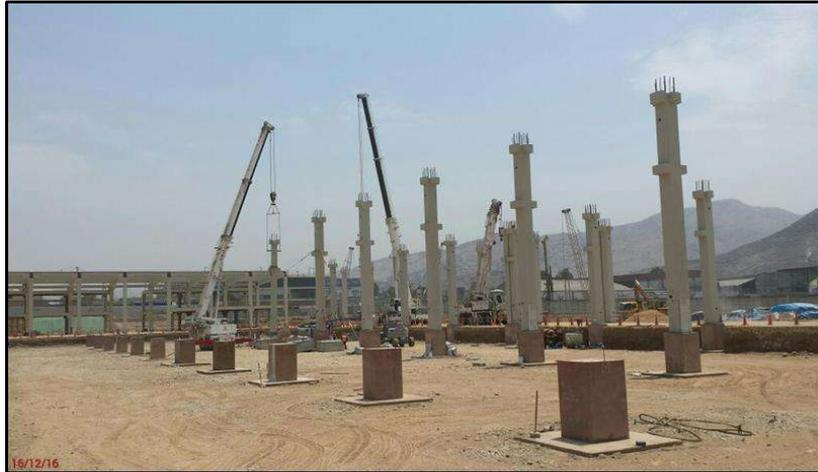
**FIG . A31:** Se aprecian los trabajos de montaje de columnas - Nave Taller Principal
