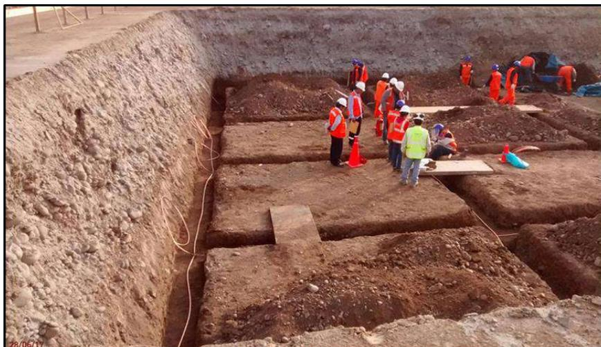
**FIG . A54:** Observamos los trabajos de instalación de malla de puesta a tierra - SEAT - PTSA
