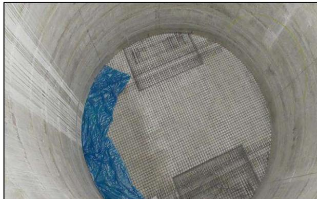
**FIG . A91:** Se aprecia el armado de acero de refuerzo en la losa de fondo en el PV 21
