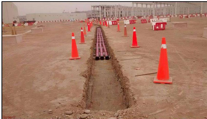
**FIG . A47:** Apreciamos la excavación y colocación de tuberías para Instalaciones ferroviarias - PTSA
