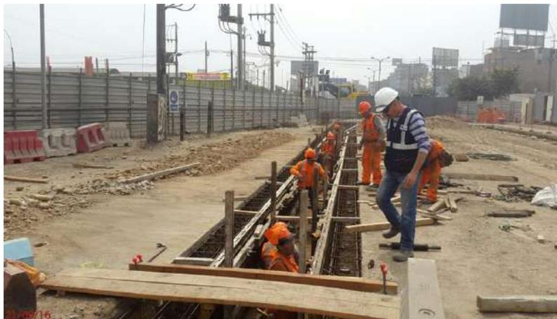
**FIG . A67:** Apreciamos el murete guía para pantalla Estación E24 - Mercado Santa Anita
