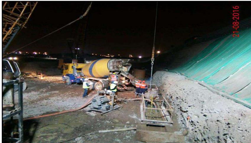
**FIG . A17:** Verificación y vaciado de concreto de pantallas para el Pozo de Ataque
