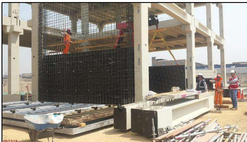
**FIG . A30:** Se observa la verificación de acero para encofrado de placa - Edificio
