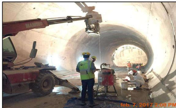
**FIG . A111:** Aquí se aprecia la colocación de inyecciones de contacto en el túnel convencional
