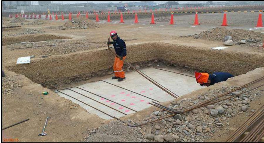
**FIG . A16:** Armado de acero para zapatas de la Nave Taller - PTSA
