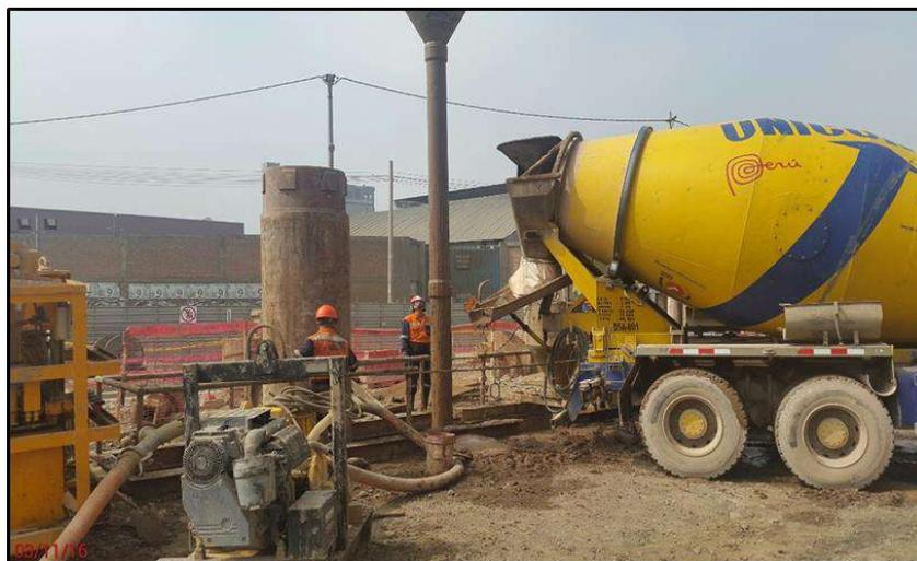
**FIG . A70:** Observamos el vaciado de concreto del muro pantalla Estación E24 - Mercado Santa Anita
