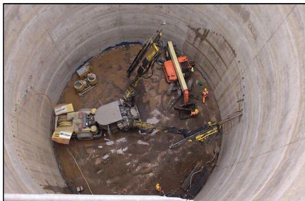
**FIG . A95:** Se aprecian los trabajos de ejecución de paraguas de micropilotes autoperforantes en el emboquille del túnel con el PV20
