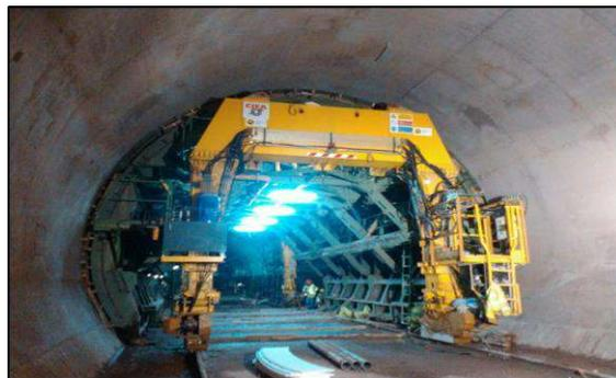
**FIG . A110:** Imagen del encofrado para revestimiento secundario en el túnel convencional
