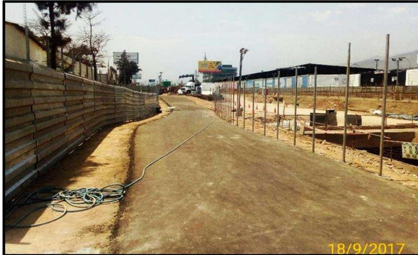
**FIG . A84:** Aquí apreciamos la Losa de Cubierta - desvío y el habilitado de cerco perimétrico
