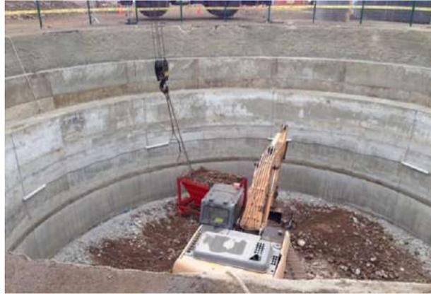
**FIG . A89:** Apreciamos trabajos de excavación para la construcción del anillo 4 del PV23
