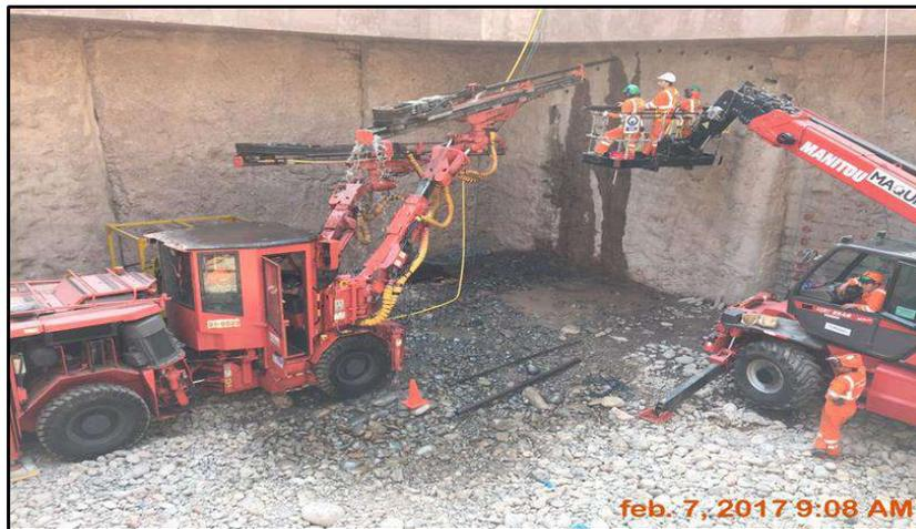
**FIG . A35:** Apreciamos trabajos de perforación para micropilotes
