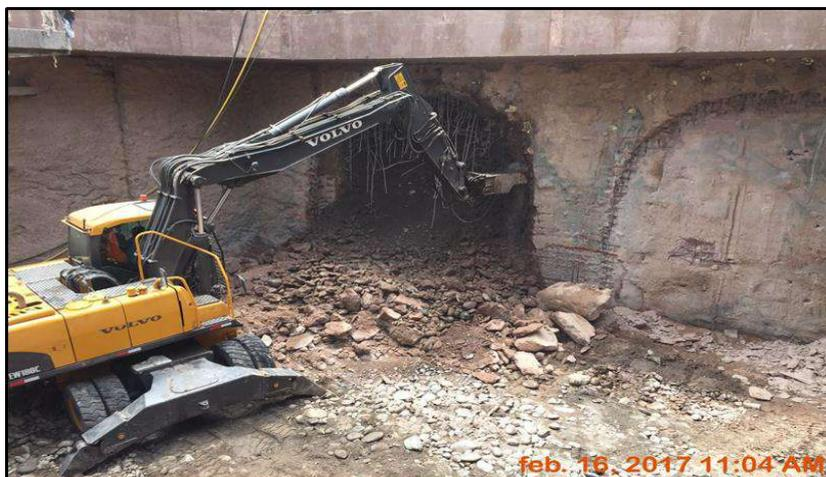
**FIG . A36:** Se observa los trabajos de demolición del entronque túnel - Túnel Ramal Acceso PTSA
