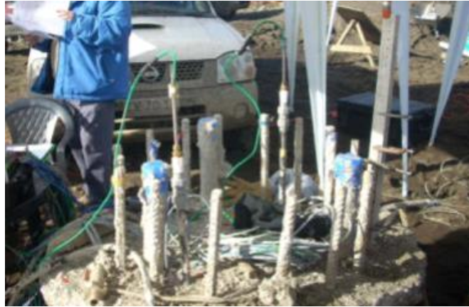
Figura N° 3.18 – Cabeza del pilote de prueba con instrumentación y cableado.
