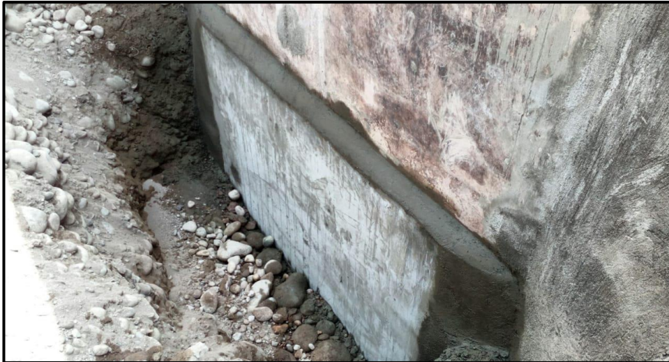
Fig.N°4.14 Vaciado de grouting como medida correctiva
