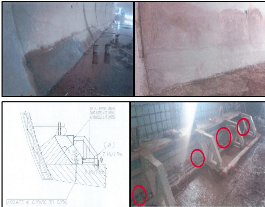
Fig.N°4.4 Vista del muro guía reparado, acomodo de pernos adicionales en los encofrados para muros guía para una mejor sujeción.
