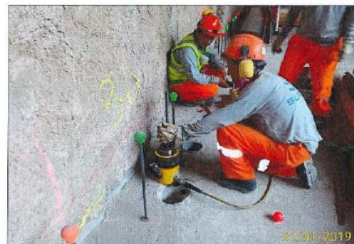
Fig.N°4.16 Control de anclajes en aceros de refuerzo
