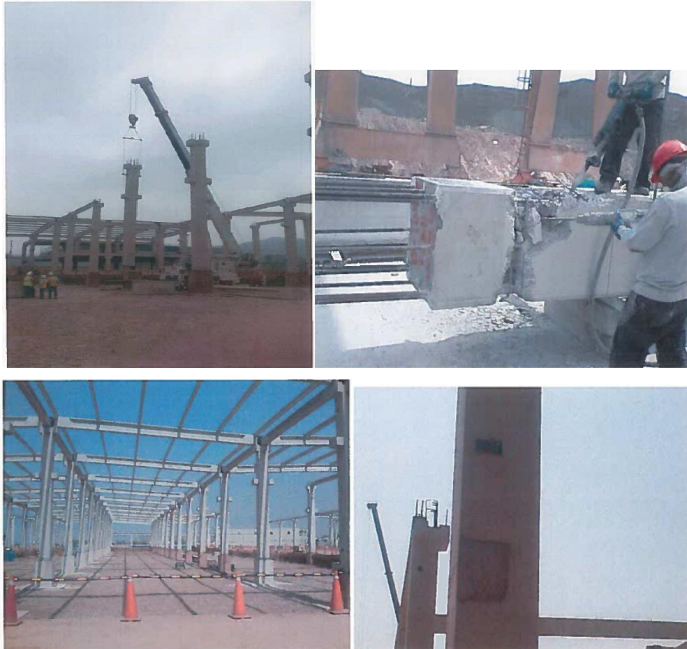
Fig.4.7 Vista de la observación en la colocación de los pilares prefabricados del Patio Taller Santa Anita (PTSA).
