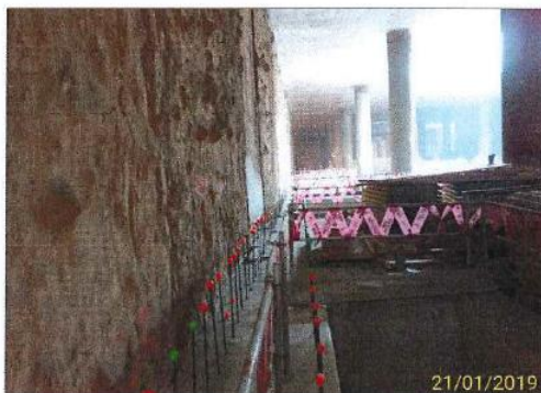
Fig.N°4.16 Control de anclajes en aceros de refuerzo
