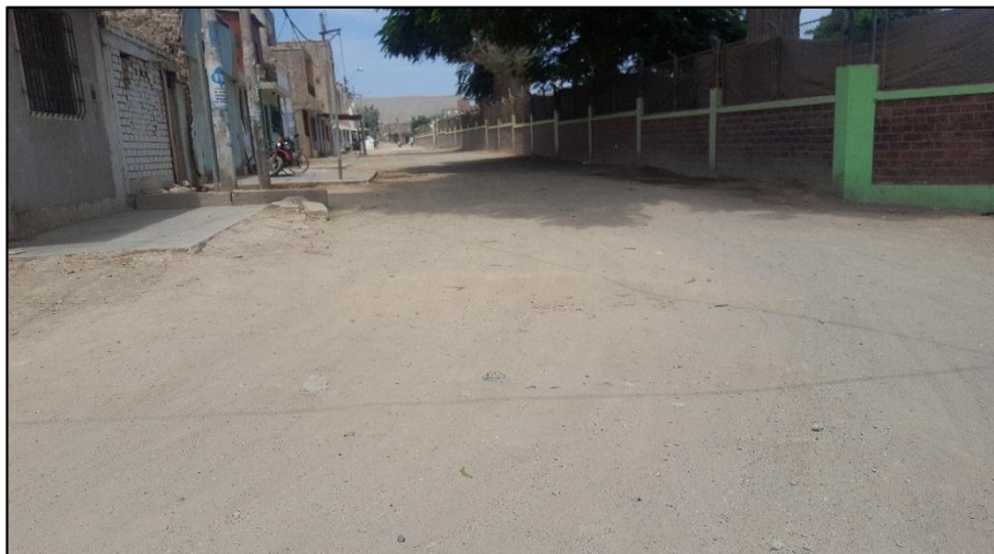
Figura N°29 Calle Alianza presenta Sección transversal impropia con Severidad Moderada. Fuente: Elaboración Propia.
