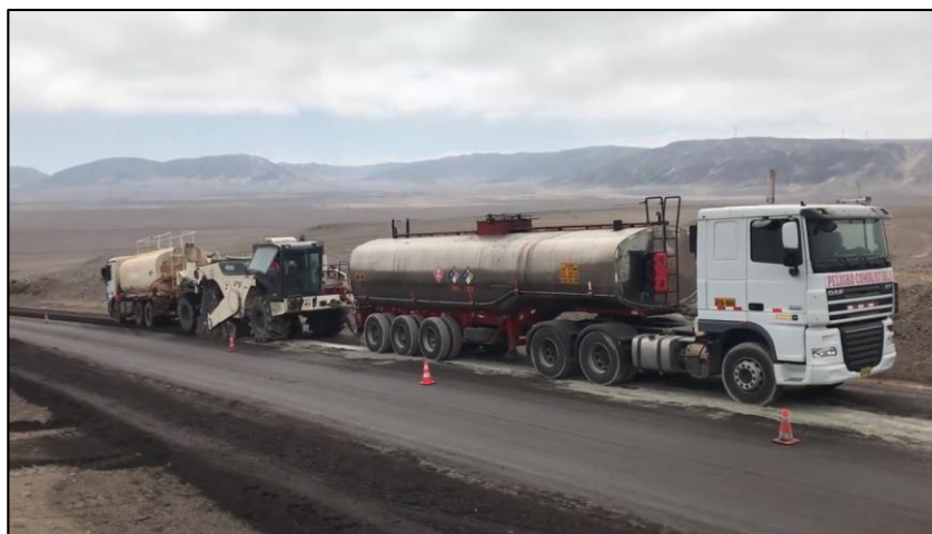
Figura N°55 Equipos para el proceso constructivo del reciclado asfáltico en frío Fuente: Elaboración propia.
