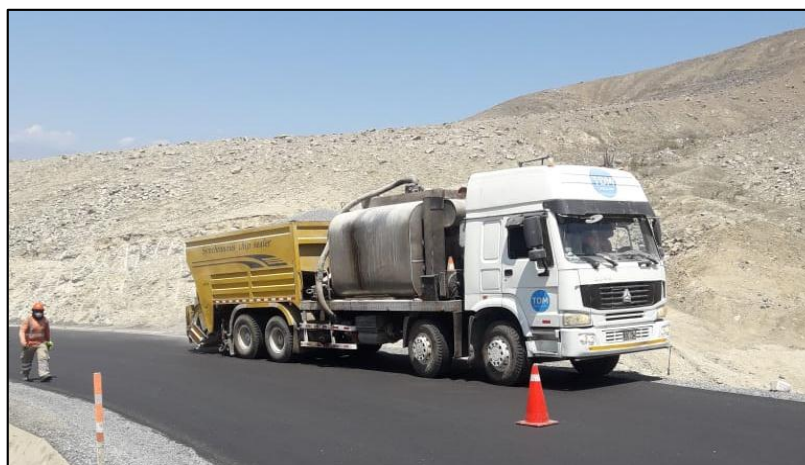
Figura N°50 Camión Chip Sealer Fuente: Elaboración propia.
