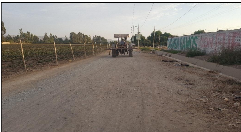
Figura N°32 Acceso a Conde Bajo presenta Polvo con Severidad Baja. Fuente: Elaboración Propia.
