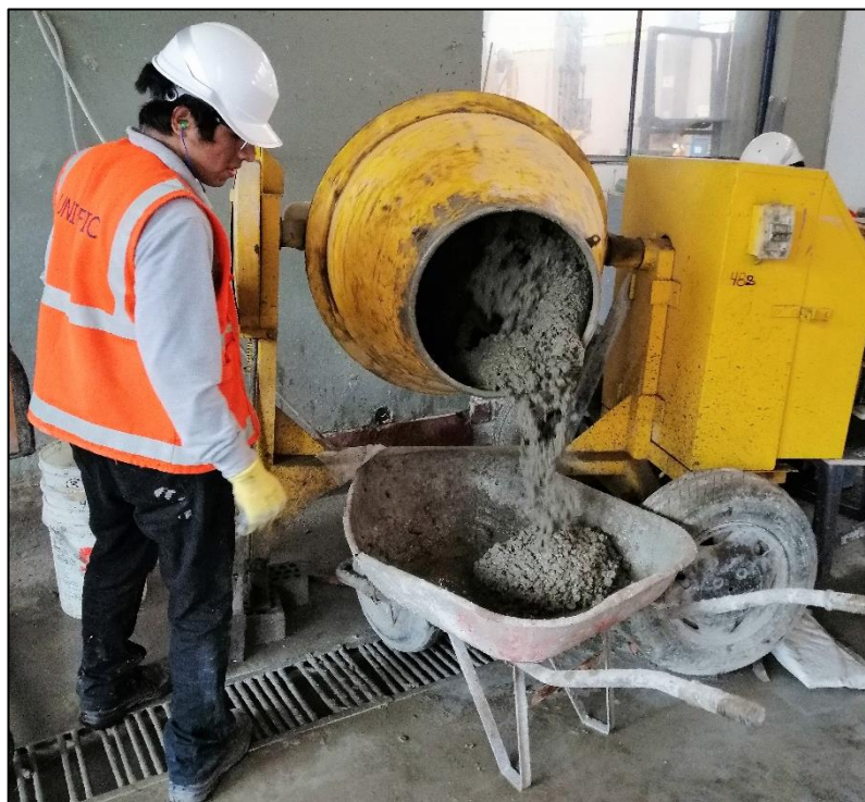
ANEXO 2. 6.- Mezclado y vaciado de la mezcla de concreto.
