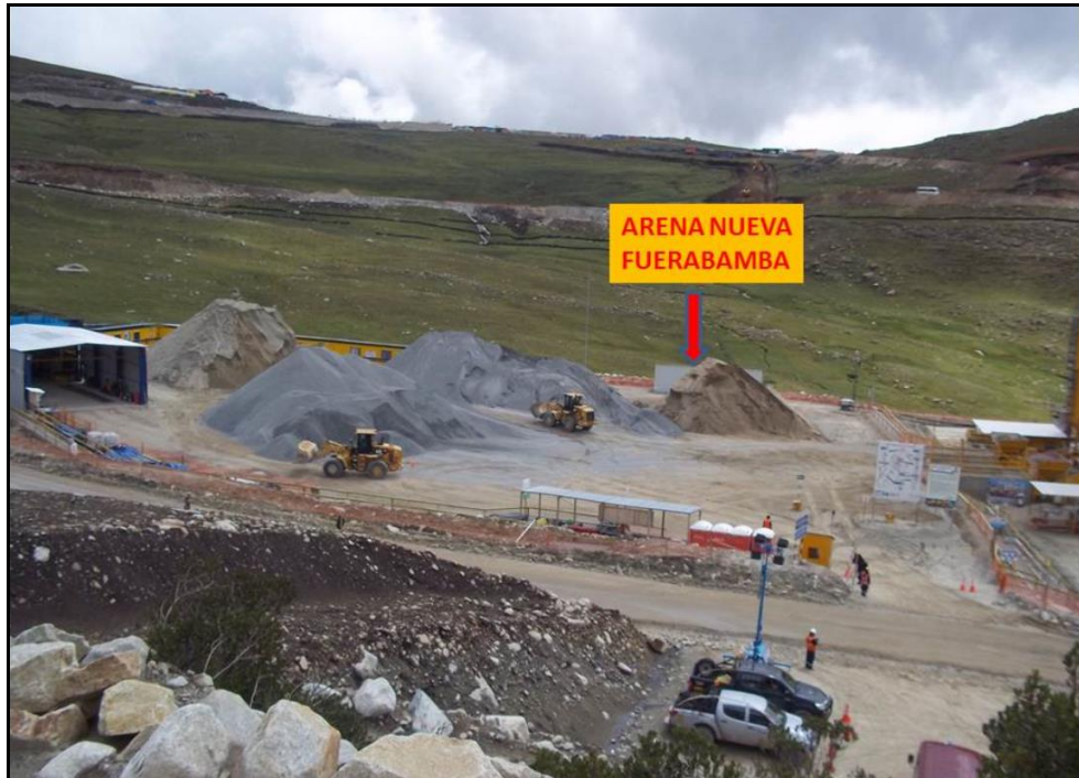
Figura 13 Foto de acopio de Agregados en Planta de Concreto. Fuente: Elaboración Propia
