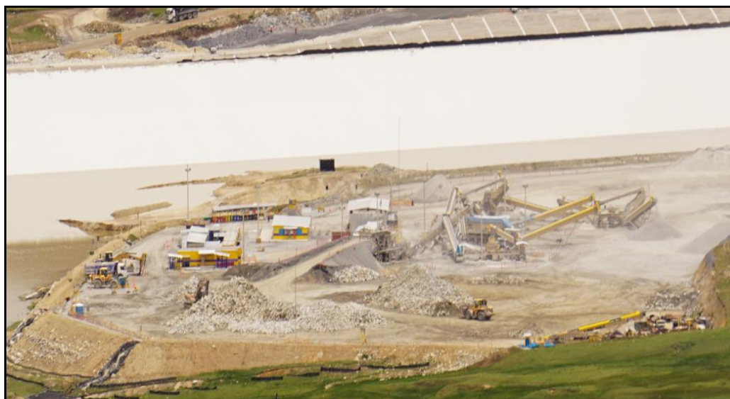
Figura 16 Foto de la distribución de la Planta de Agregados Fuente: Elaboración Propia
