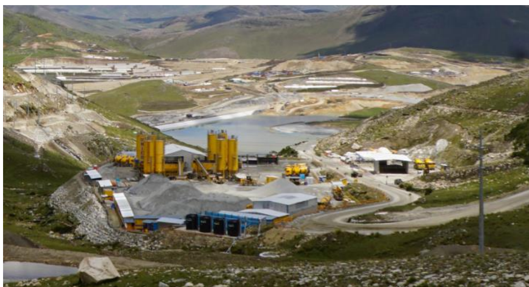
Figura 9 Foto de inicio de la Planta de Concreto.
