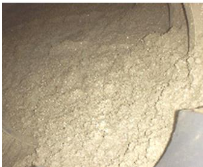
Figura 20 Inspección Visual del concreto en Planta. Fuente: Proyecto Las Bambas.
