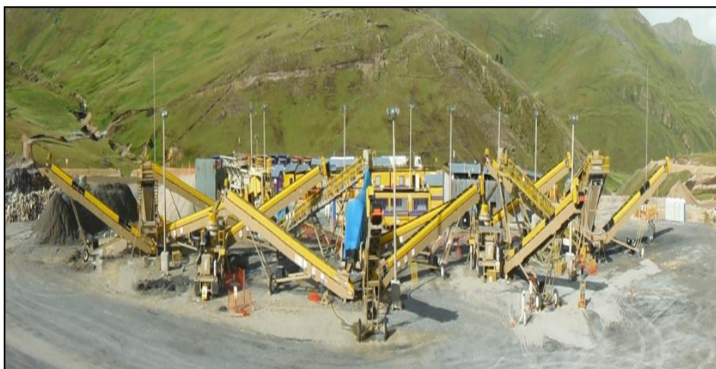
Figura 15 Foto de los equipos en la Planta de Agregados
