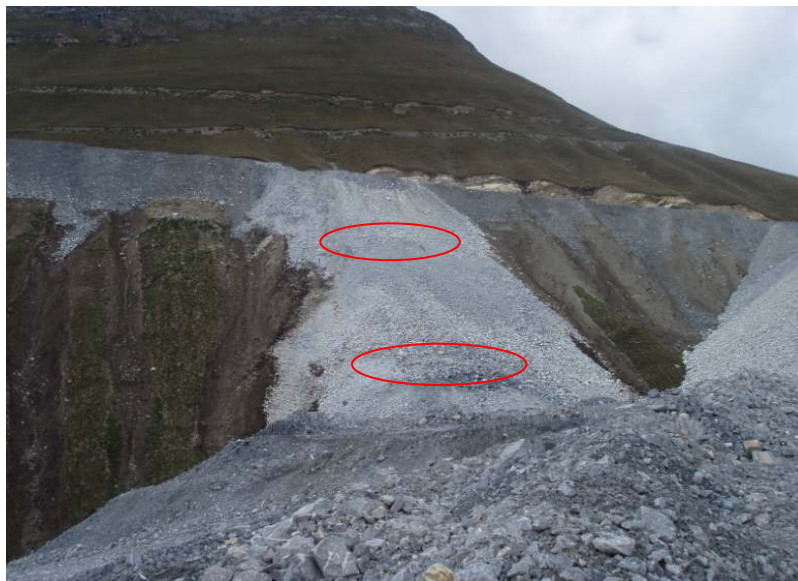
Figura 6.1 inicio de los trabajos del Botadero Tucush. (relleno a media ladera, año 2006)
