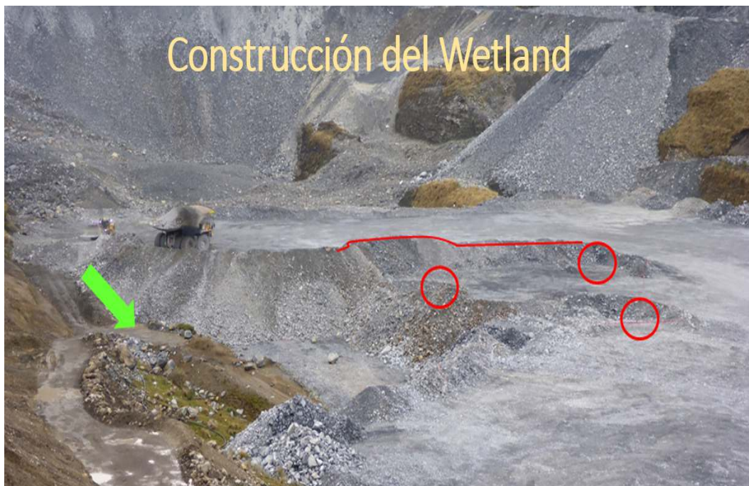
Figura 4.- Se muestra la forma como se procedió con el confinamiento del material lacustre en la capa de 10 m, con los camiones Mineros, los círculos muestran la ubicación de los piezómetros instalados para monitorear el comportamiento de la presión de poros durante la conformación de capas de confinamiento.
