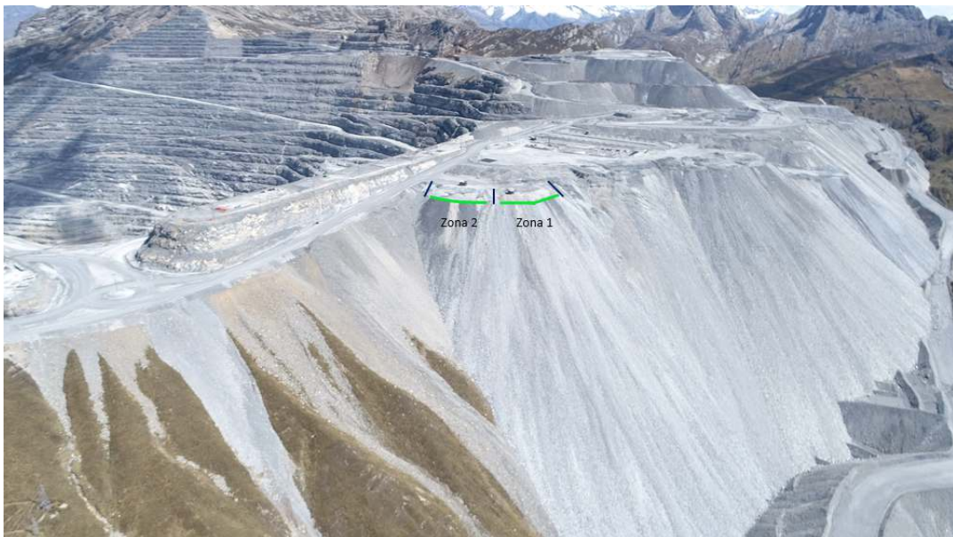
Figura 6.5 Muestra la sectorización del botadero y la instrumentación geotécnica
