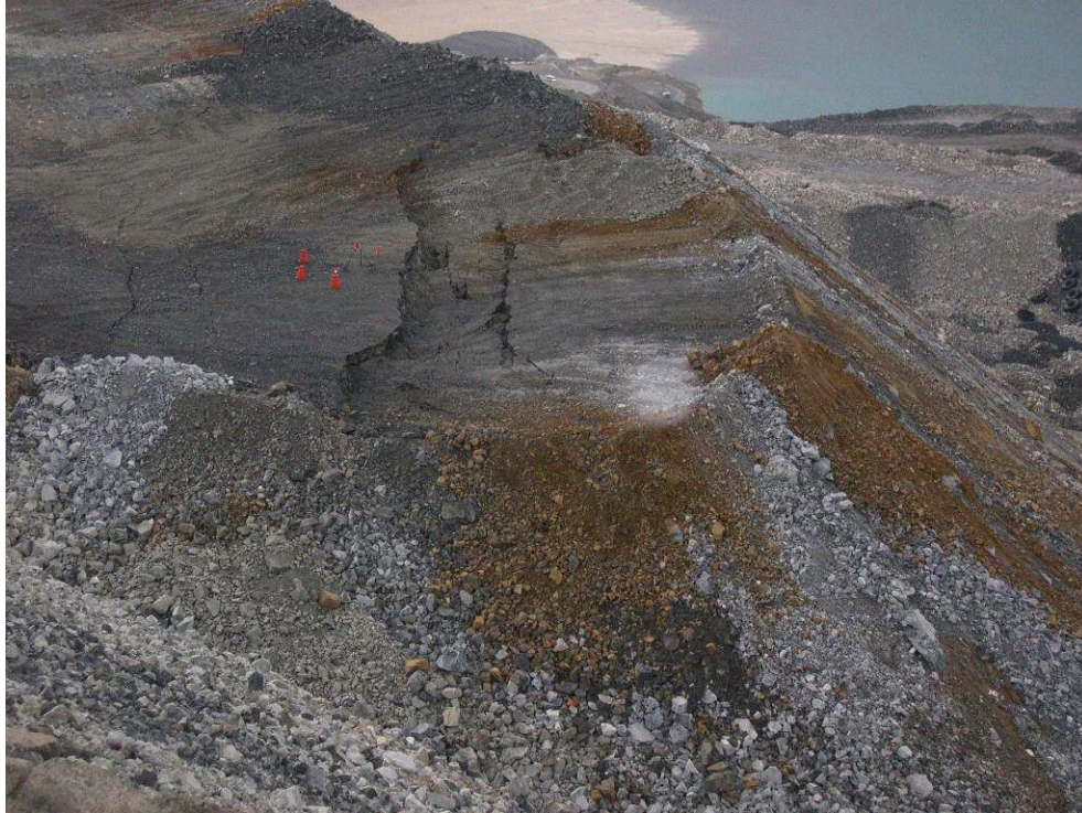
Figura 6.4 Muestra las grietas de Tracción (asentamientos) presentadas en las plataformas.
