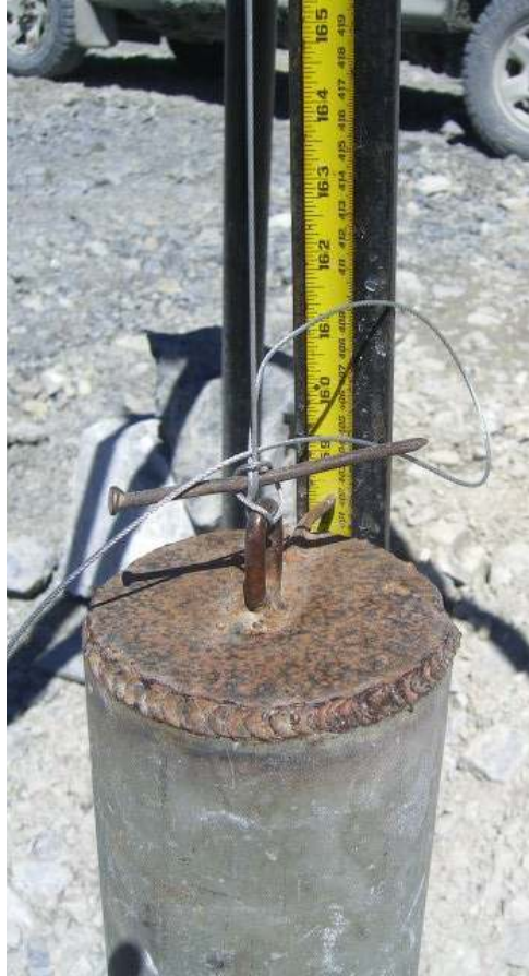
Figura 6.13 Extensómetro manual forma de lectura de desplazamientos. Fuente (CMA)
