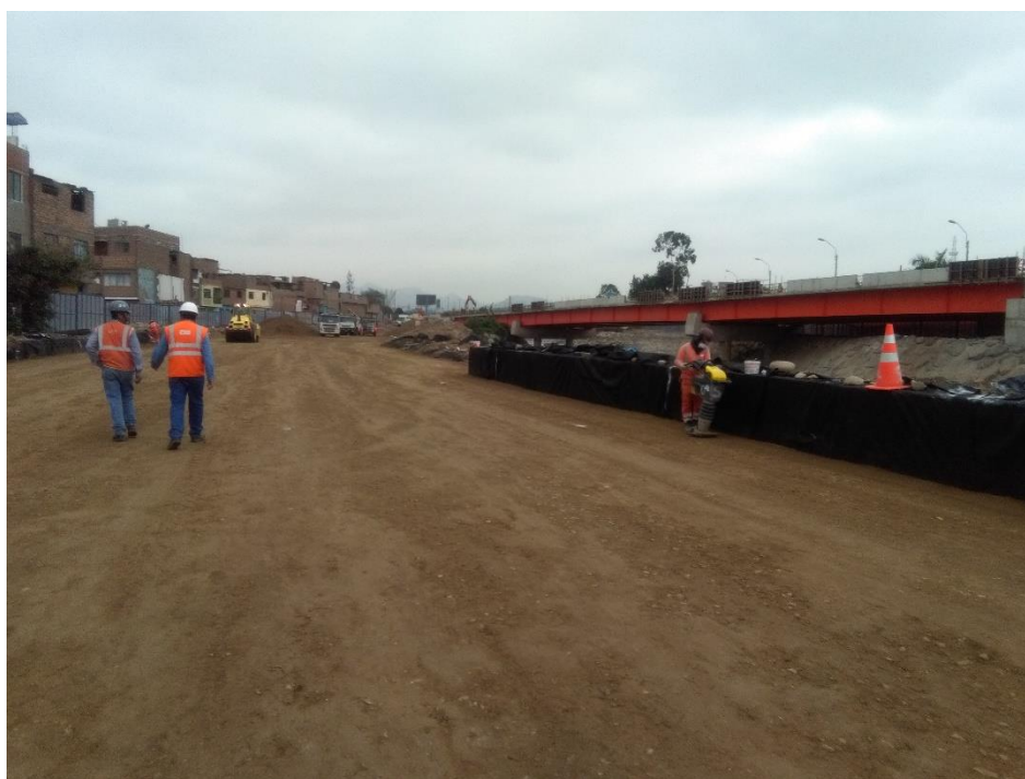
Figura 6.12. Zona liberada para dar inicio a los trabajos de relleno controlado en el viaducto 6.1, sectores 01 y 02.
