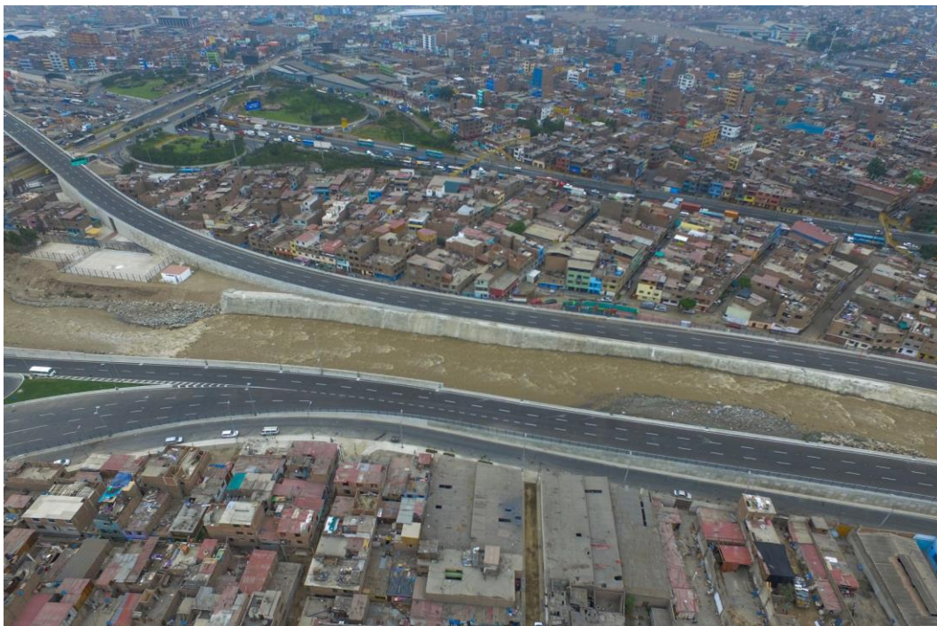
Figura 6.18. Entrega final del muro de tierra armada del viaducto 6.1.
