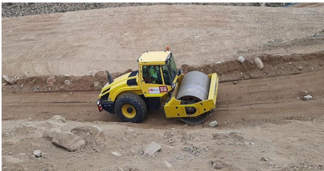
Figura 2.19. Rodillo liso vibratorio BOMAG 7 BW177 DH-5 (similar al CAT CS64B) en proceso de compactación del afirmado.
