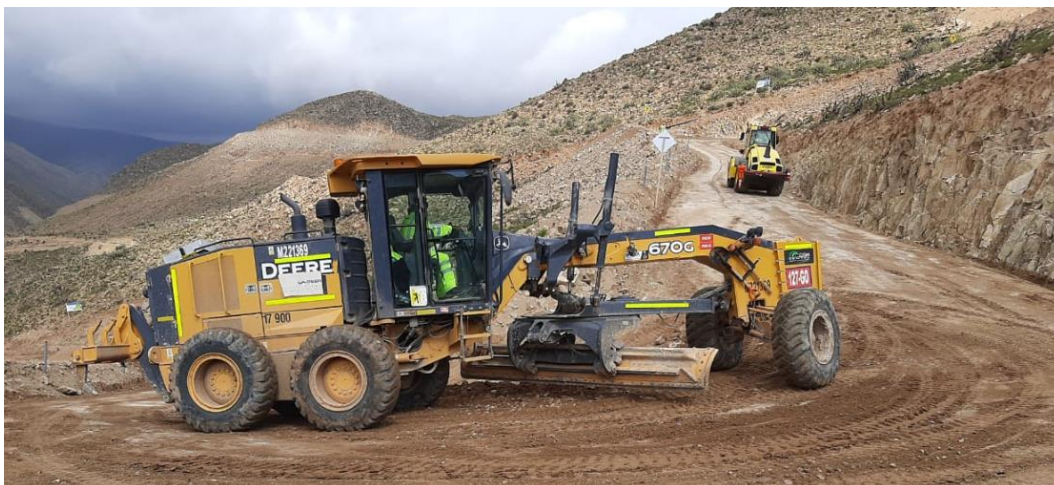
Figura 2.18. Motoniveladora John Deere 6 (similar al CAT 140K) en proceso perfilado de subrasante. Fuente: Elaboración Propia
