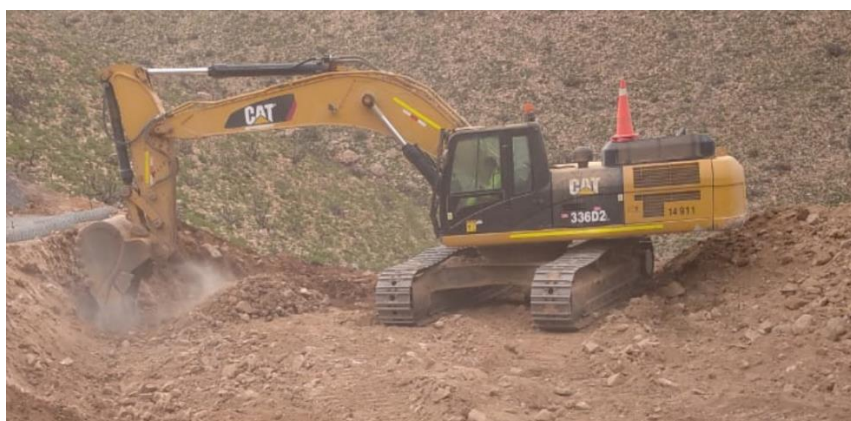
Figura 2.16. Excavadora sobre orugas Caterpillar 336DL en proceso de corte de material.
