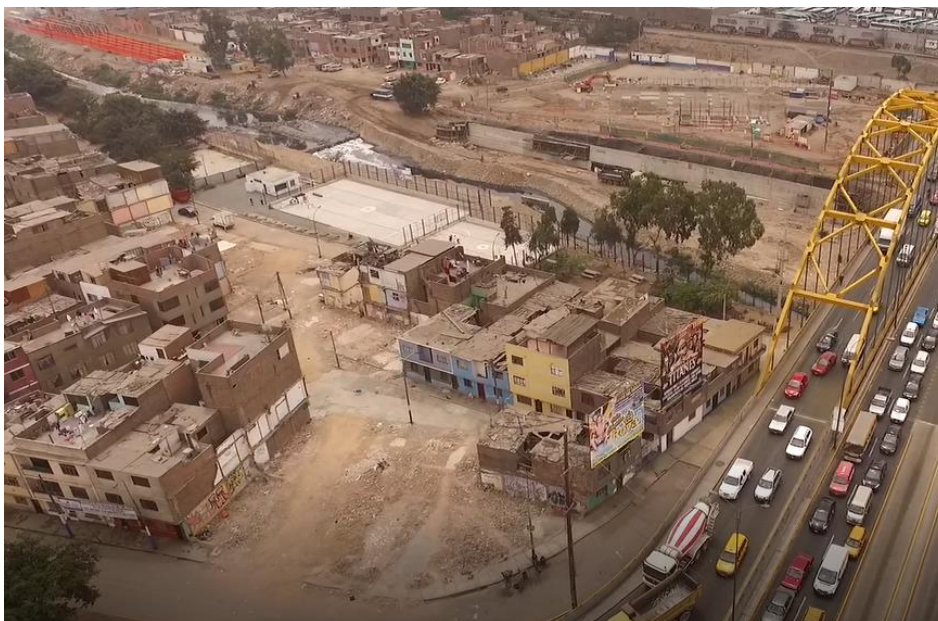
Figura 6.11. Lugar de ejecución donde se extenderá todo muro de tierra armada del viaducto 6.1 al margen izquierdo del río Rímac.
