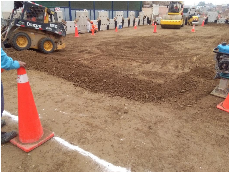
Figura 6.15. Rodillo BOMAG BW 211 compactando en el sector 02 del muro de tierra armada del viaducto 6.1.
