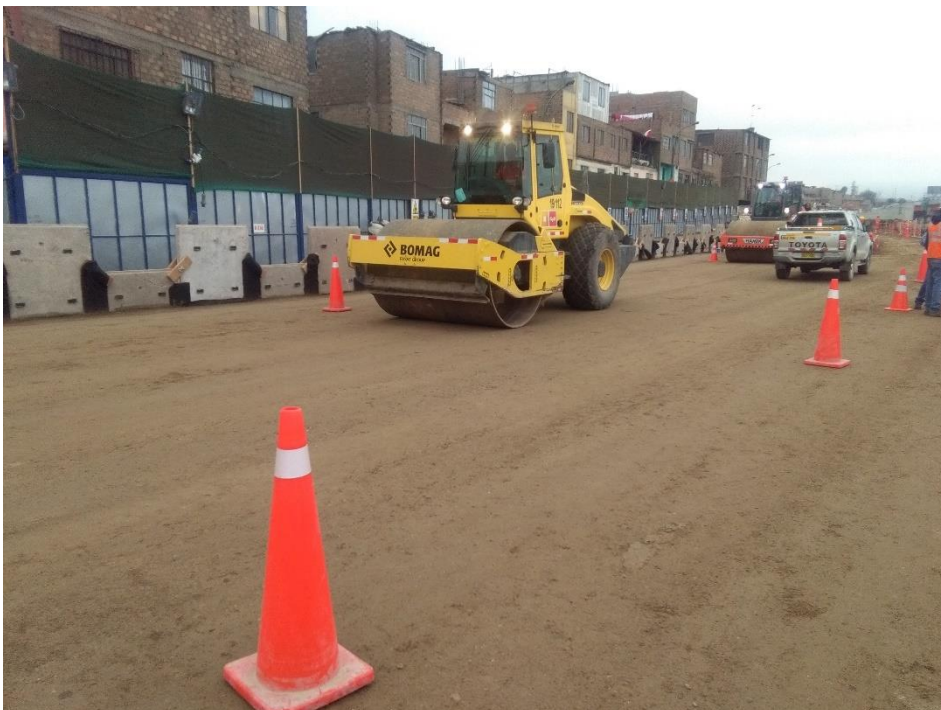
Figura 6.14. Rodillos compactadores HAMM 3410 y BOMAG BW 211 compactando de manera paralela en el sector 01 del muro de tierra armada del viaducto 6.1.
