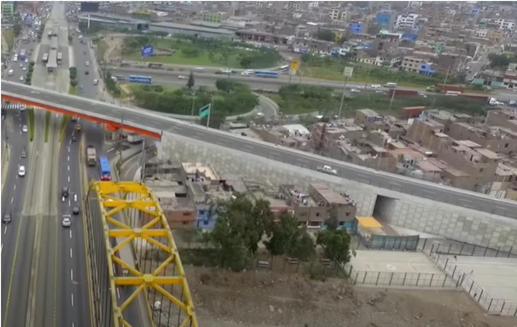
Figura 6.17. Entrega final del muro de tierra armada del viaducto 6.1.
