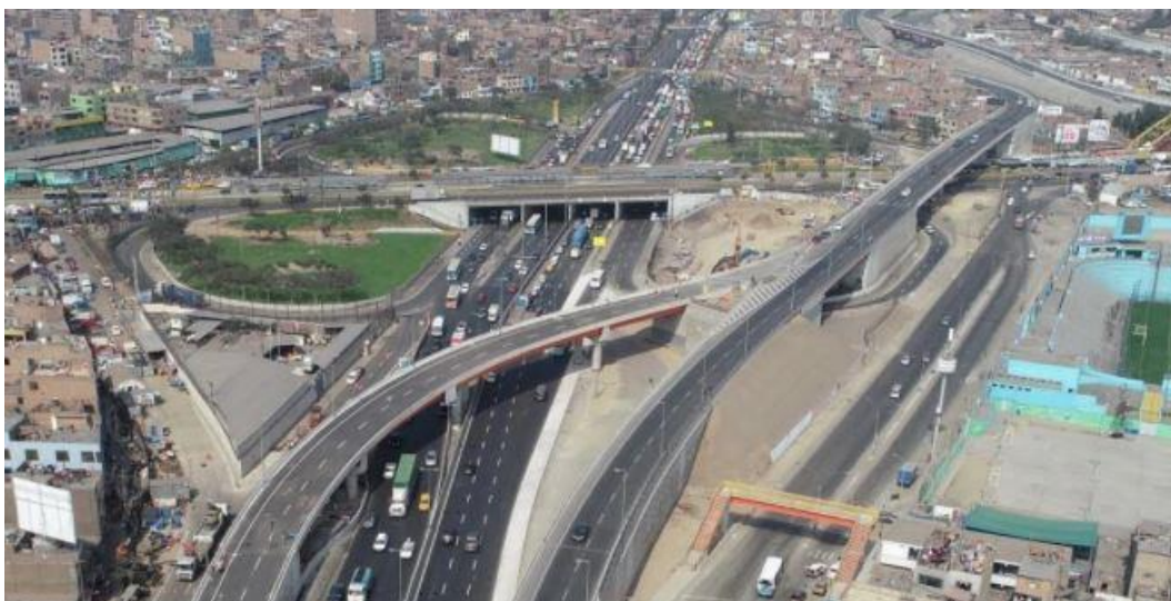
Figura 6.6. Entrega final del muro de tierra armada de viaducto 4.2.
