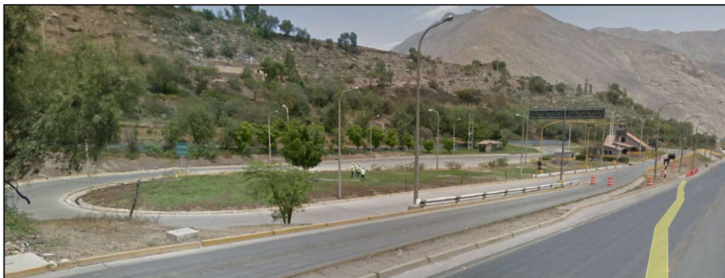
Figura N° 2.23 Infraestructura de una estación de pesaje por eje Fuente: Imagen Google Earth
