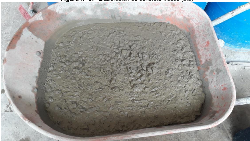
Figura N° 37 Elaboración de concreto fresco (3.3)
