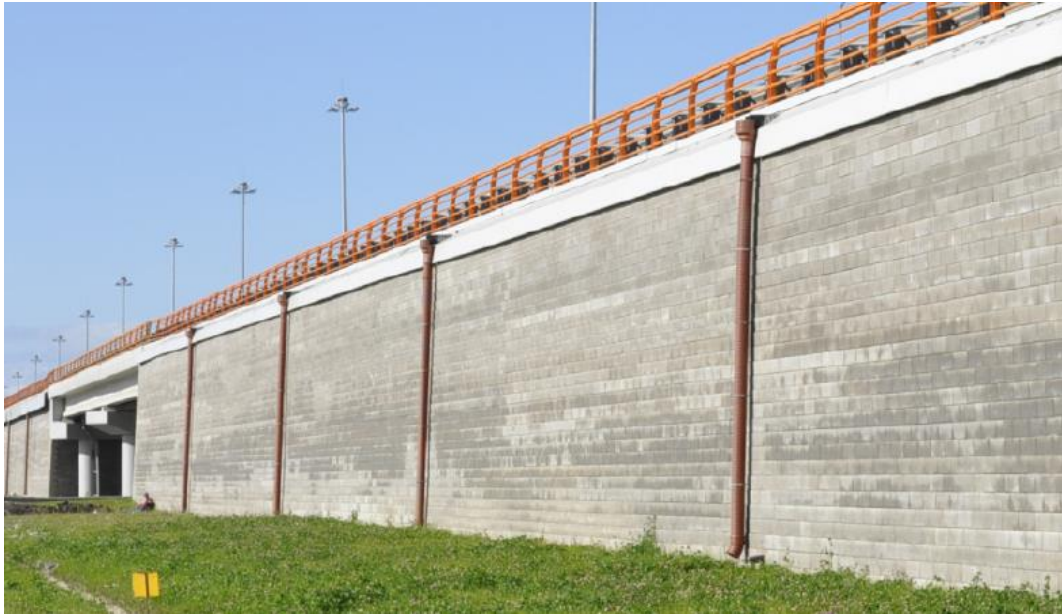
Figura N° 07: Muro con paramento de bloques de mampostería
