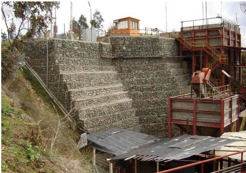
Figura N° 08: Muro con paramento de gaviones
