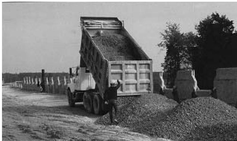
Figura N° 30: Colocación del relleno seleccionado.
