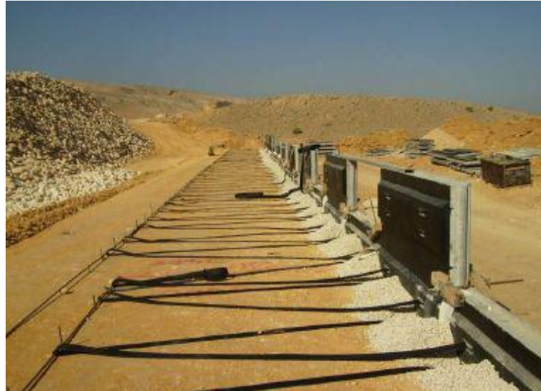
Figura N° 31: Colocación elementos de refuerzo.
