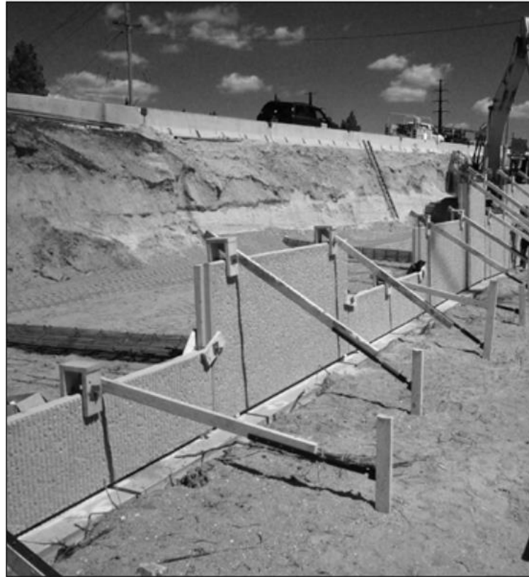
Figura N° 29: Colocación de la primera fila de paneles de concreto sobre solera.
