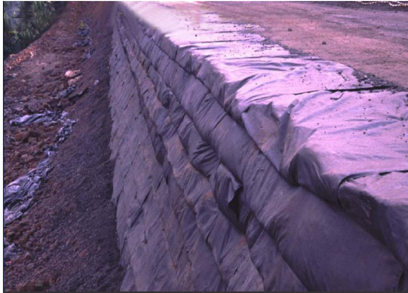
Figura N° 05: Muro reforzado con geotextil.
