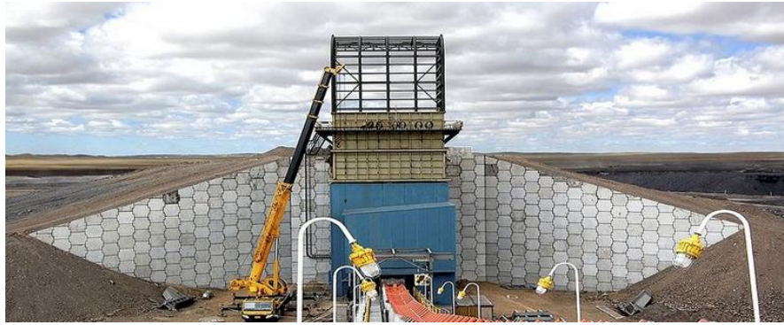
Figura N° 01: Aplicación en la minería del muro de suelo reforzado con paramento frontal de concreto prefabricado.
