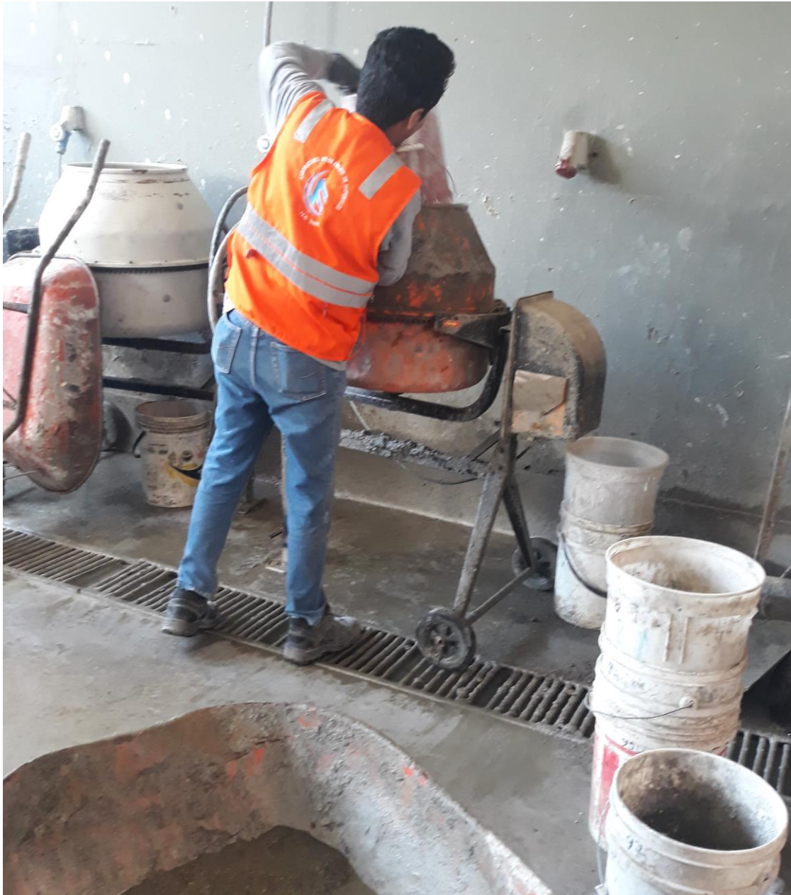
Foto 12. MEZCLA DE LOS MATERIALES EN EL LEM - FIC UNI
