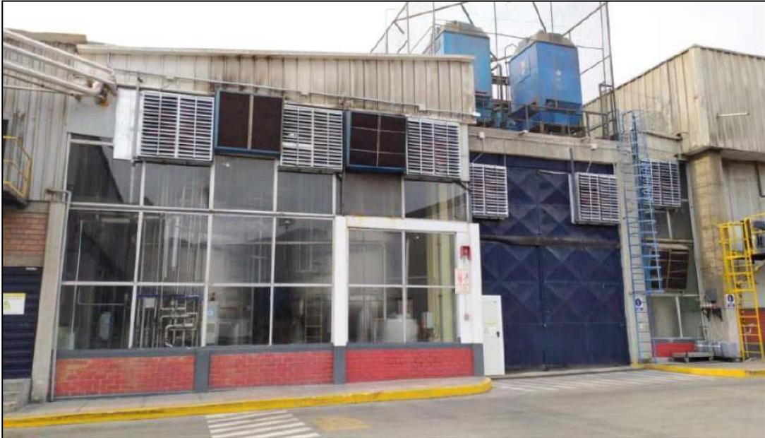
*Foto 11. Vista exterior de los extractores de aire del área de esterilización.*
