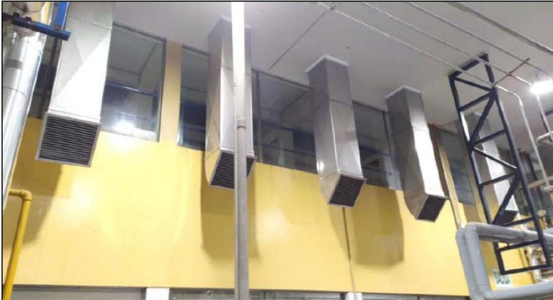
*Foto 10. Vista del techo interior de los inyectores de aire del área de esterilización.*
