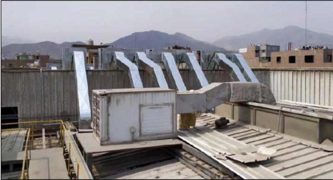
*Foto 9. Vista del techo exterior de los inyectores de aire del área de esterilización.*
