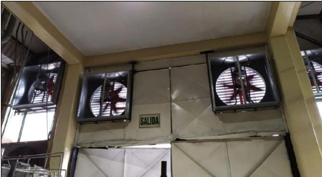
*Foto 12. Vista interior de los extractores de aire del área de esterilización.*
