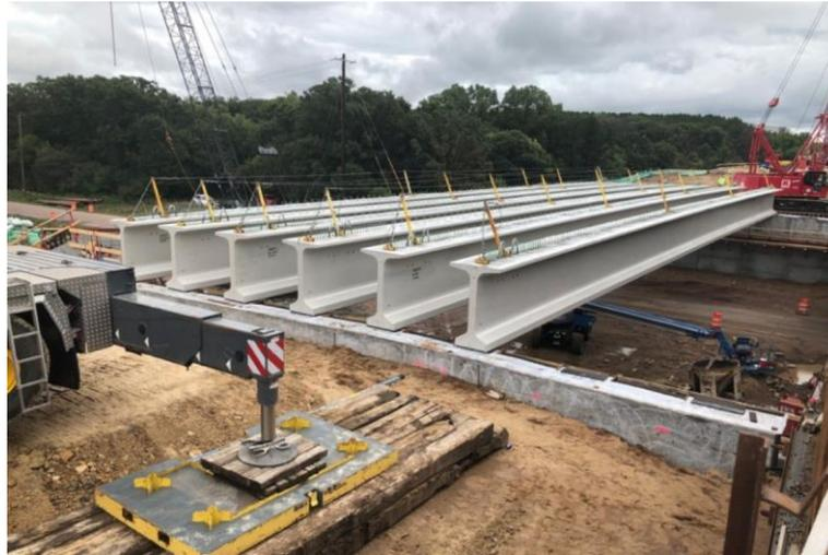
Figura N°2.4: Proceso de izaje e instalación de viga prefabricada.
