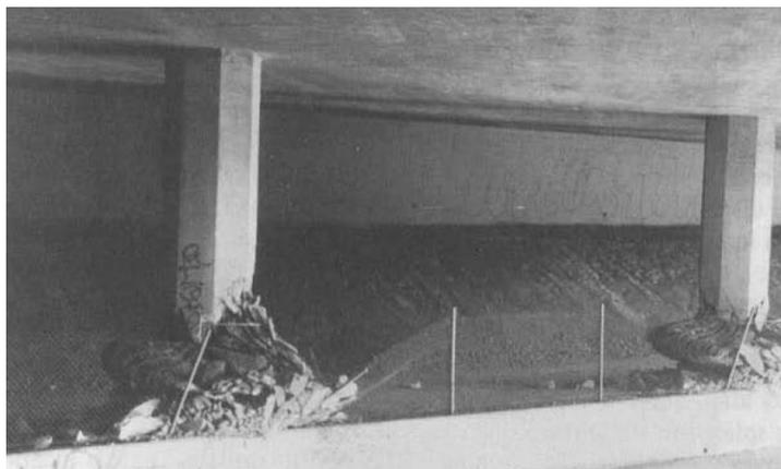
Figura N°2.13: Falla a flexión por plastificación del acero de refuerzo, sismo de Northridge, 1994. (Priestley et al., 1996).
