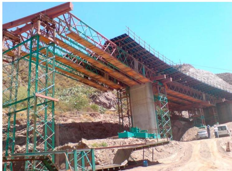
Figura N°2.5: Proceso de encofrado y apuntalamiento de tablero
