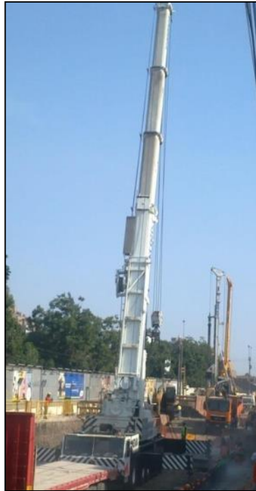
Figura N°5.08 Ejecución de Izaje de Vigas Prefabricadas – Área de Producción
