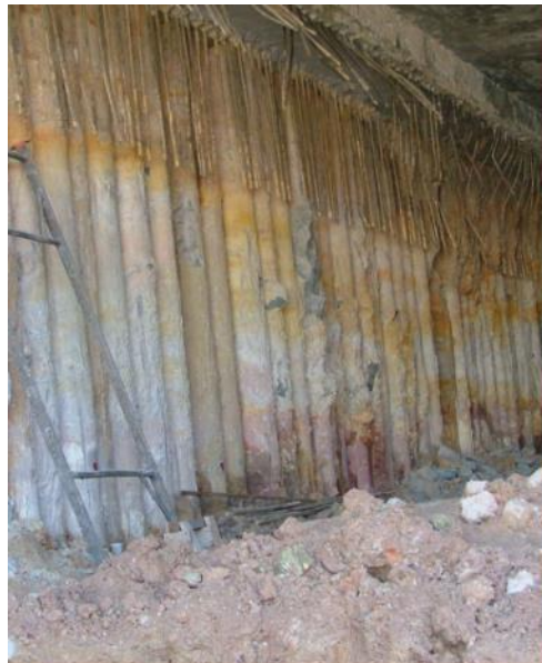
Figura N°2.46 Hastiales de Pilotes Tangenciales – ITA
