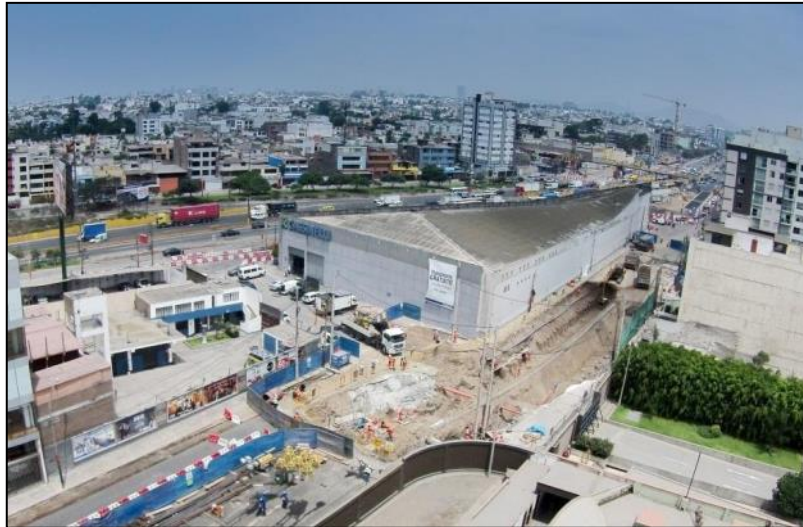
Figura N°5.06 Ejecución de Viga de Atado – Área de Producción Vías Nuevas
