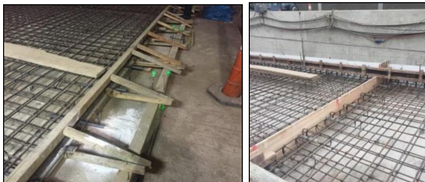
Figura N°5.35 Colocación de Encofrado Lateral en la Losa Armada – Elaboración Propia
