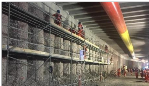
Figura N°5.16 Descarificado de Pilotes en la Progresiva 0+630 – Elaboración Propia
