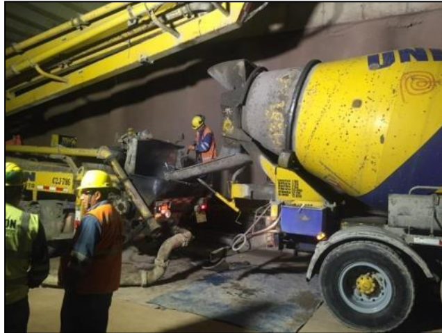
Figura N°5.37 Concretado de Losa Armada con Bomba TK de 150m – Elaboración Propia
