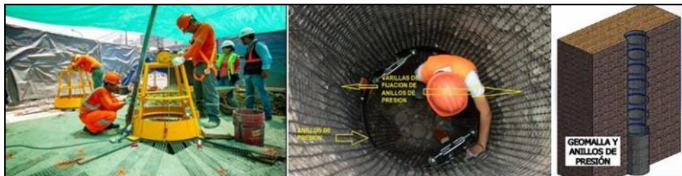
Figura N°5.04 Ejecución de Pilotes de Forma Manual – Área de Producción Vías Nuevas
