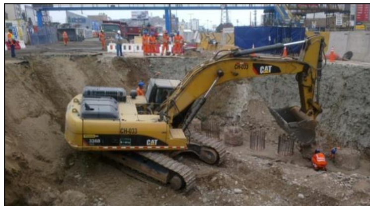
Figura N°5.05 Ejecución de Descabezado de Pilotes – Área de Producción Vías Nuevas
