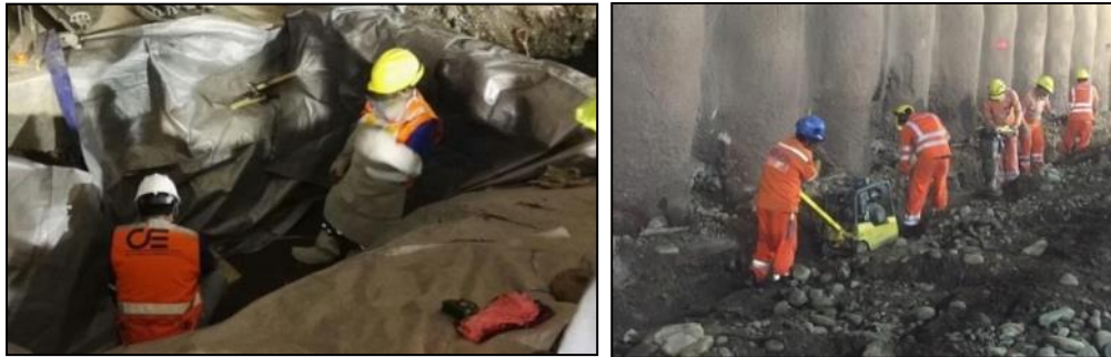
Figura N°5.27 Soldadura y Relleno de Zanja en el Sistema Puesta a Tierra Lateral en el Túnel 0+680 – Elaboración Propia
