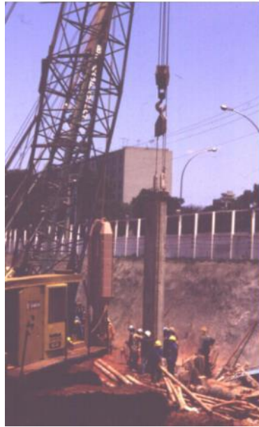
Figura N°2.45 Hastiales de Muros Pantalla Prefabricados – ITA
