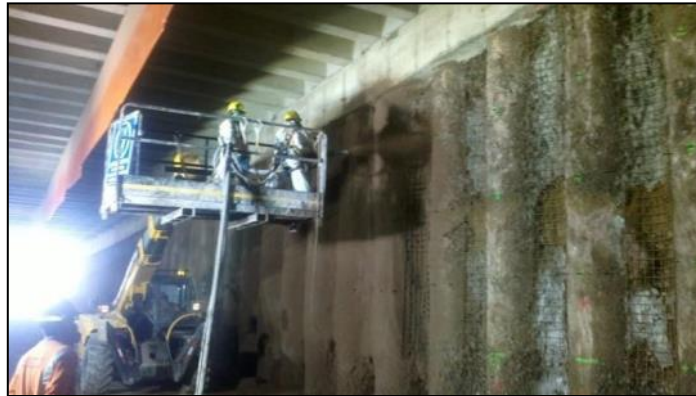
Figura N°5.19 Colocación de Shocrete por parte de UNICON – Elaboración Propia
