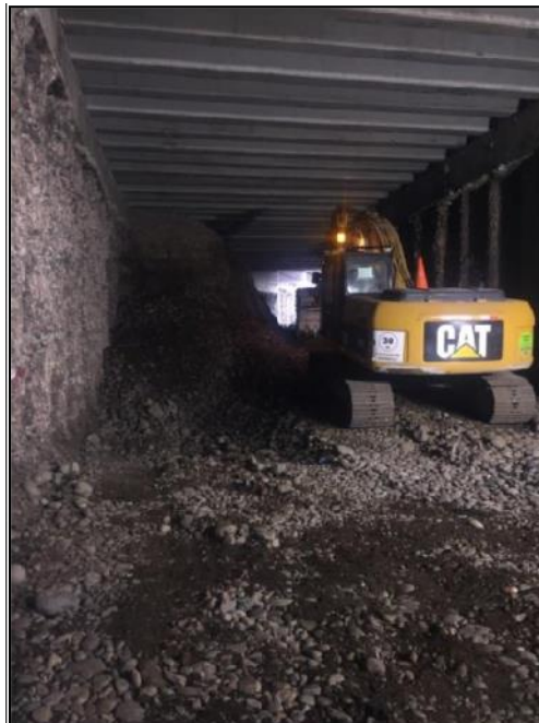
Figura N°5.14 Excavación Masiva en el Interior del Túnel – Elaboración Propia
