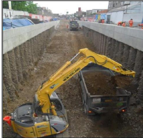
Figura N°5.13 Excavación Masiva en la Rampa de Salida– Elaboración Propia
