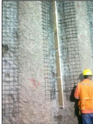
Figura N°5.18 Colocación de Junta de Dilatación del Shocrete 0+680 – Elaboración Propia
