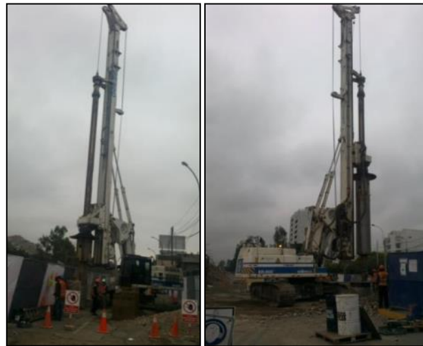
Figura N°5.03 Ejecución de Pilotes por Equipo Mecánico – Área de Producción Vías Nuevas
