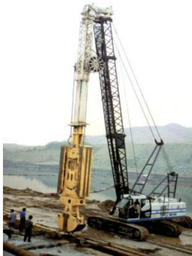
Figura N°2.43 Hastiales de Muros Pantalla In Situ – ITA
