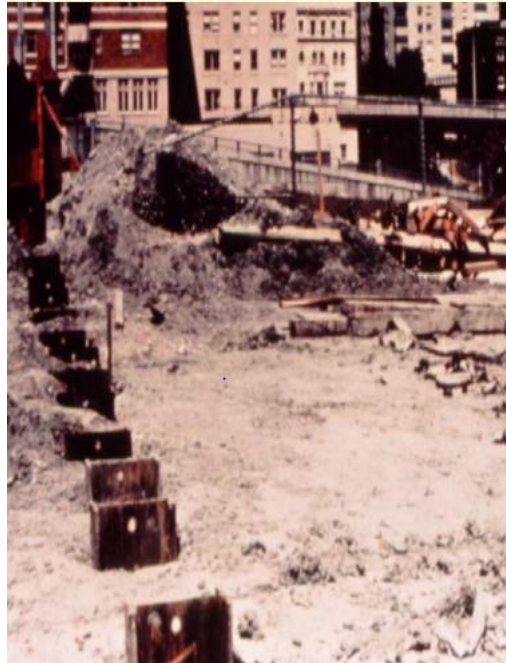
Figura N°2.42 Hastiales de Pilotes Metálicos – ITA
