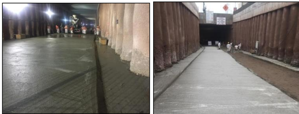
Figura N°5.29 Ejecución del Solado en el Túnel – Elaboración Propia
