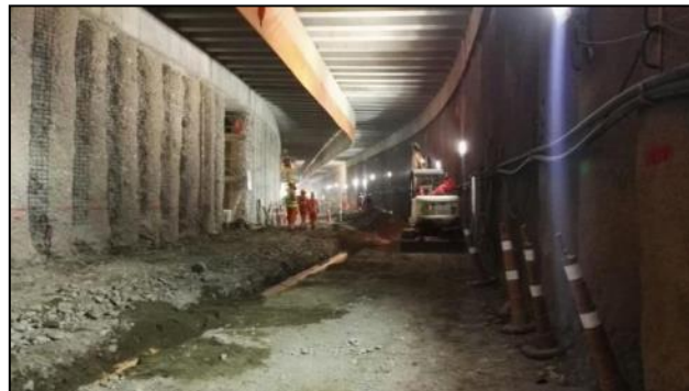
Figura N°5.22 Instalación de Tubería Principal en el Túnel 0+520– Elaboración Propia
