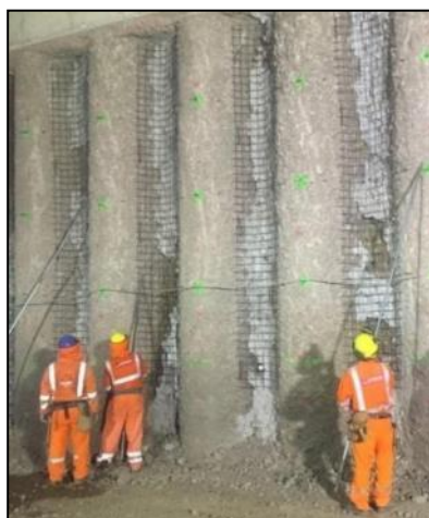
Figura N°5.17 Colocación del Acero de Refuerzo del Shocrete 0+680 – Elaboración Propia
