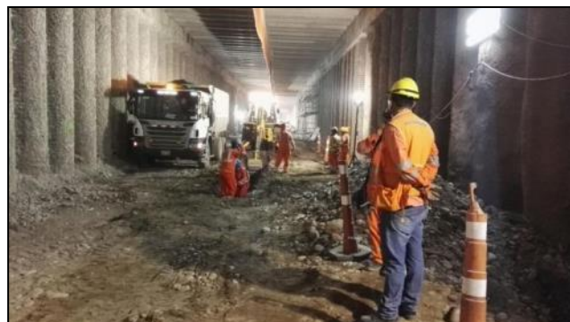
Figura N°5.23 Instalación de Tubería Principal en el Túnel 0+670 – Elaboración Propia
