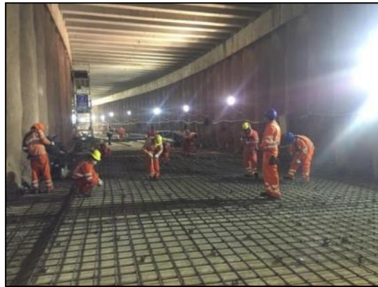
Figura N°5.33 Colocación del Acero Estructural en la Losa Armada – Elaboración Propia
