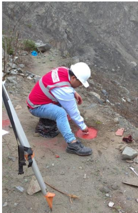
Figura N°3.10:vaciado del punto geodésico
