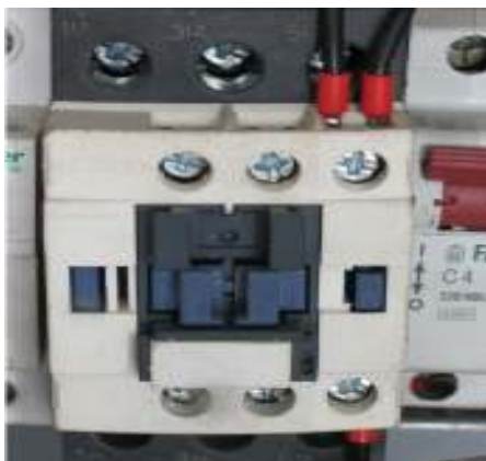
Imagen N° 18. Contactor de 32 A. Elaboración Propia.
