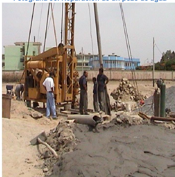
Fotografía 56: Reparación de un pozo de agua
