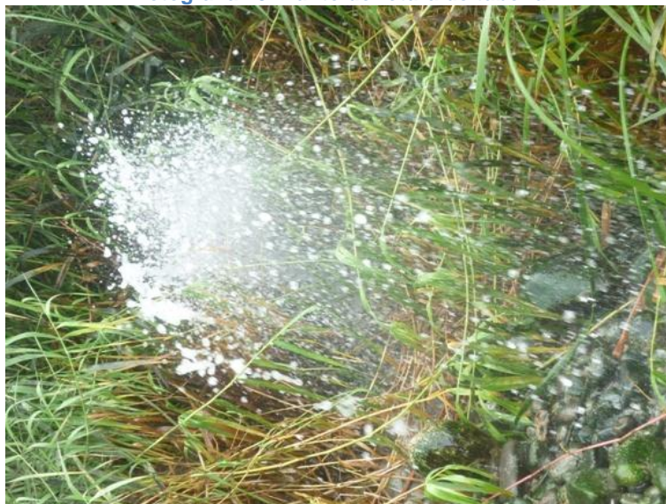
Fotografía 13: Punto de rotura de tubería
