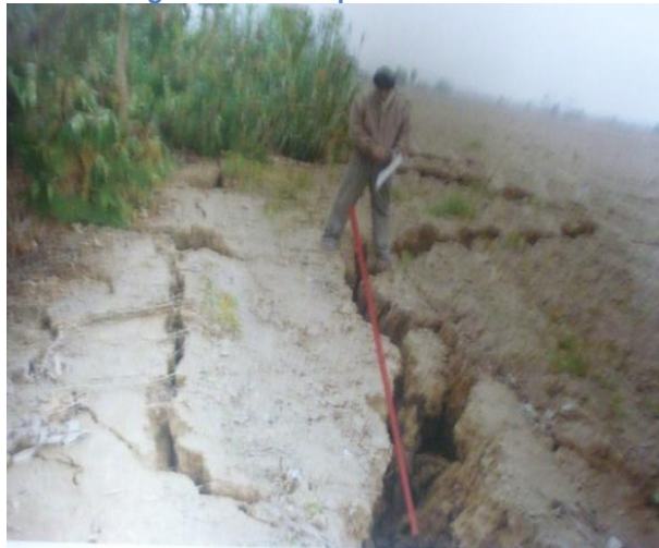
Fotografía 53: Falla producto del Sismo
