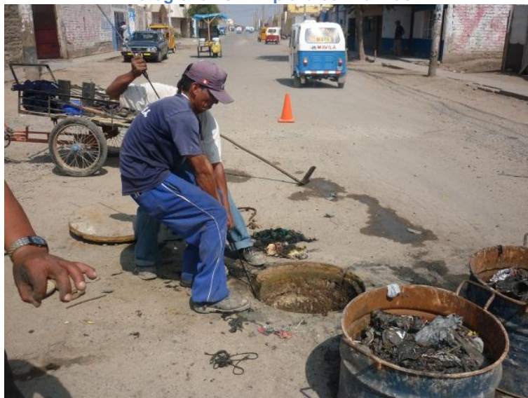
Fotografía 40: Limpieza con varillas
