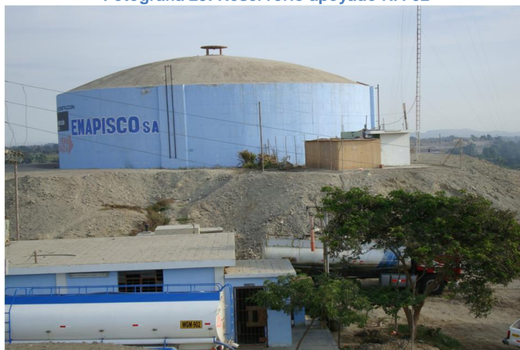
Fotografía 25: Reservorio apoyado RA-02
