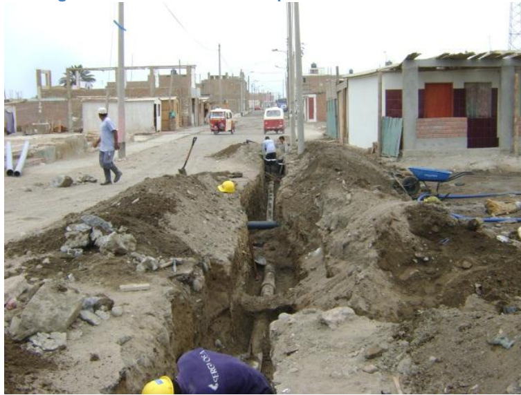
Fotografía 32: Tubería de AC en proceso de rehabilitación
