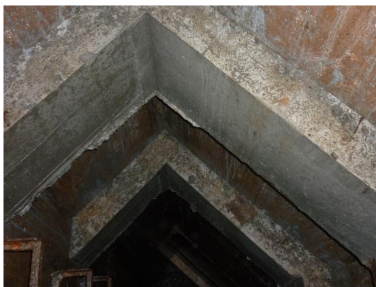
Fotografía 4: Vigas de refuerzo en la cámara agrietada.
