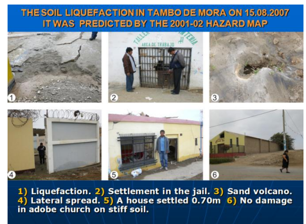
DAÑOS POR LICUACIÓN DE SUELOS EN TAMBO DE MORA
