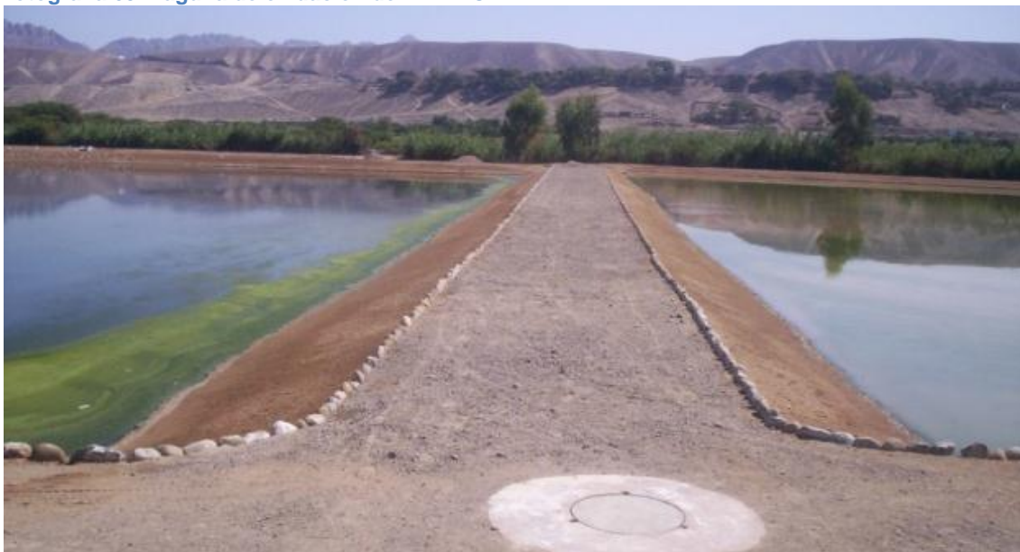
Fotografía 65: Laguna de oxidación de EMAPICA.
