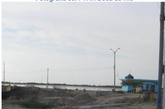
Fotografía 50: PTAR Boca de Río
