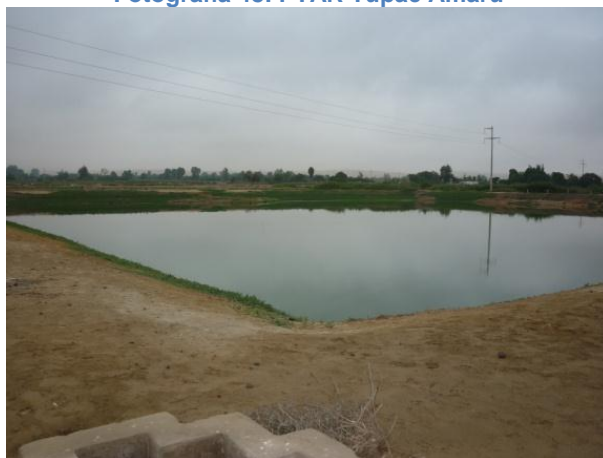
Fotografía 48: PTAR Túpac Amaru
