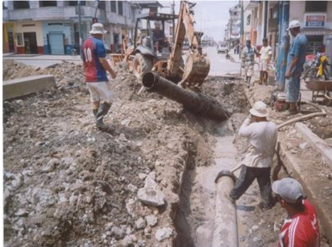
Fotografía 62: Tubería de AC en Ica
