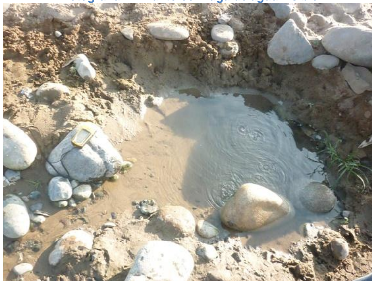
Fotografía 14: Punto con fuga de agua visible
