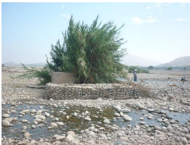
Fotografía 3: Vista de la cámara en el lecho del río Pisco
