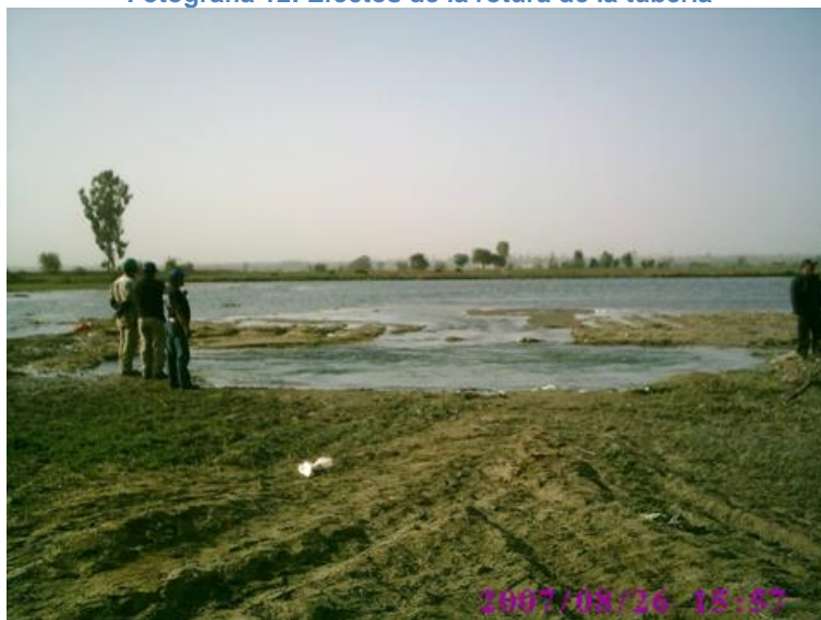
Fotografía 12: Efectos de la rotura de la tubería
