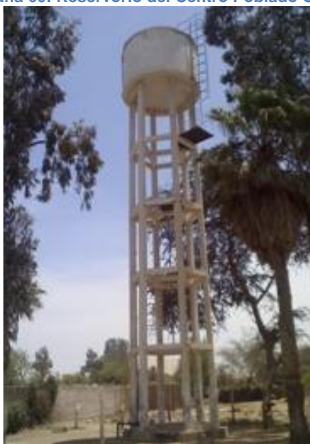
Fotografía 60: Reservoirio del Centro Poblado Cachiche
