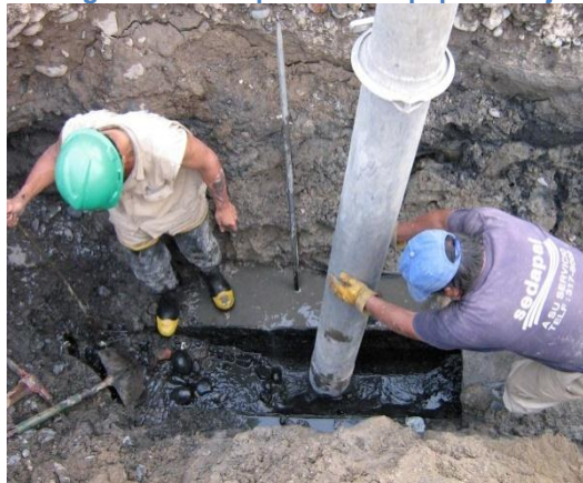
Fotografía 37: Limpieza con equipo hidrojet
