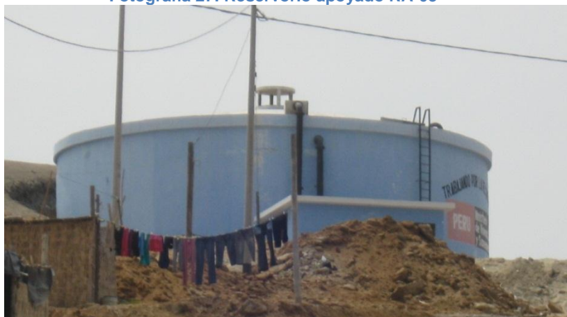
Fotografía 27: Reservorio apoyado RA-03
