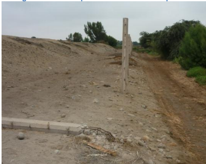
Fotografía 49: Cerco perimétrico de PTAR Túpac Amaru
