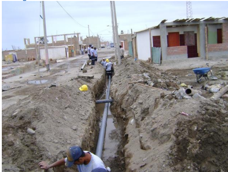
Fotografía 33: Tubería de PVC utilizado en la rehabilitación.
