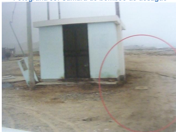
Fotografía 55: Cámara de bombeo de desagüe
