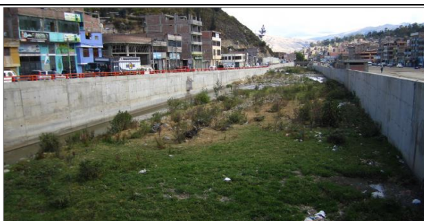
Imagen N° 2. Vista aguas abajo del puente Pochccota.
