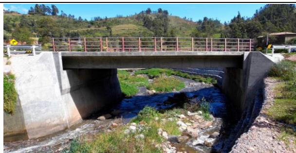
Imagen N° 3. Lectura de niveles en marcas de agua, puente Comunchaca.
