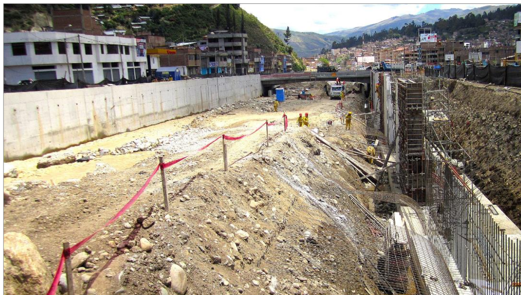
Figura N° 21. Proceso constructivo del puente Pochccota y muros de encauzamiento.
