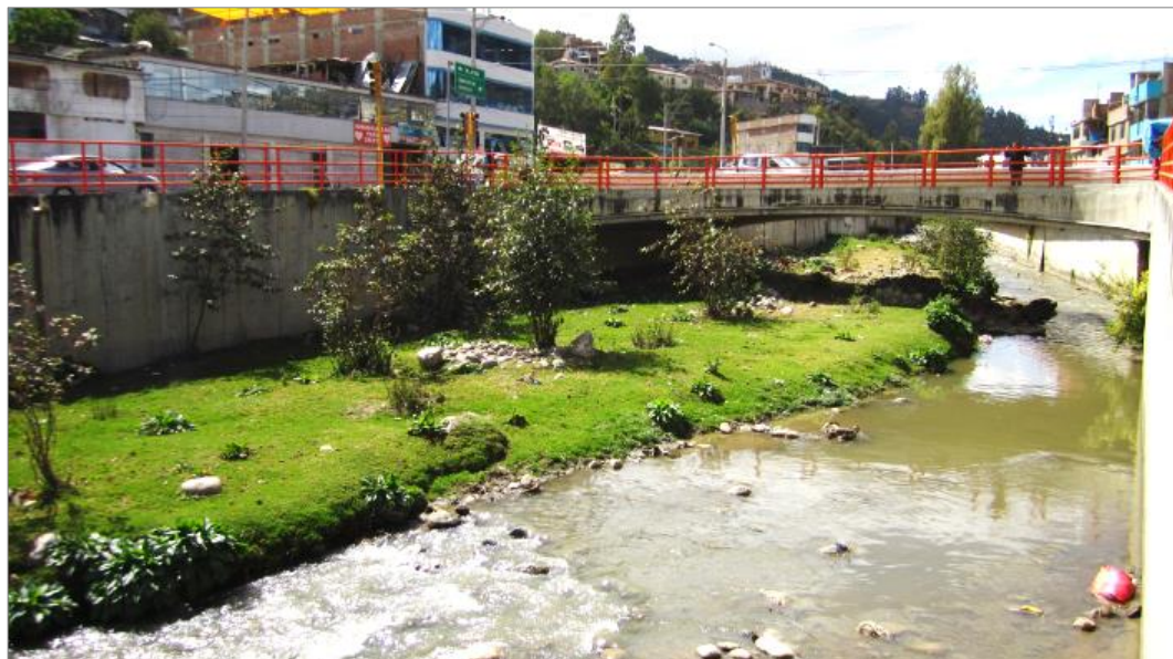
Figura N° 28. Vista general del puente Chumbao y muros de encauzamiento.
