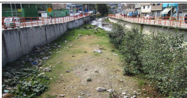
Imagen N° 1. Vista aguas arriba del puente Chumbao.
