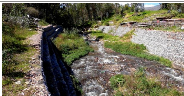
Imagen N° 1. Vista aguas arriba del puente Comunchaca.
