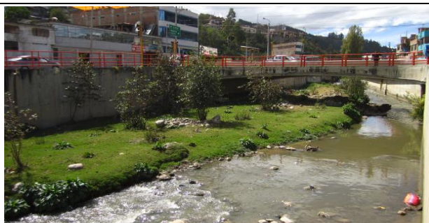
Imagen N° 3. Lectura de niveles en marcas de agua, puente Chumbao.
