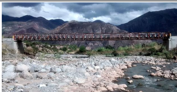
Imagen N° 3. Lectura de niveles en marcas de agua, puente Callebamba.
