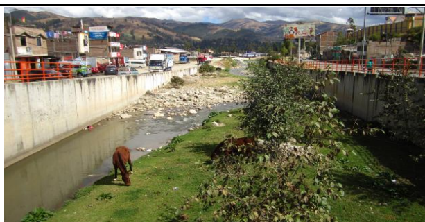
Imagen N° 2. Vista aguas abajo del puente Chumbao.
