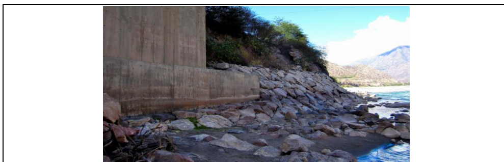
Imagen N° 2. Vista aguas abajo y estribo izquierdo Pampas.
