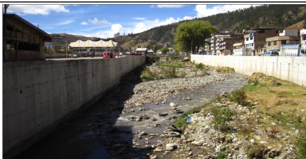
Imagen N° 1. Vista aguas arriba del puente Pochccota.
