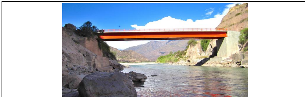
Imagen N° 3. Vista general desde aguas abajo, puente Pampas.
