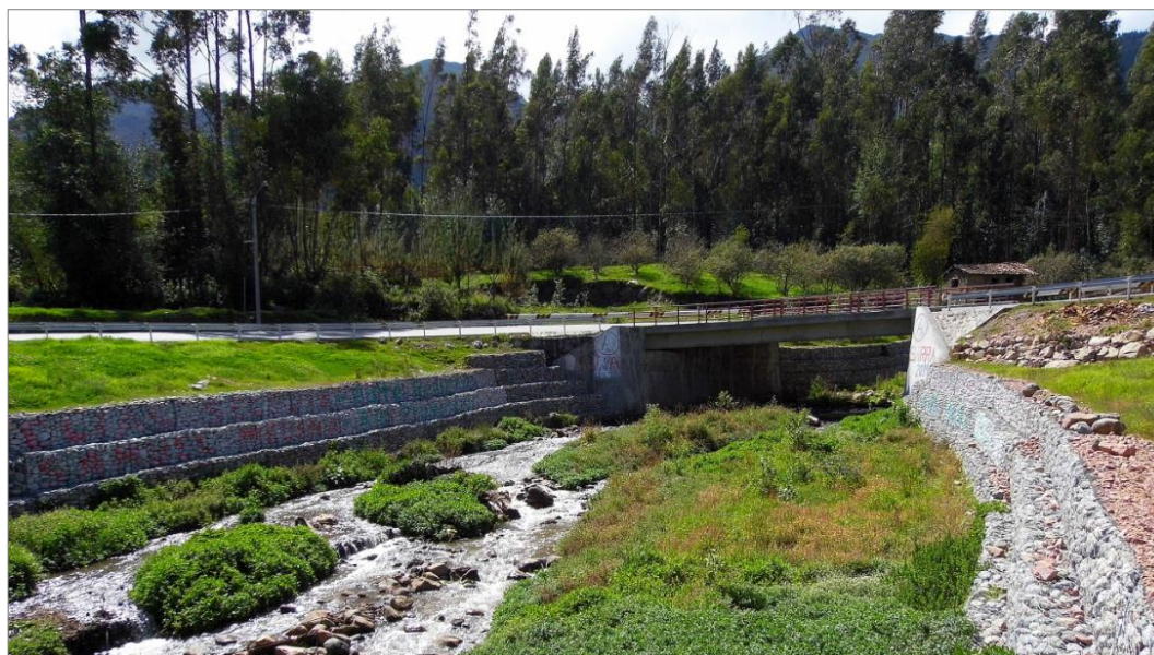
Figura N° 36. Vista general del puente Comunchaca y defensas ribereñas.
