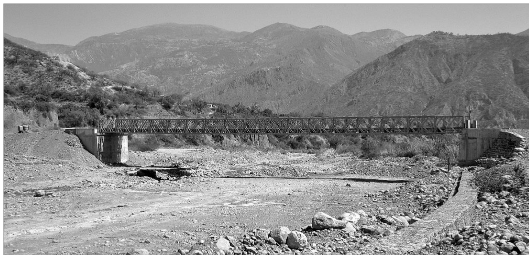
Figura N° 44. Vista general del puente Callebamba y defensas ribereñas.
