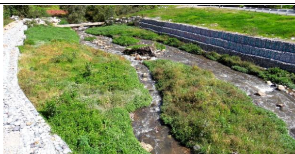
Imagen N° 2. Vista aguas abajo del puente Comunchaca.
