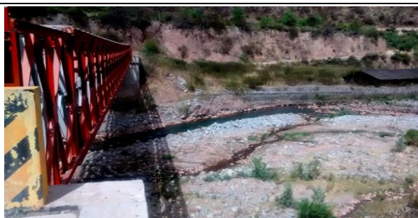
Imagen N° 2. Vista aguas abajo del puente Callebamba.
