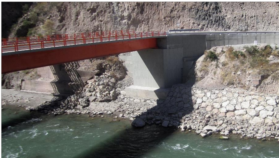
Figura N° 40. Vista general del puente Pampas y enrocado de protección.
