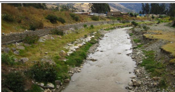
Imagen N° 2. Vista aguas abajo de la progresiva 0+240.00 del eje del río.
