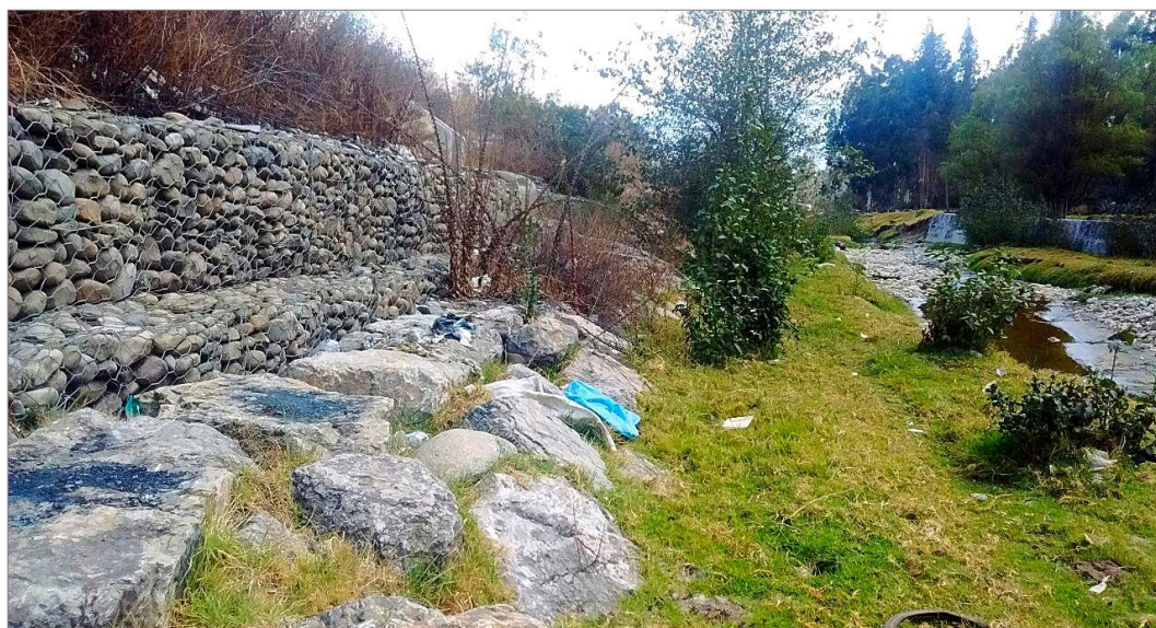
Figura N° 31. Gaviones y enrocados de protección en el río Chumbao.
