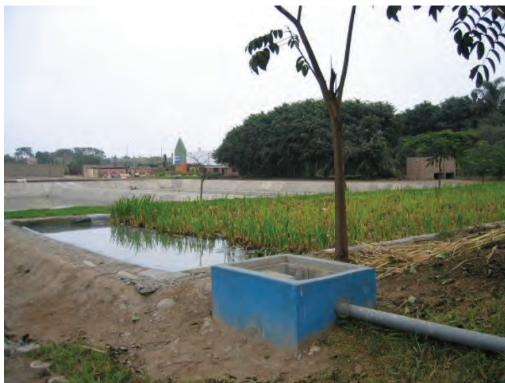
Foto 3. 7: Humedal construido en CITRAR-UNI (ex UNITRAR) ubicado en la Universidad Nacional de Ingeniería en Lima, Perú.
