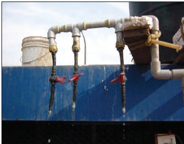
Foto 6. 16: Se visualiza los 3 grifos que son aforados para controlar el caudal que ingresa a los TSA.
