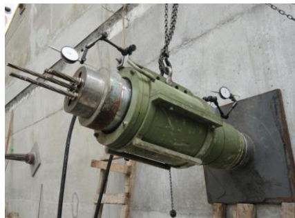
Figura 40: Ensayo del tendón de anclaje (equipos: gato hidráulico y micrómetros).
