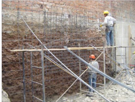
Figura 9: Armado del acero de refuerzo en la pantalla.
