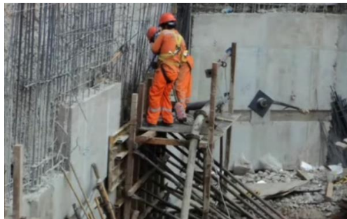
Figura 10: Vaciado de concreto de la pantalla.
