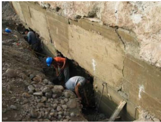
Figura 2: Excavación para un segundo nivel de calzaduras.
