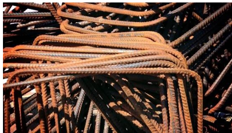
Figura 75: Acero corrugado afectado por corrosión general.
