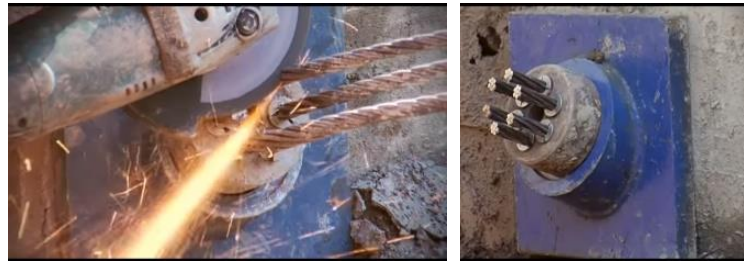
Figura 88: Corte de colas de tensado.
