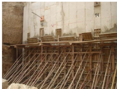
Figura 8: Encofrado de pantalla.
