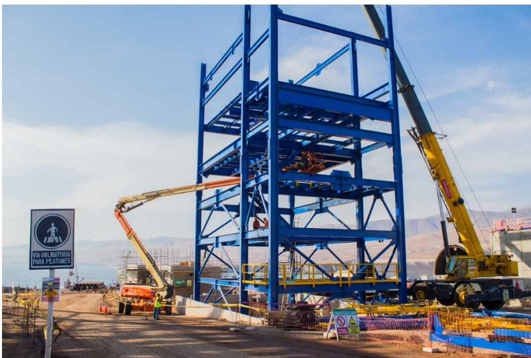
Foto N°3.1 – Torre de Transferencia N° 02 montaje de las estructuras
