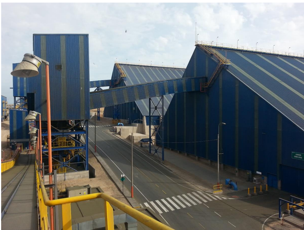
Foto N°3.2 – Torre de Transferencia N° 02 terminada
