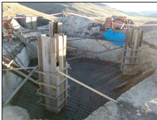
Fig. N° 49: Cimentación de Concreto armado Fuente: Propia
