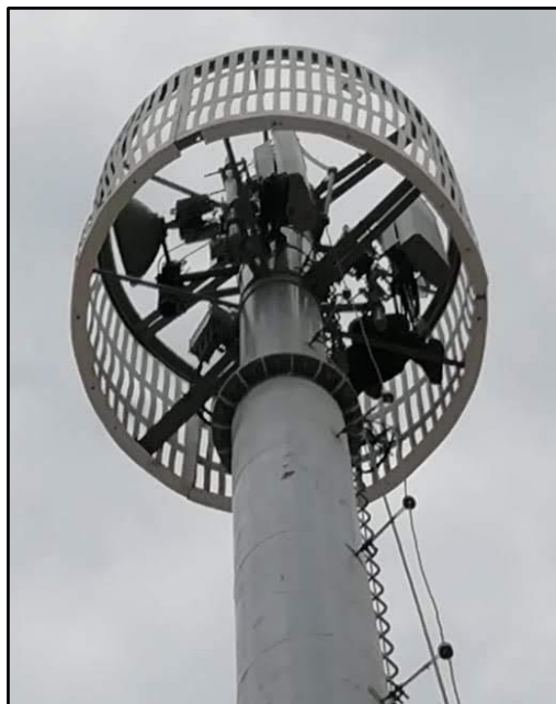
Fig. N° 34: Mimetizado Tipo Radomo Fuente: propia
