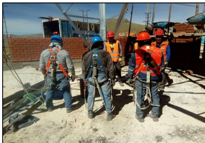
Fig. N° 60: Personal Capacitado en Trabajos en Altura Fuente: Propia
