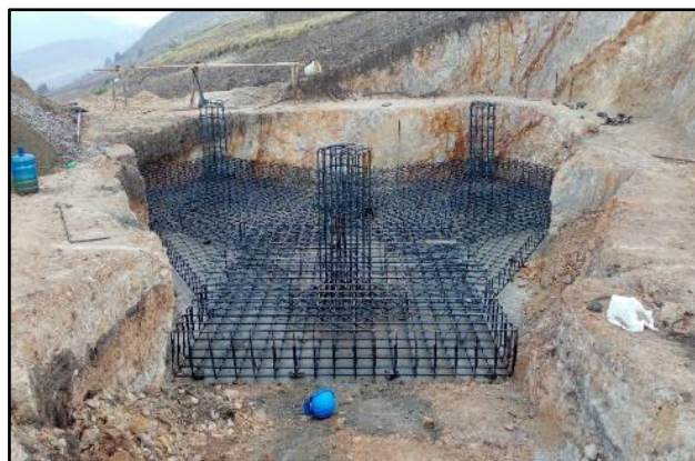
Fig. N° 48: Armadura de acero. Fuente: Propia
