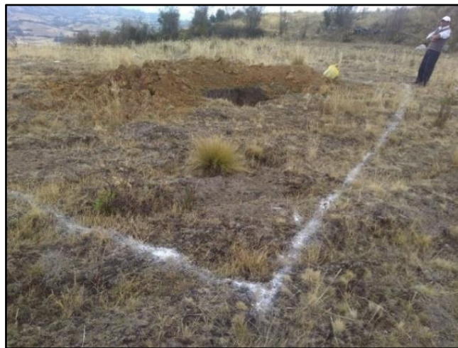
Fig. N° 46: Entrega de terreno Fuente: Propia
