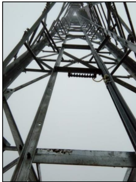
Fig. N° 27: Escalera Rack Fuente: propia
