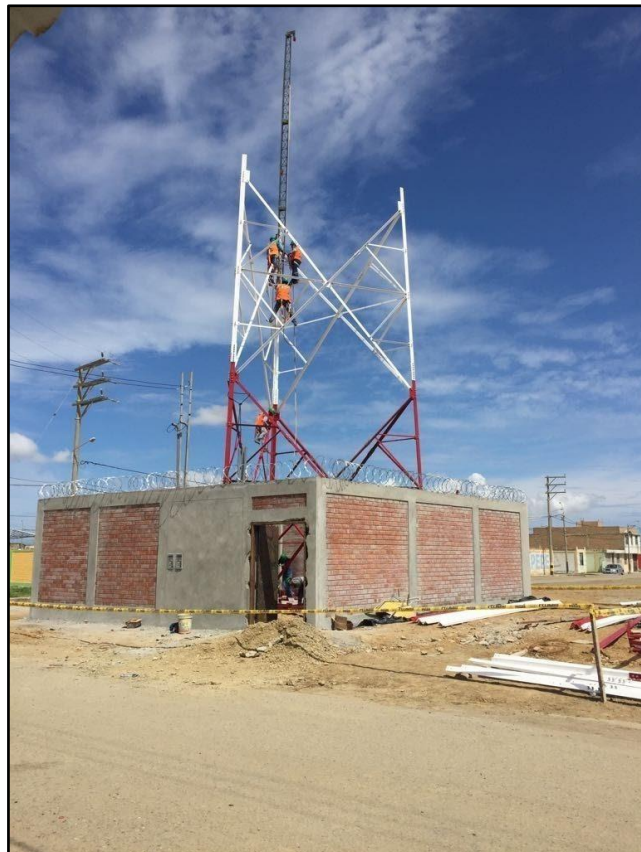
Fig. N° 56: Proceso de Montaje de Torre Autosoportada. Fuente: Propia
