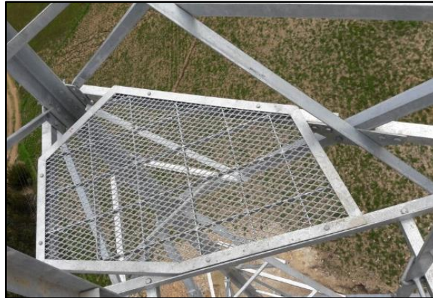
Fig. N° 25: Plataforma de descanso Fuente: propia
