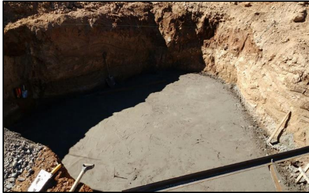
Fig. N° 47: Solado de Zapata Fuente: Propia
