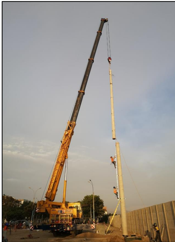
Fig. N° 57: Proceso de Montaje de Monopolo Fuente: Propia
