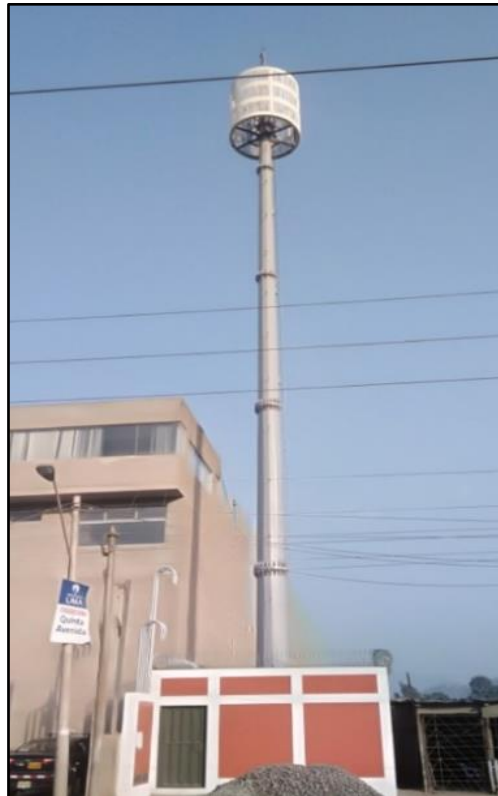
Fig. N° 29: Torre Monopolo Fuente: propia
