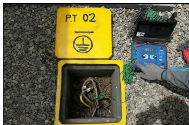
Fig. N° 66: Pozo a tierra terminado. Fuente: Propia
