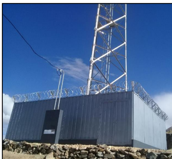
Fig. N° 54: Cerco perimétrico metálico
