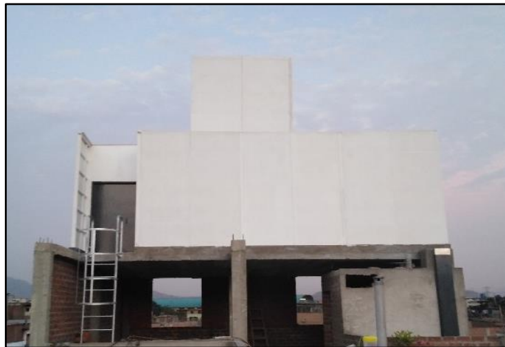
Fig. N° 55: Cerco perimétrico de albañilería
