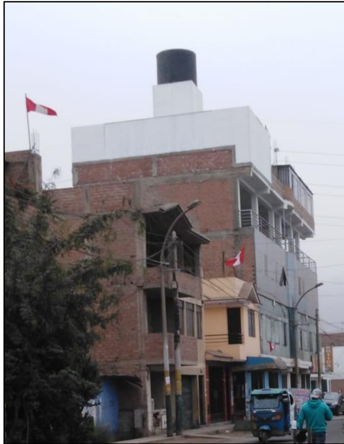
Fig. N° 12: Estación Base Celular Tipo Rooftop - Vista Exterior Fuente: propia
