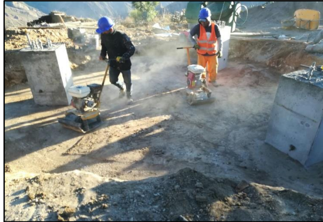
Fig. N° 52: Relleno y Compactación Fuente: Propia
