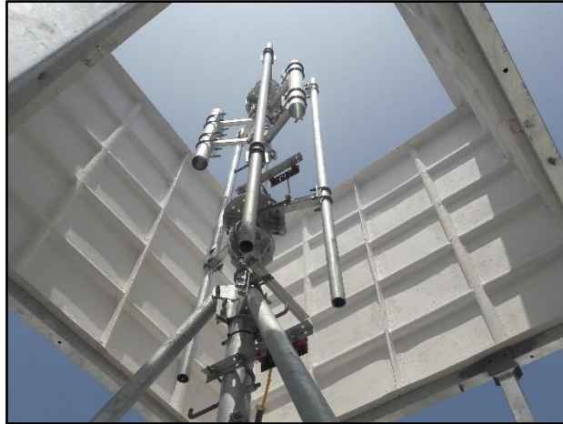
Fig. N° 33: Mimetizado Tipo Fachada – Vista Interior Fuente: propia
