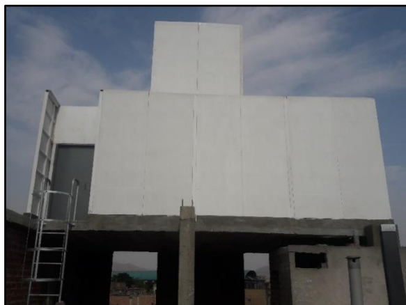
Fig. N° 32: Mimetizado Tipo Fachada – Vista Exterior Fuente: propia
