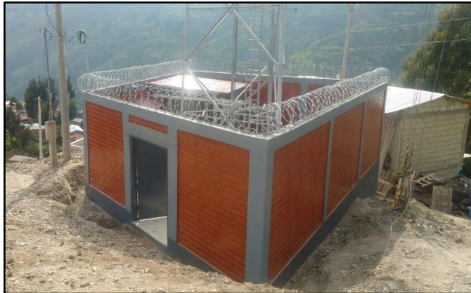
Fig. N° 53: Cerco perimétrico de albañilería
