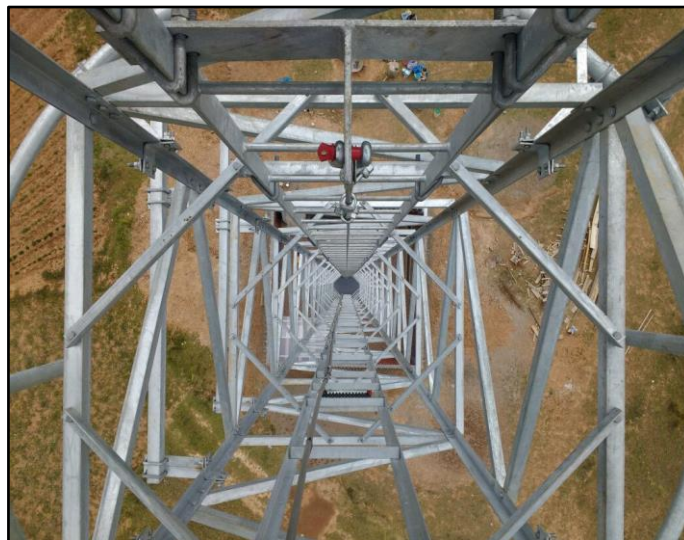
Fig. N° 28: Sistema de Seguridad Línea de Vida. Fuente: propia
