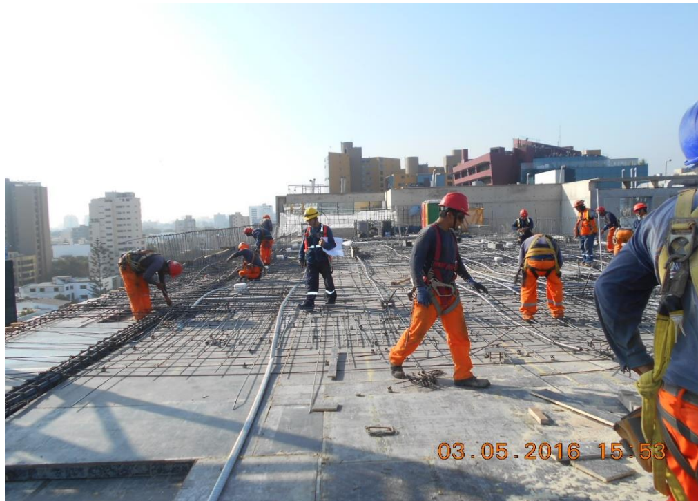
Colocación de acero en la losa del techo del piso 8.
