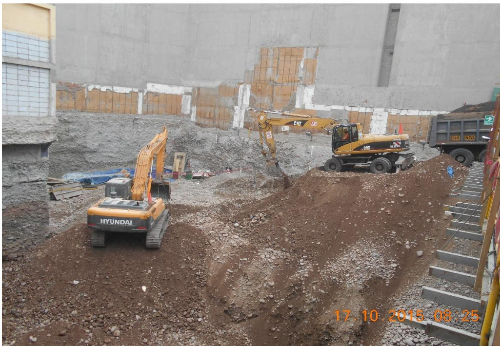
Excavación masiva y eliminación mediante rampa.
