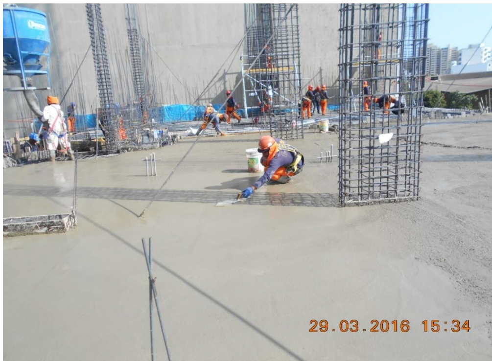
Vaciado de concreto en losas postensadas.
