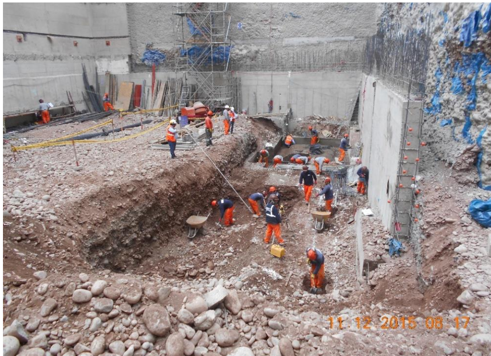
Trabajos a nivel de la cimentación de cisterna.
