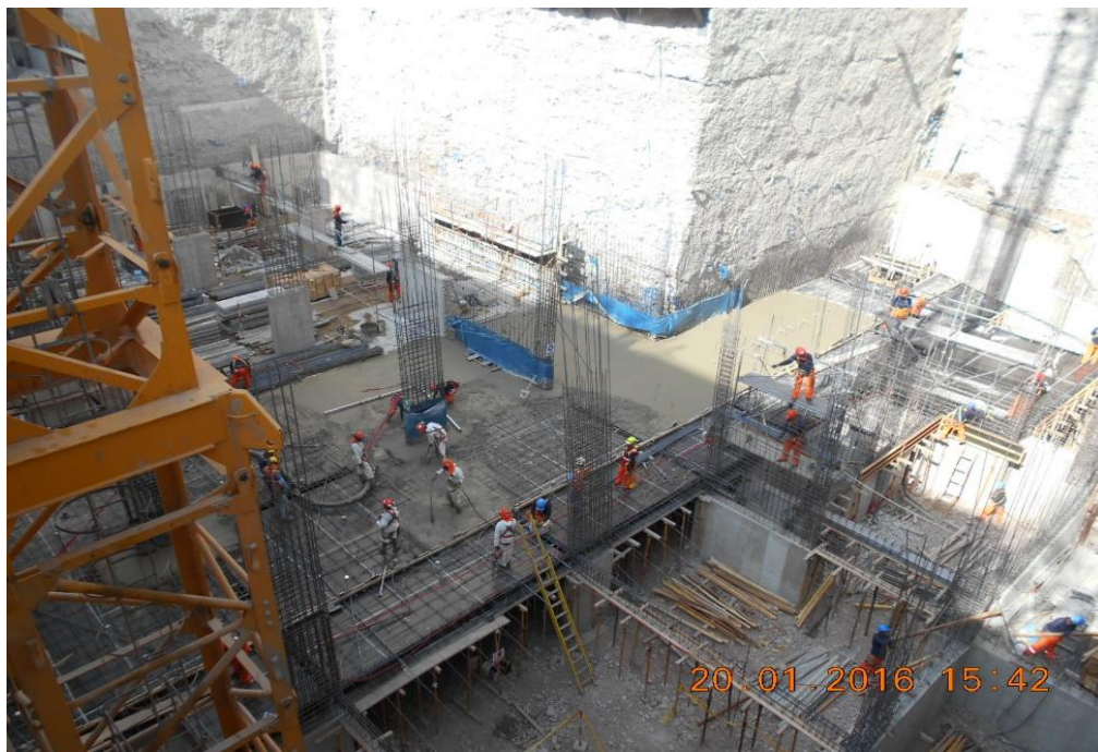
Vaciado de concreto en el sector 3 del techo del sótano 5.
