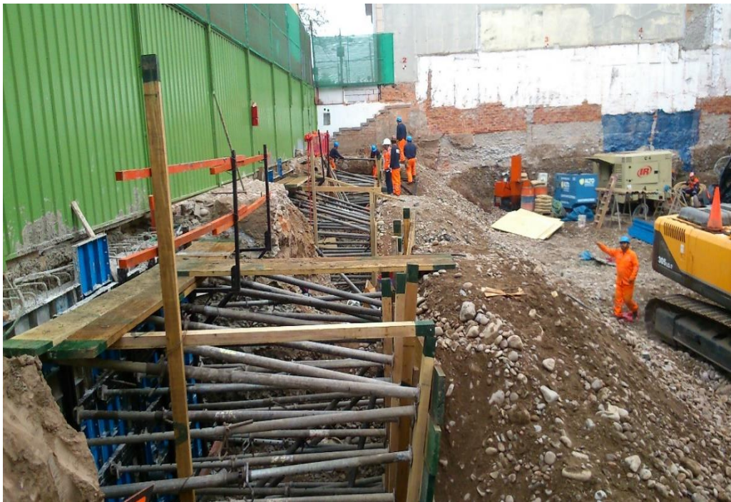
Encofrado de muros anclados del anillo 1.
