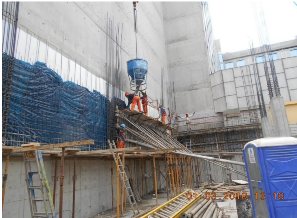
Vaciado de concreto en contramuros del piso 1.
