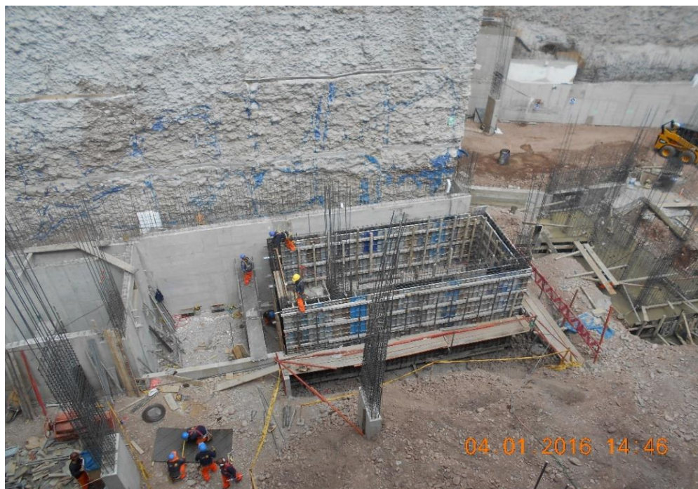
Vista de la cisterna encofrada.
