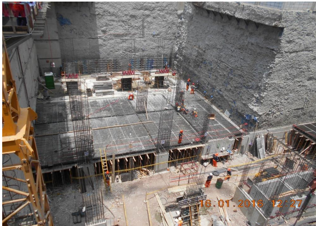
Vista del avance en techo del sótano 5.
