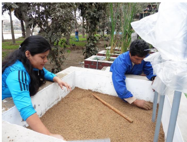
Figura 8-10 Nivelación de la superficie del medio granular
