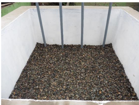
Figura 8-8 Llenado del sustrato grava media (confitillo) a los humedales
