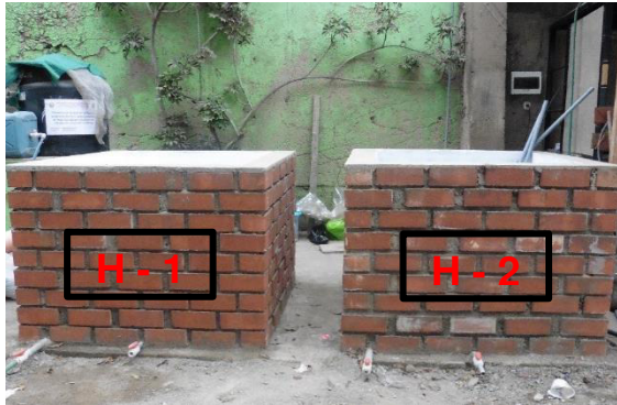
Figura 8-1 Humedales H-1 y H-2 contruidos de material noble
