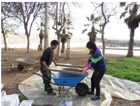
Figura 8-6 Tamizado del sustrato grava media (confitillo)
