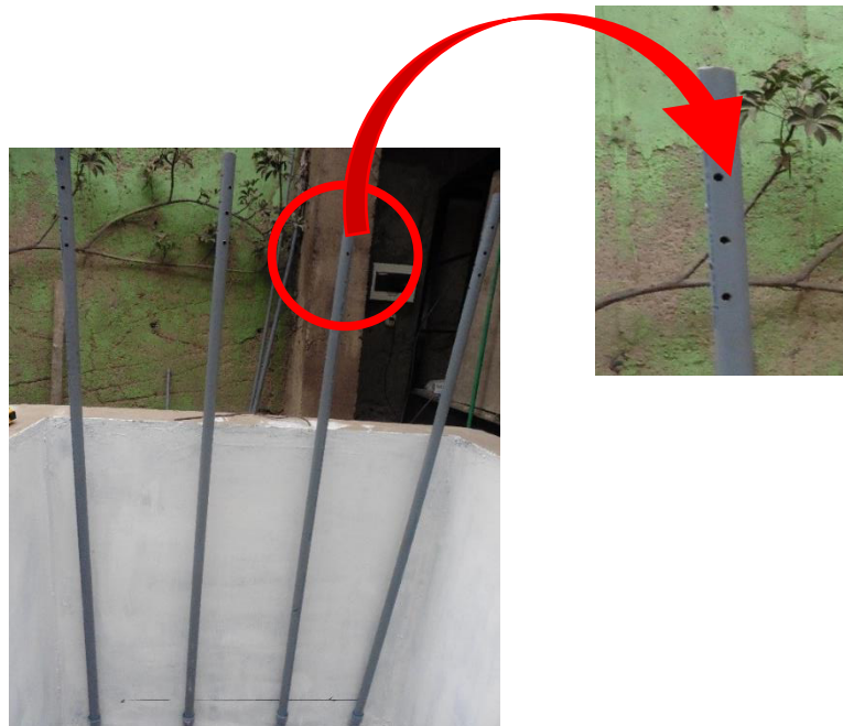
Figura 3-7 Sistema de ventilación
