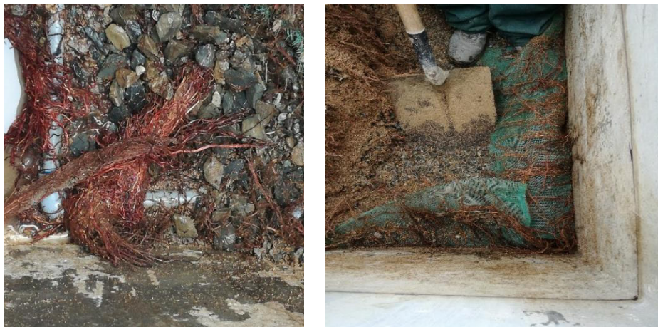
Figura 4-10 Formación de una malla gruesa de raíces en el fondo del humedal
