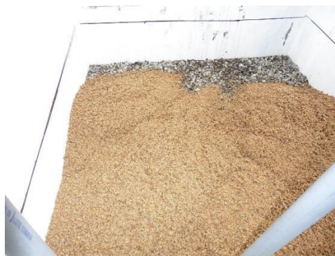
Figura 8-9 Llenado del sustrato arena gruesa a los humedales
