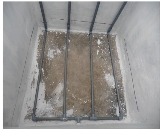
Figura 3-6 Sistema de recolección de agua tratada
