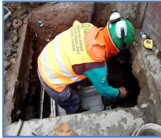
Figura N°10: Acomodo y alineación de la base de caja de registro
