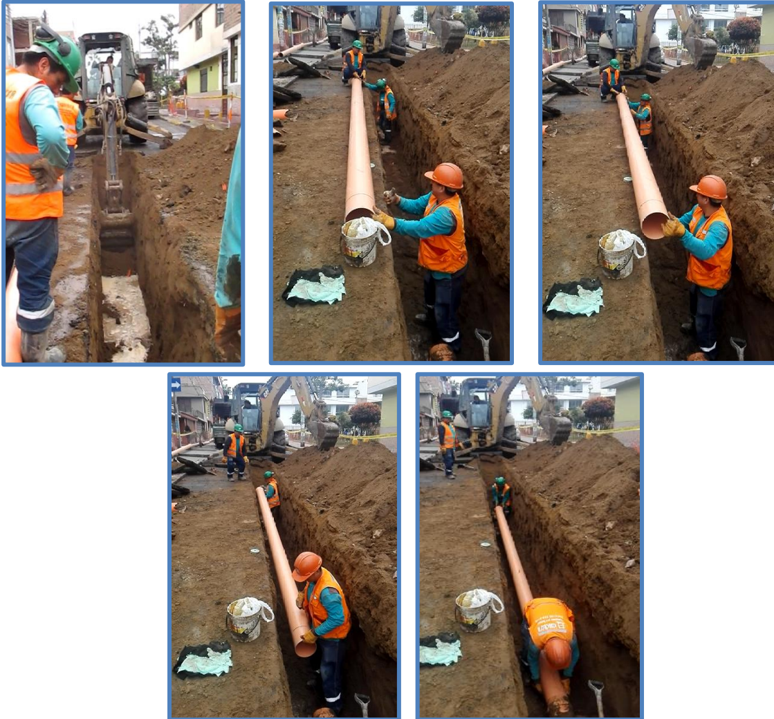
Figura N°39: Descenso de tubería a la zanja
