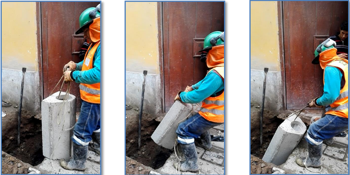
Figura N°09: Descenso de la base de la caja de registro
