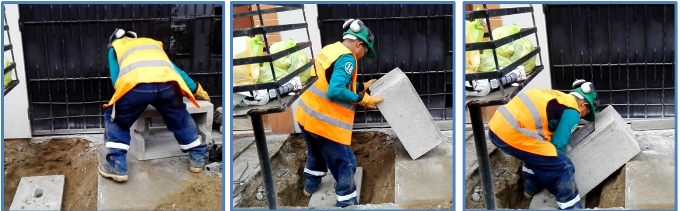
Figura N°20: Descenso de la caja de control
