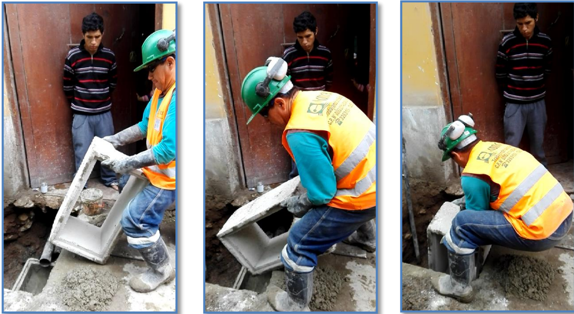
Figura N°11: Descenso de la intermedia de 30
