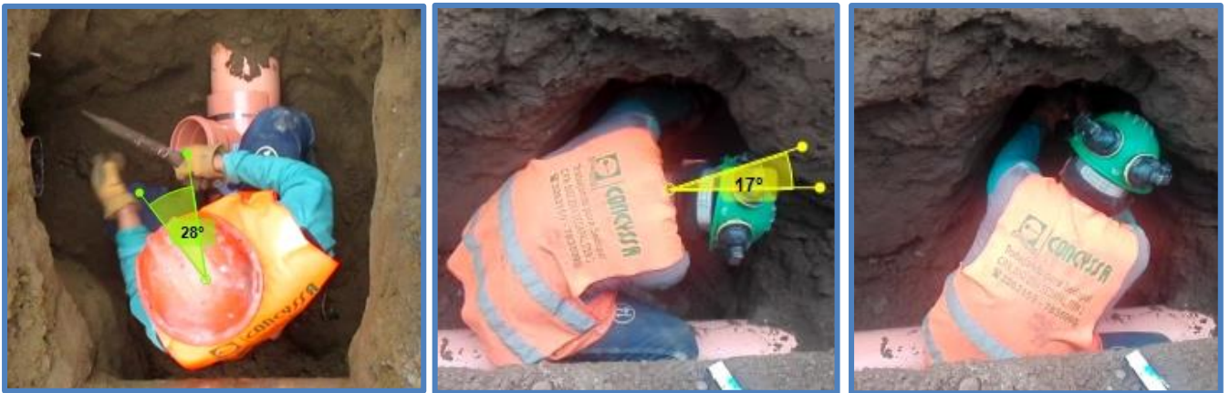
Figura N°25: Escofinado de tubo de conexión
