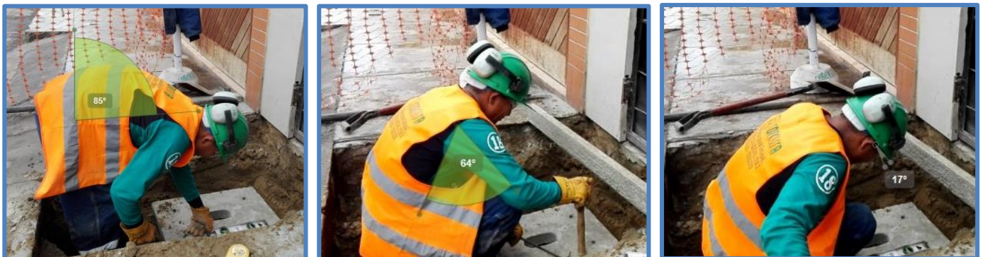
Figura N°19: Nivelación de solado
