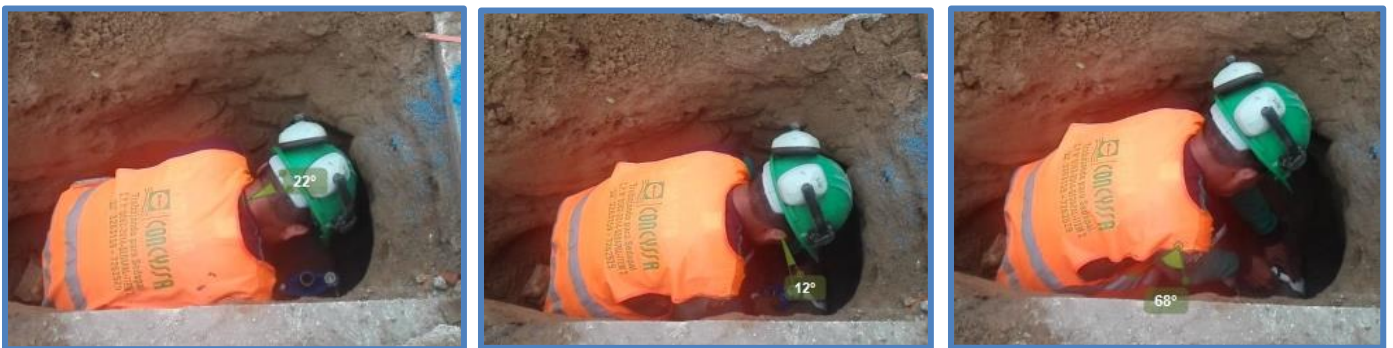
Figura N°22: Colocación de abrazadera
