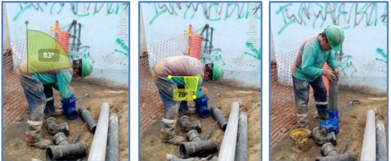
Figura N°35: Embone de tubería a la válvula
