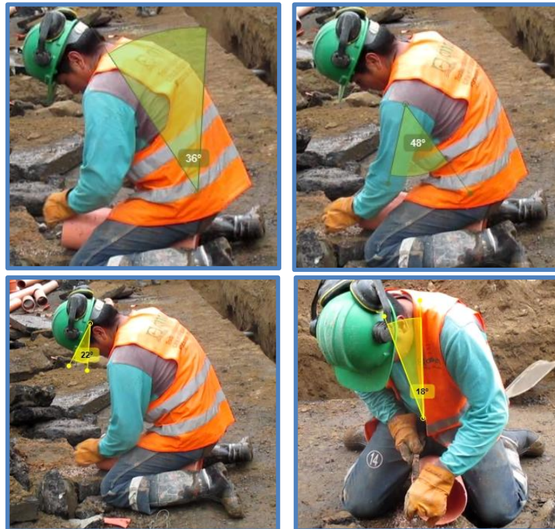
Figura N°28: Escofinado de tubería (niple)
