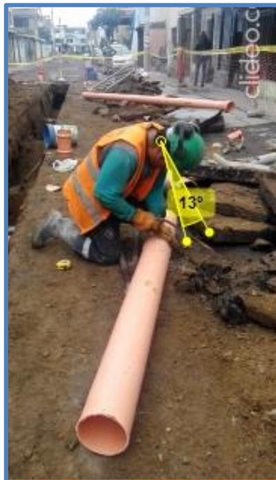
Figura N°27: Corte de tubería (niple)
