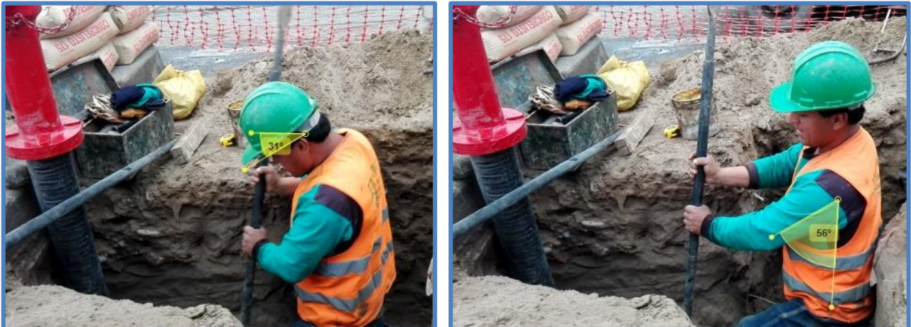
Figura N°37: Embone de válvula y accesorios (Palanqueo)
