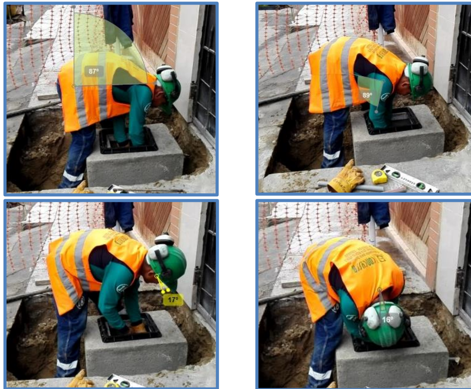
Figura N°21: Colocación de accesorios
