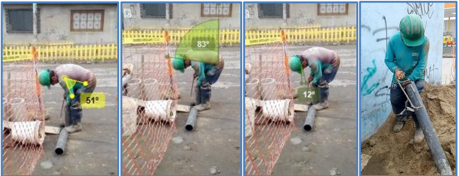
Figura N°34: Escofinado para espiga de tubo
