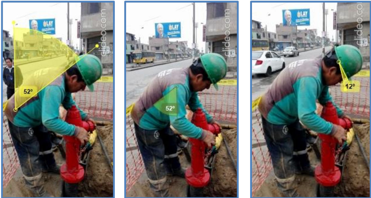
Figura N°38: Embone de válvula y accesorios (Sujeción de grifo)
