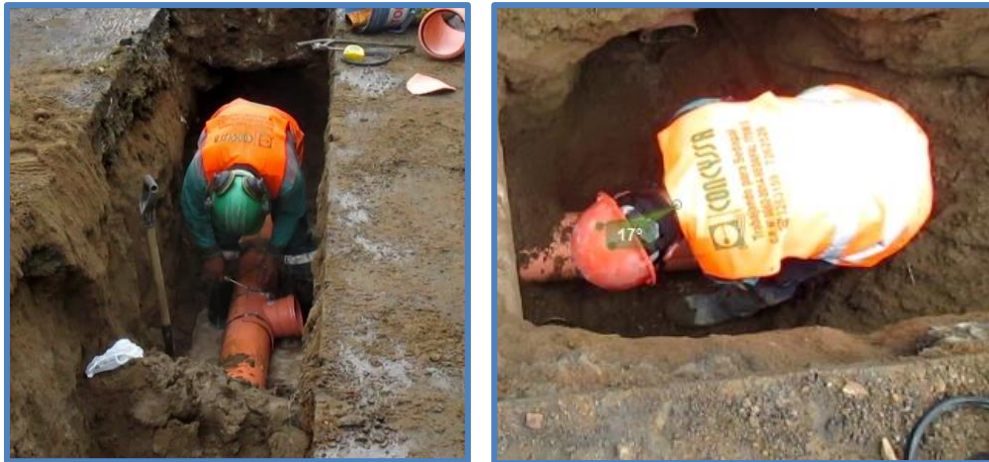
Figura N°29: Montura y zuncho
