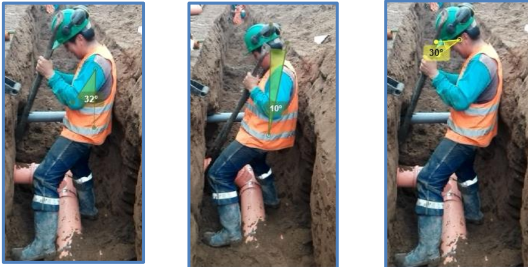
Figura N°30: Embone de niple y corrediza
