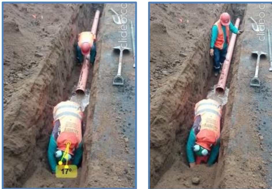
Figura N°40: Alineación de tuberías
