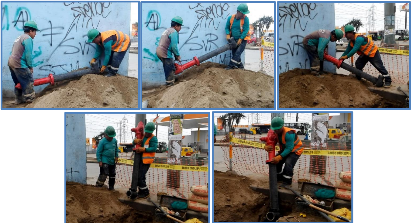
Figura N°36: Transporte y colocación de grifo contra incendio
