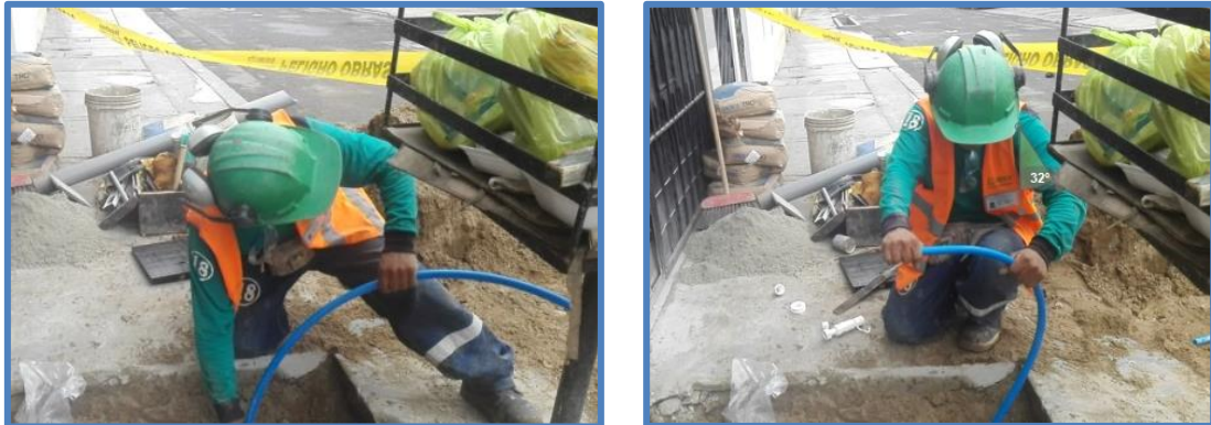
Figura N°23: Tendido de polietileno
