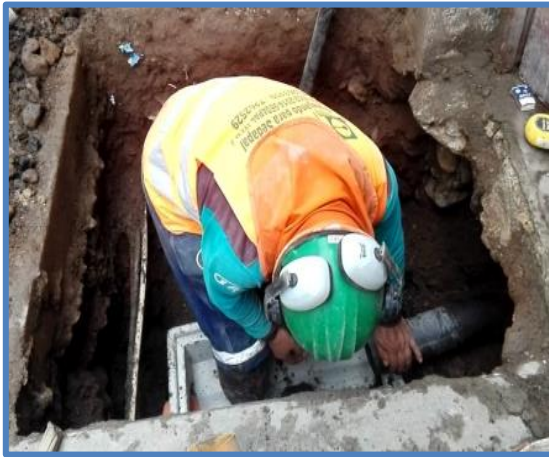
Figura N°10: Acomodo y alineación de la base de caja de registro
