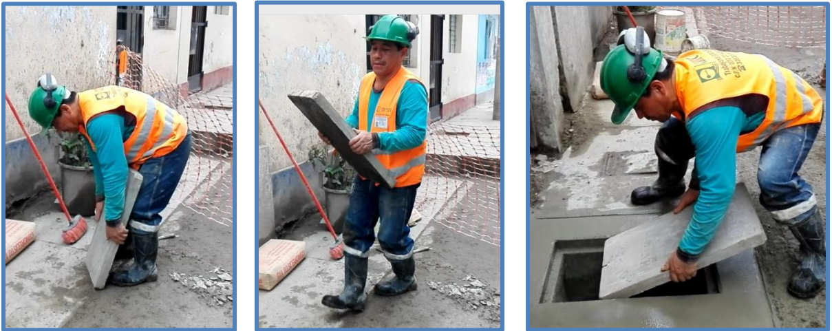
Figura N°16: Manipulación manual de la tapa de concreto de la caja de registro
