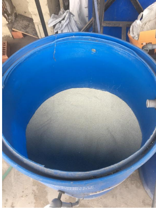
Fotografía N° 12: Instalación de la Zeolita con una altura de 0.55m de altura y radio de 0.55m
