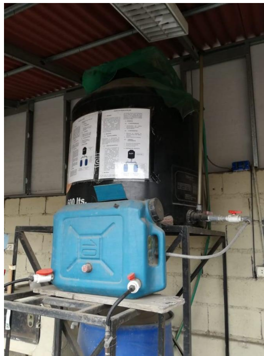
Fotografía N° 11: Instalación del tanque de almacenamiento y tanque de regulación
