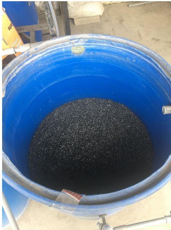
Fotografía N° 13: Instalación de la Antracita con una altura de 0.55m de altura y radio de 0.55m
