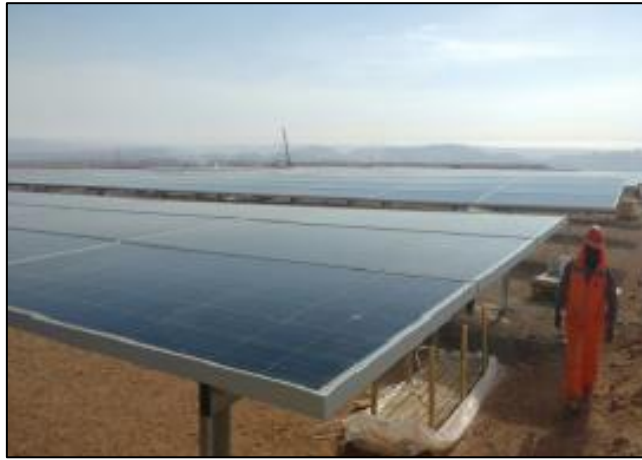
Figura 21: Montaje de paneles solares de la C.S. Intipampa Fuente: Ficha técnica de la C.S. Intipampa (Dirección de Supervisión-Osinergmin, 2019)
