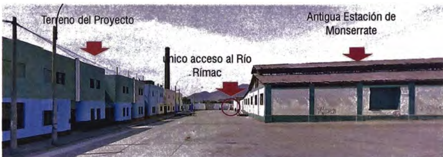
Imagen 37. La única forma de acceder al Río Rímac desde Monserrate es desde el lado este del terreno. Se trata de un estrecho túnel que pasa por debajo de la vía del tren. El ingreso es inseguro y poco legible.
