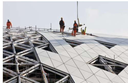
Figura 2-18 Montaje de acero estructural y paneles (Fuente: Mcaslan, 2012)
