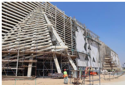
Figura 2-26 Construcción del Gran museo Egipcio (Fuente: Besix, 2019)
