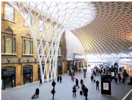
Figura 2-17 Estructura compleja King's Cross Station (Fuente: Mcaslan, 2012)
