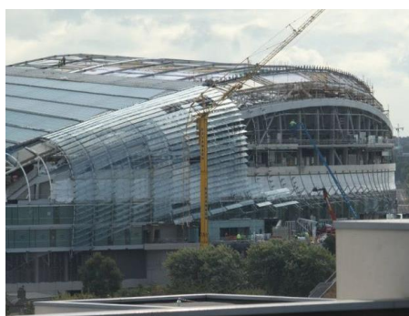
Figura 2-13 Ensamblaje de paneles Lansdowne (Fuente: Lacunae, 2019)
