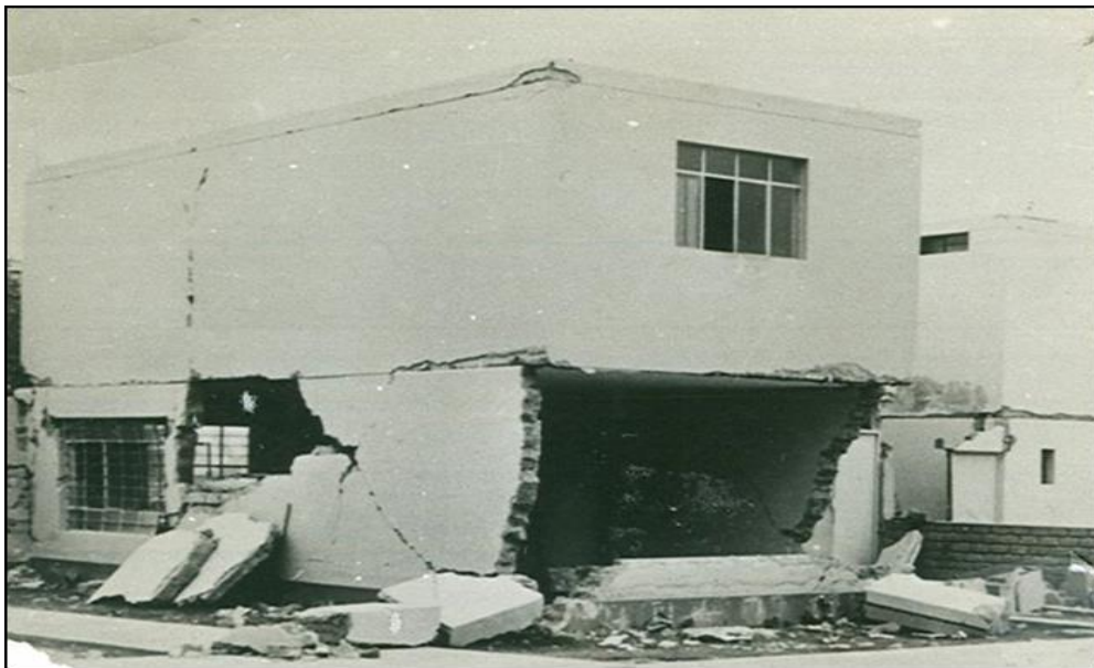
Figura N° 41: Vivienda de albañilería mal confinada, Chimbote 1970. Fuente: Kuroiwa (2016).
