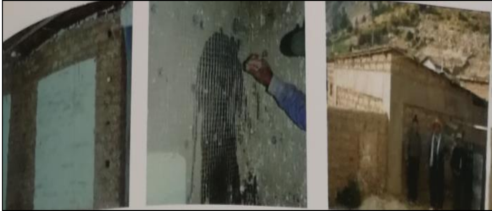
Figura N° 33: Reforzamiento de viviendas de adobe.
