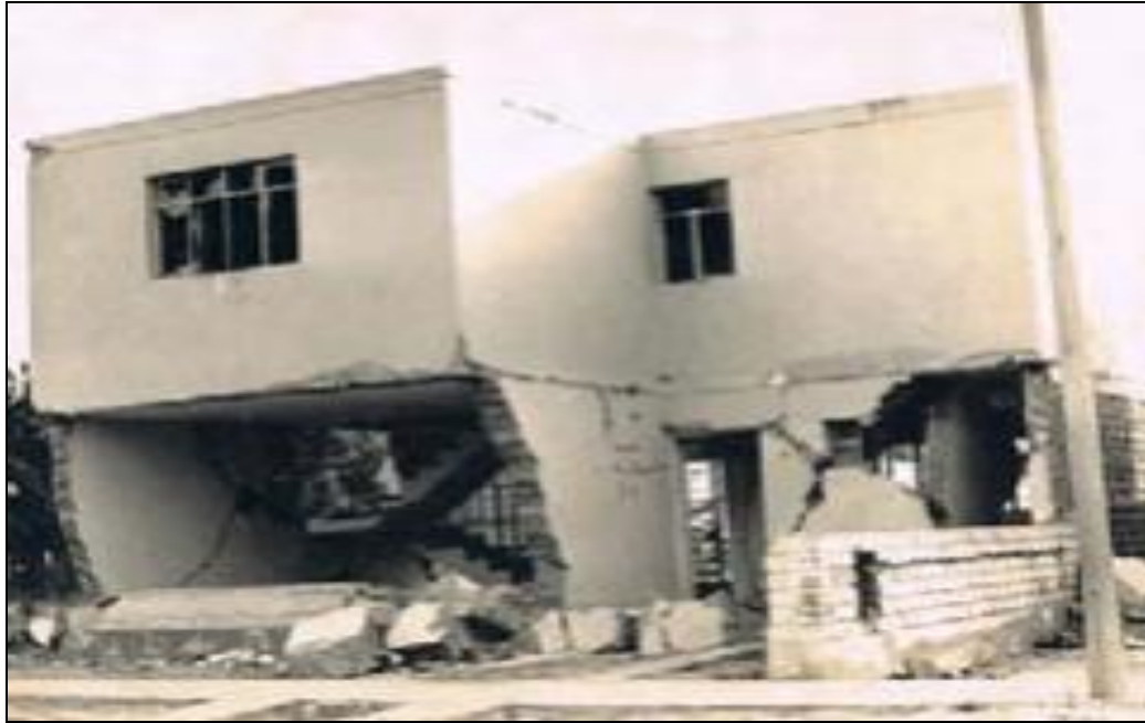
Figura N° 44: Vivienda de albañilería mal confinada, Chimbote 1970.
