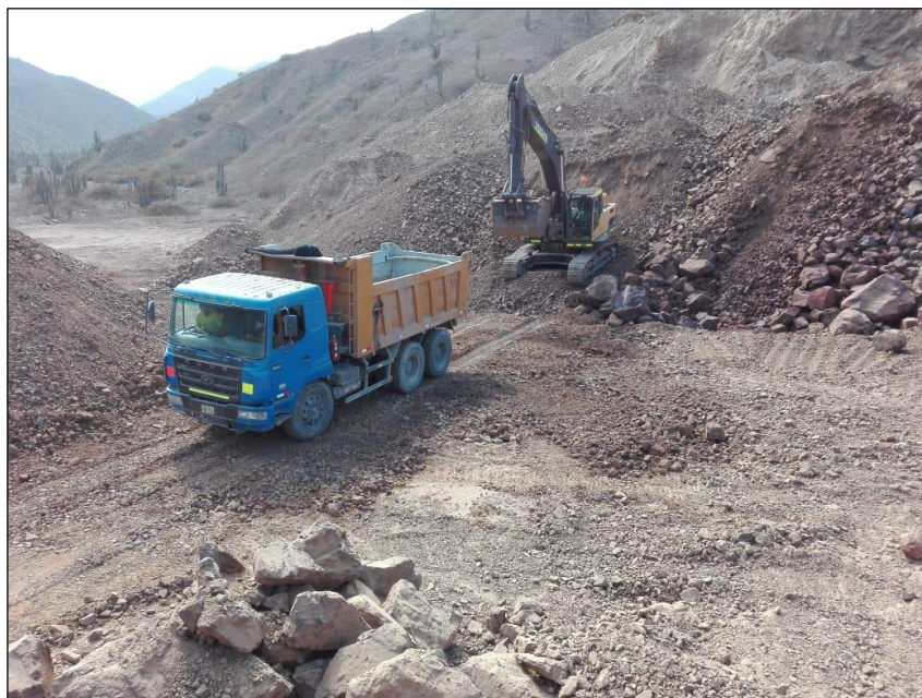
Figura 15 - 5.4 Limpieza y acarreo.
