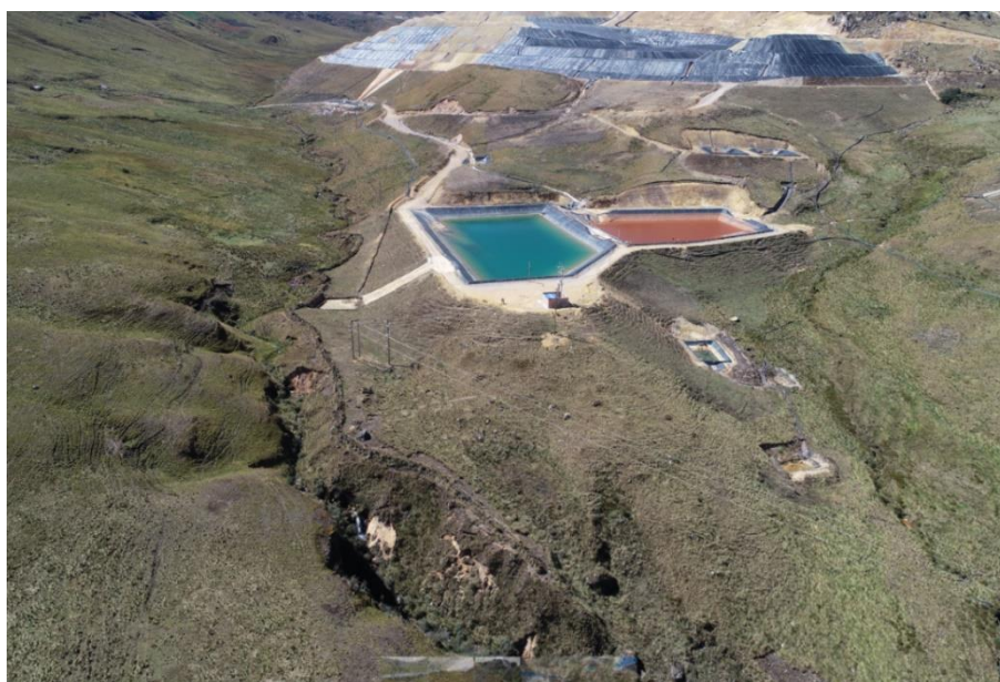
Figura 3.6 Quebrada Tacamache, depósito DME. Fuente: Elaboración propia
