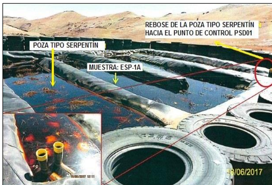
Figura 4.15 Poza tipo serpentín (Wetland), Sistema de tratamiento depósito de desmonte
