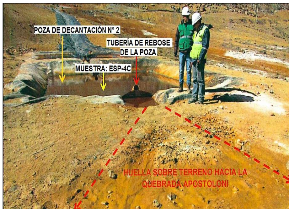
Figura 4.16 Poza de decantación N° 2 Sistema de tratamiento tajo Fuente: OEFA
