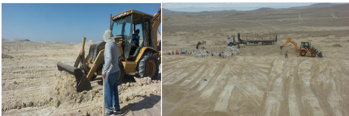
Figura 6.14 En la imagen de la izquierda, se limpia todo el desmorte y material estéril de la superficie. En la imagen de la derecha, se observa toda el área a trabajar.
