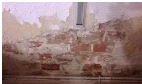
Figura 2.12 Ataque de epsomitas en pinturas. Fuente: http://espiadellabo.com/2014/02/noticia-no5-el-ataque-de-los-sulfatos/
