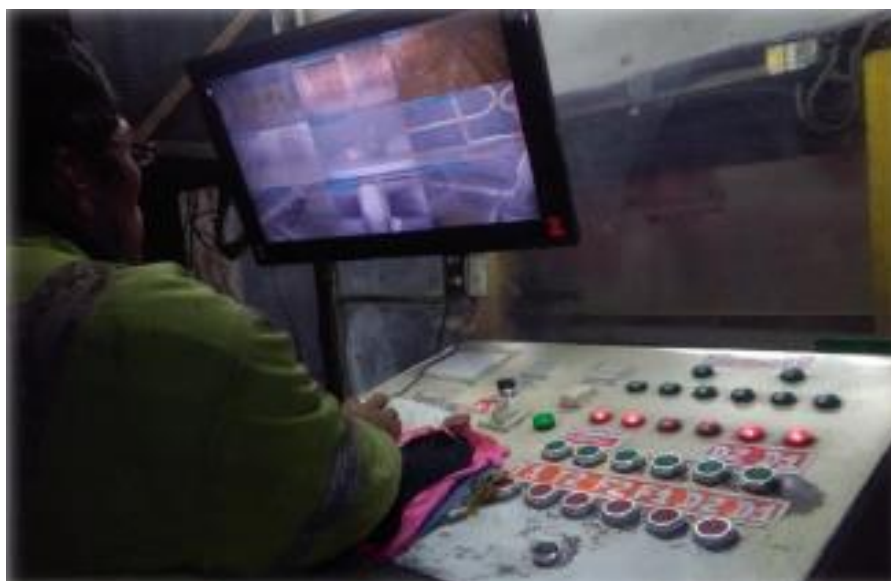
FIGURA 5.11 Cabina de control pique Luz – Estación 4450 Fuente: Elaboración propia.
