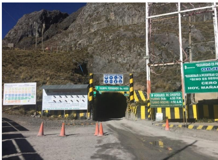
FIGURA 5.2 Ingreso a la RP 760 (Rampa Fernando) de Sección 4.2 \times 3.8 \text{ m}^2 .
