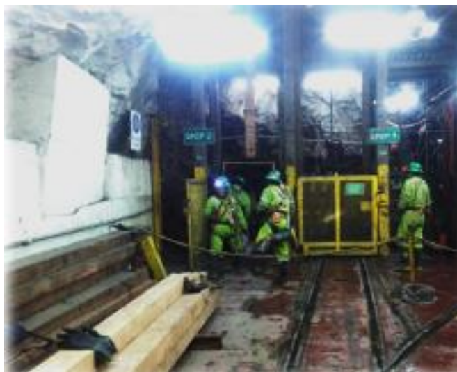
FIGURA 5.19 Mantenimiento de pique, guías de madera para skip. Fuente: Elaboración propia.
