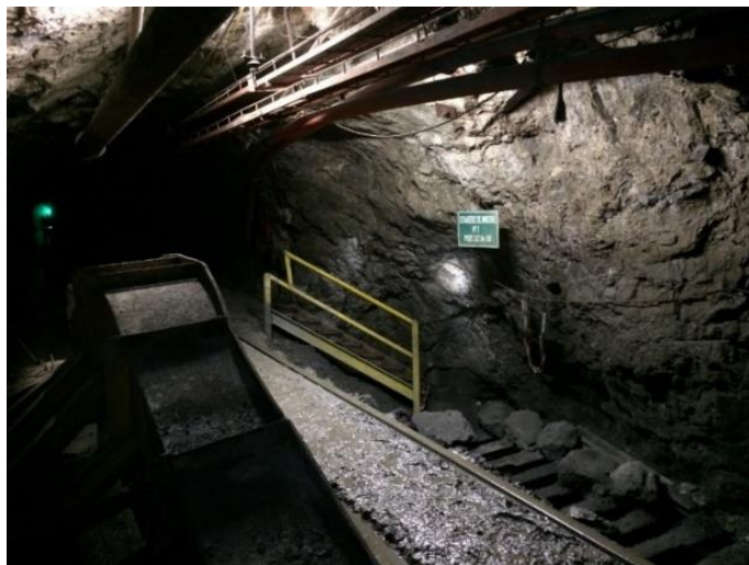
FIGURA 5.18 Echadero de Mineral o Desmote del NV 4120.
