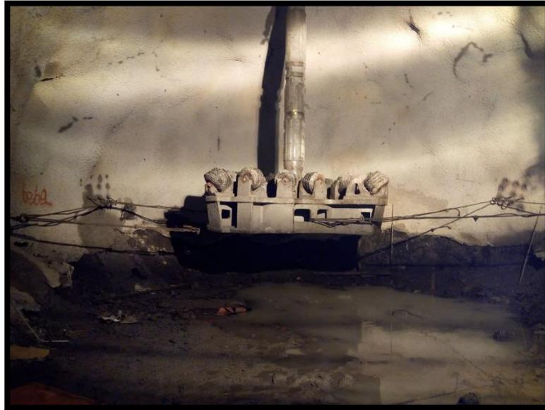
Figura 5.1 Conexión de escariadora - Máquina Raise Borer
