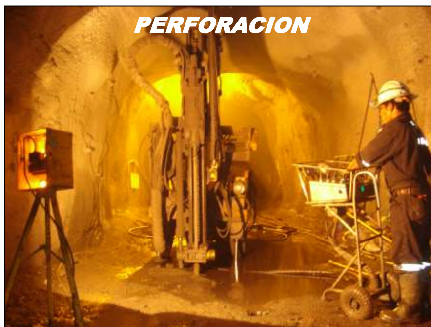
Figura 61. Perforación con Equipo Raptor (Fuente: operación Mina Subterránea, EA Cerro SAC)
