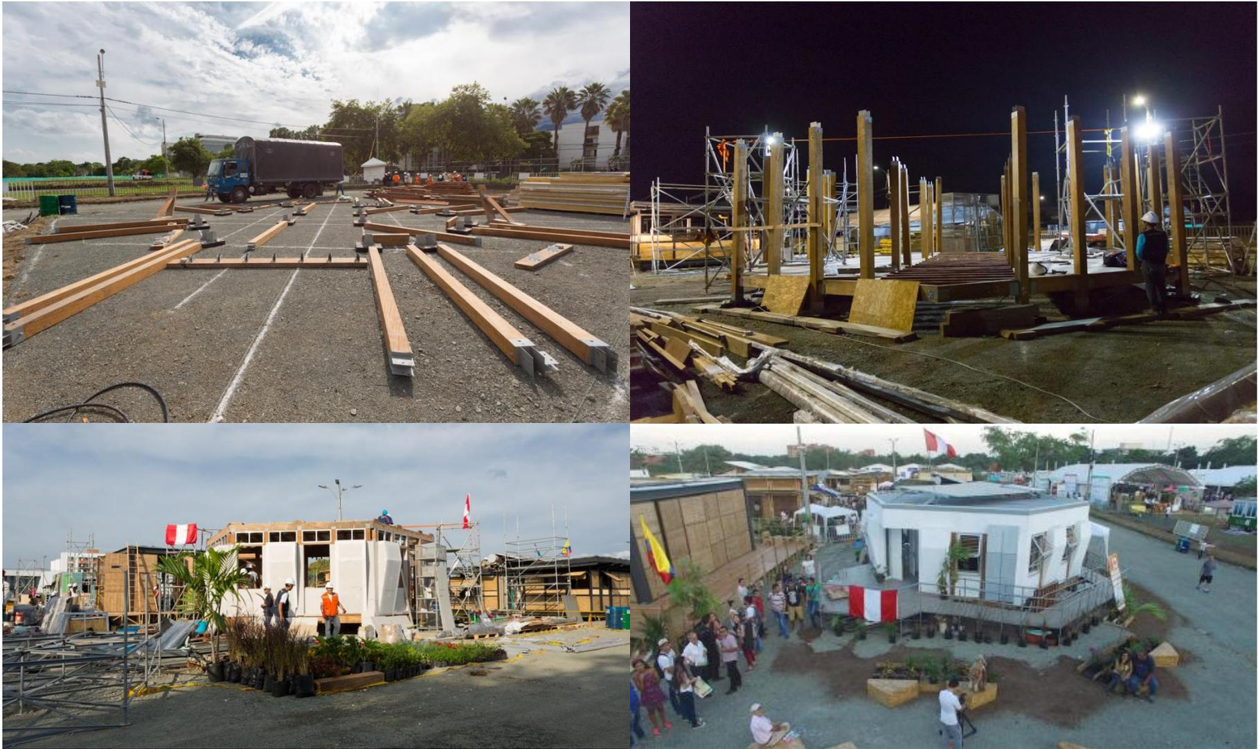
Figura 71. Construcción de la vivienda Ayni en la Villa Solar, Cali, 2015.
