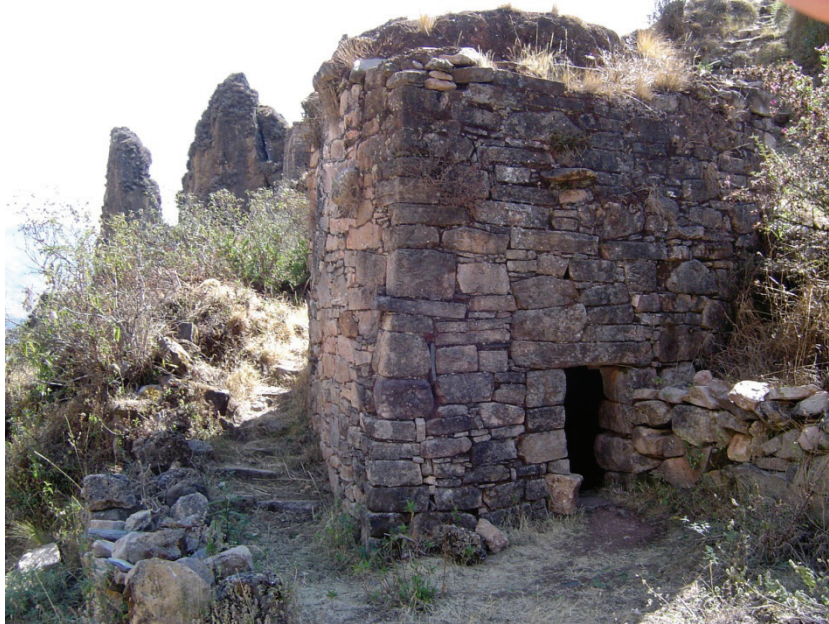
Foto C4.4: Detalle del acceso lateral a otra chullpa .
