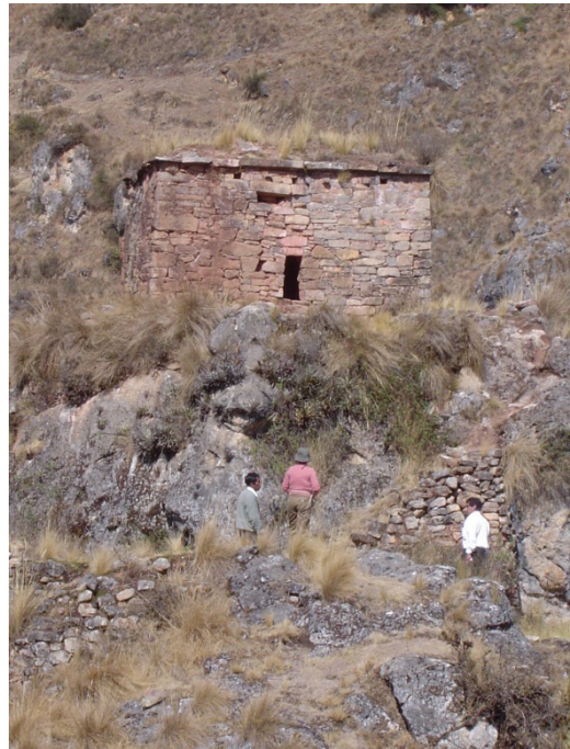
Foto C4.2: Detalle de la chullpa ubicada al fondo de la imagen anterior.
