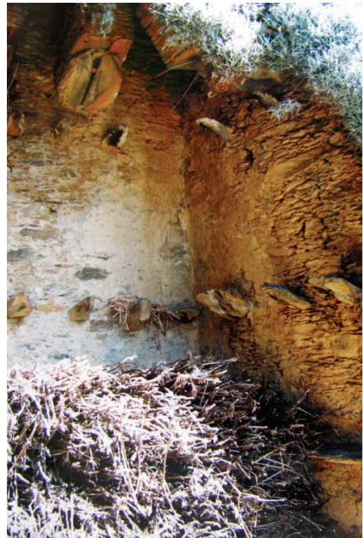
Foto C5.16: Detalle del enlucido de barro en el interior de la de la chullpa B039, esquina Noroeste.
