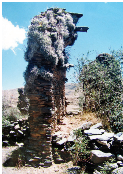
Foto C5.12: Pared Oeste de chullpa B119.
