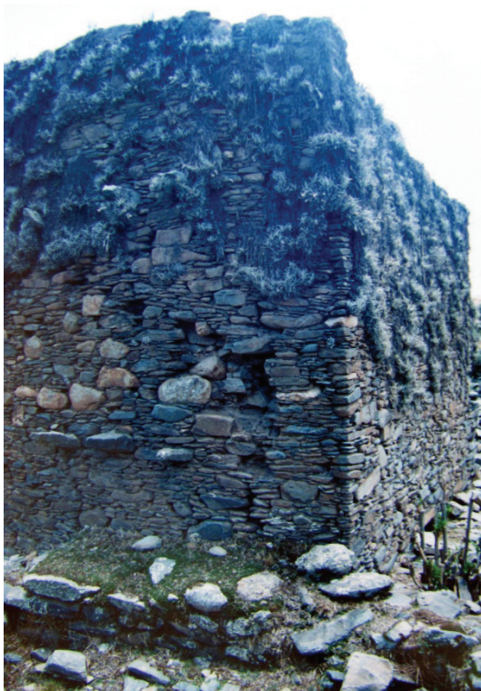
Foto C5.7: Pared Oeste de la chullpa B177.
