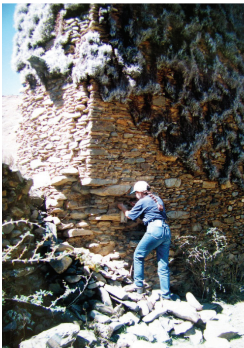
Foto C5.11: Toma de muestra de argamasa.
