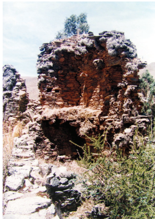
Foto C5.4: Cara interna del muro Oeste de la chullpa B013.
