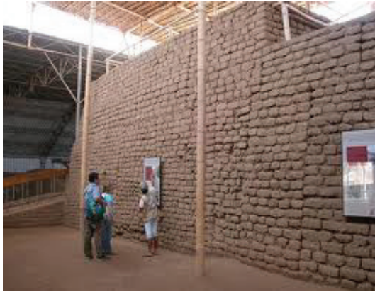
Foto C1.4: Tipología de muros de adobe.
