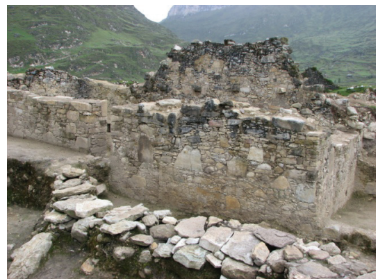
Foto C2.12: Vista de estructura.
