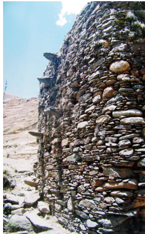
Foto C5.8: Pared Sur y saledizos de la chullpa B177.
