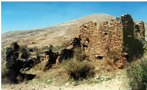
Foto C5.2: Vista del frontis de una chullpa .
