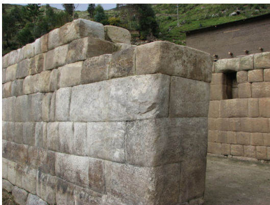
Foto C2.11: Detalle de muro.
