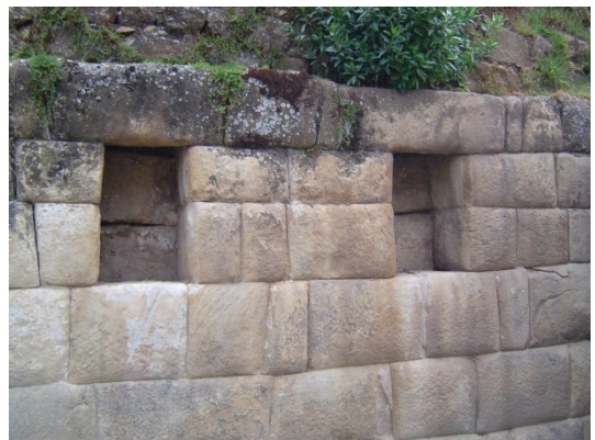
Foto C2.3: Detalle de las hornacinas y el "adoquinado" de las paredes.
