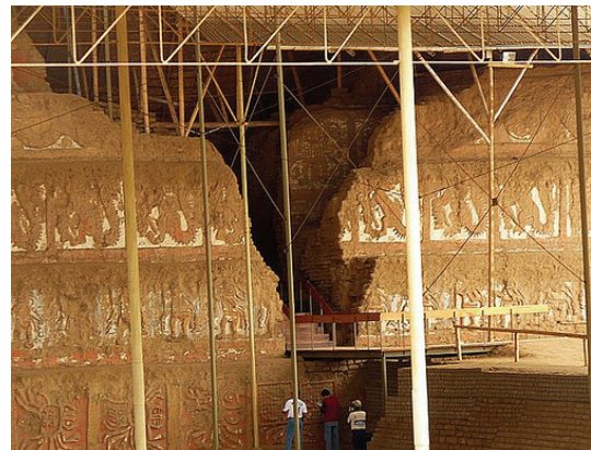
Foto C1.3: Tipo de cubierta y adecuación del ingreso.
