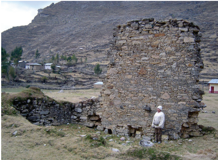
Foto C3.1: Frontis de una chullpa derruida. Autora en la foto
