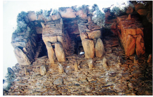
Foto C5.14: Detalle de la cara posterior del frontis de la chullpa B039, mostrando el detalle constructivo de las vigas voladizas y el techo de falsa bóveda.
