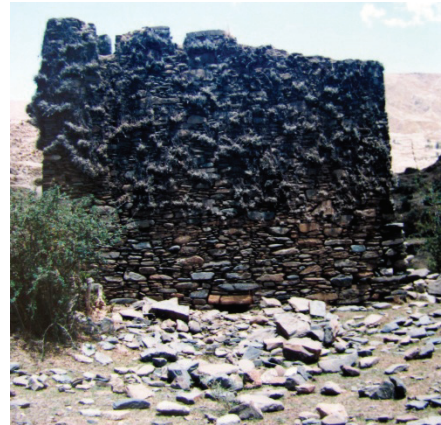
Foto C5.6: Frontis (pared Norte) de la chullpa B177.
