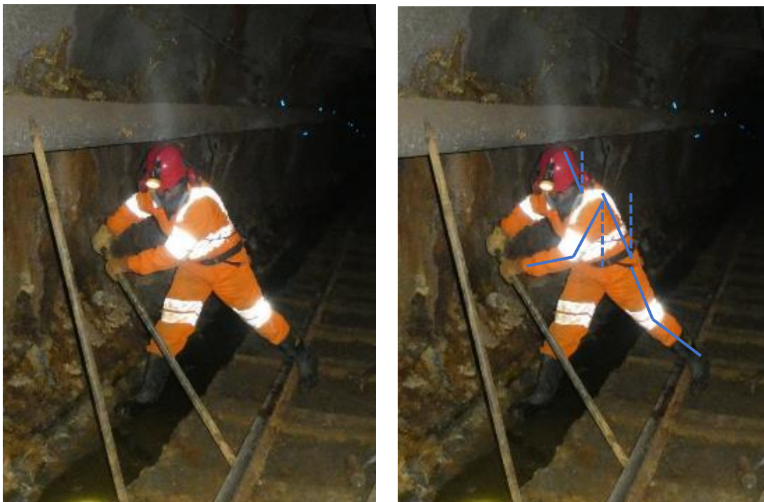
Figura 4.40: Postura adoptada por el maestro carrilano en el alineamiento de la línea férrea.
