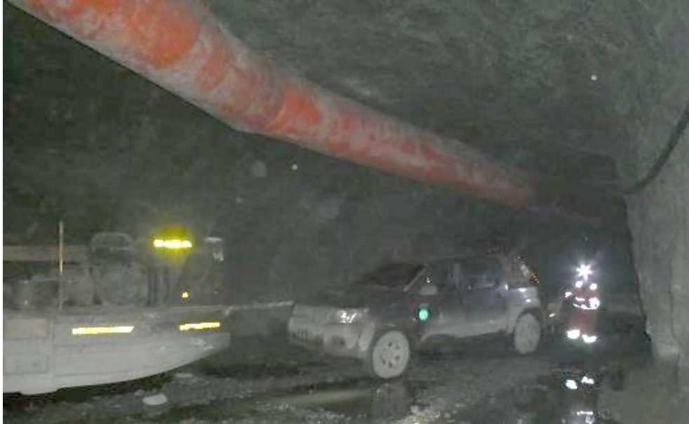
Figura 4.21: Trabajos en los apoyos de coordinación y supervisión de trabajos. Fuente: Elaboración propia
