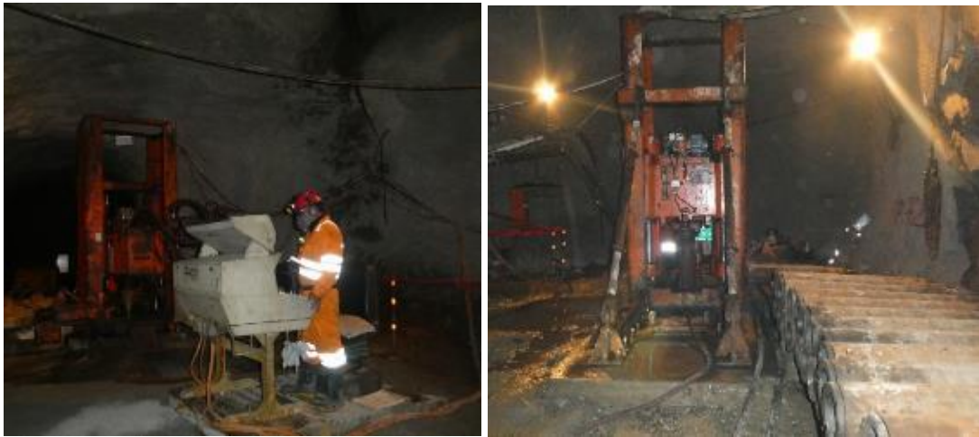
Figura 4.41: Personal operando el equipo de Raise Borer y el equipo de perforación de chimeneas (raise borer) en mina interior.
