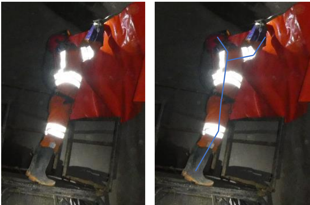
Figura 4.26: Postura adoptada por el operador de ventilación en la instalación de mangas de ventilación.
