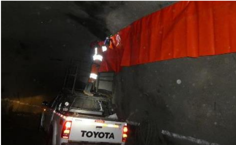
Figura 4.25: Instalación de mangas de ventilación sobre camioneta
