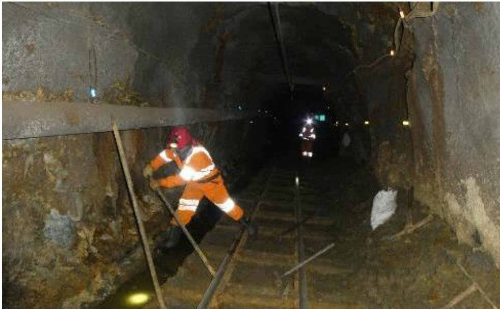
Figura 4.39: maestro carrilano, realizando el alineamiento de la línea férrea. Fuente: Elaboración propia.
