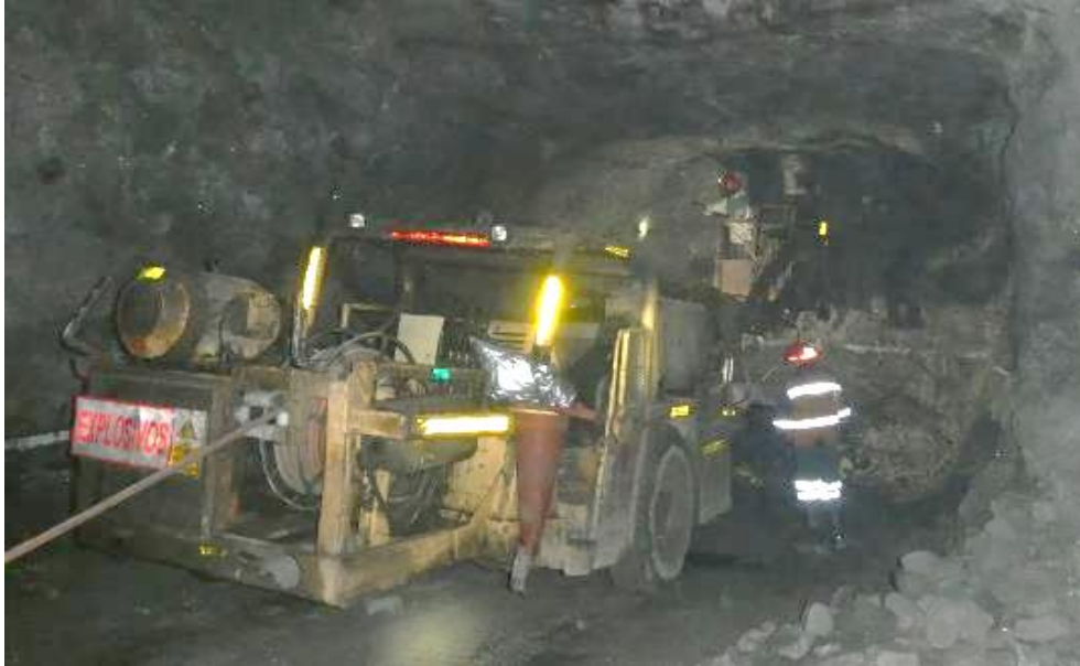
Figura 4.9: Carguío del frente de mineral (breasting) sobre la canastilla del equipo anfotruck.
