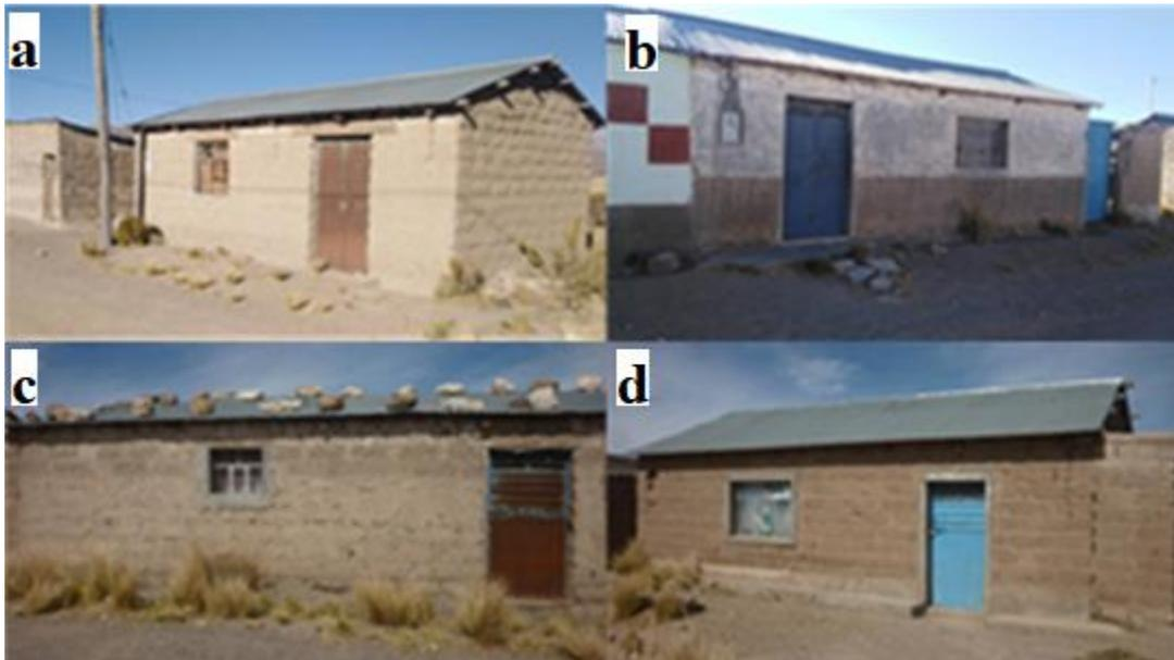
**Fig. 36.** Viviendas con techos de planchas de calamina, Imata: (a) vivienda con techo de calamina y puerta de metal oxidada con marcos de metal, (b) ventanas de vidrio con marco de metal, puerta de metal, (c) piedras colocadas sobre el techo de calamina metálica de la vivienda, y (d) vivienda con techo de calamina metálica, ventana de vidrio simple.
