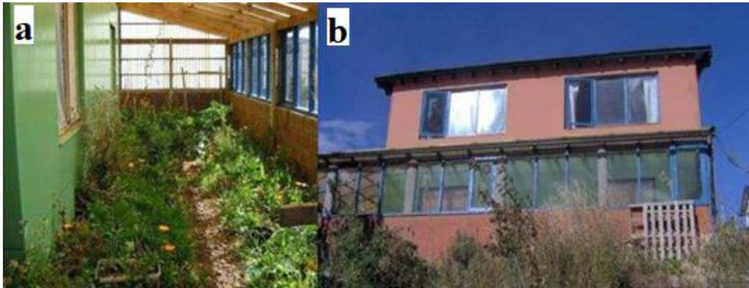
**Fig. 2.** Región norte de la Patagonia Andina, Argentina: (a) vista del interior del invernadero y (b) vivienda en estudio con el invernadero adosado con dirección hacia el norte [15].
