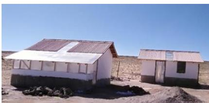
Fig. 1. Módulos experimentales de vivienda, M1 sin invernadero (atrás), M2 con invernadero (adelante).
