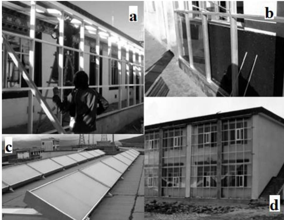
**Fig. 4.** Técnicas solares usadas: (a) invernadero adosado a la escuela, en Dang Xiong, (b) muro Trombe, en Wu Ma, (c) colectores solares instalados en el techo, en Dang Xiong, y (d) escuela ubicada en Yan Ba Jing incorporada un invernadero de dos pisos [4].
