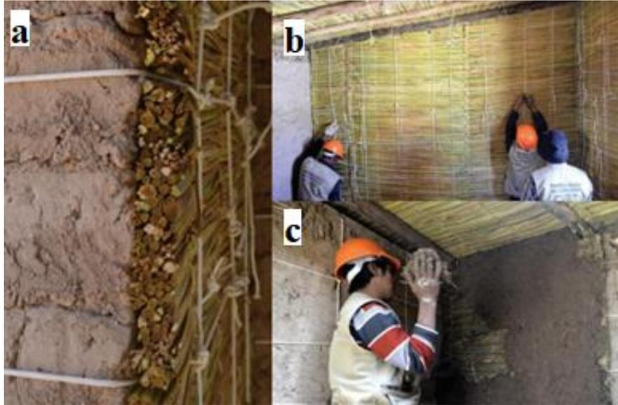
**Fig. 16.** Aislamiento de muros en la comunidad de Orduña, Puno: (a) totora adosada sobre el muro de adobe para su aislamiento [43], (b) tensado de la sogá sobre la totora [43], y (c) embarrado de muros con mezcla de paja y barro [43].
