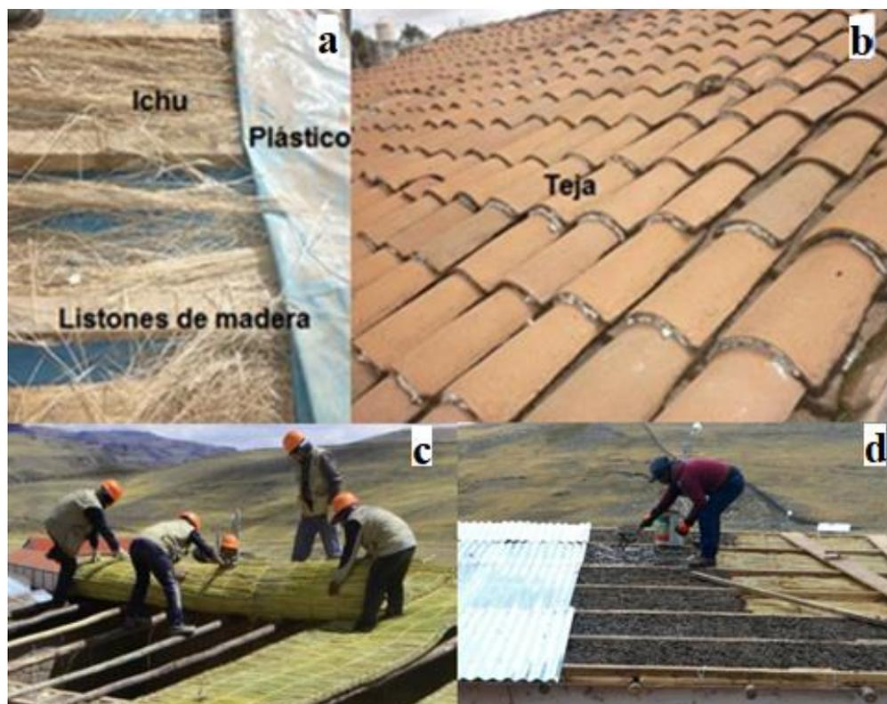
**Fig. 18.** Técnicas bioclimáticas en techos: (a) listones de madera con ichu y plásticos encima del techo [46], (b) teja colocada encima de la madera y el ichu colocado en el
