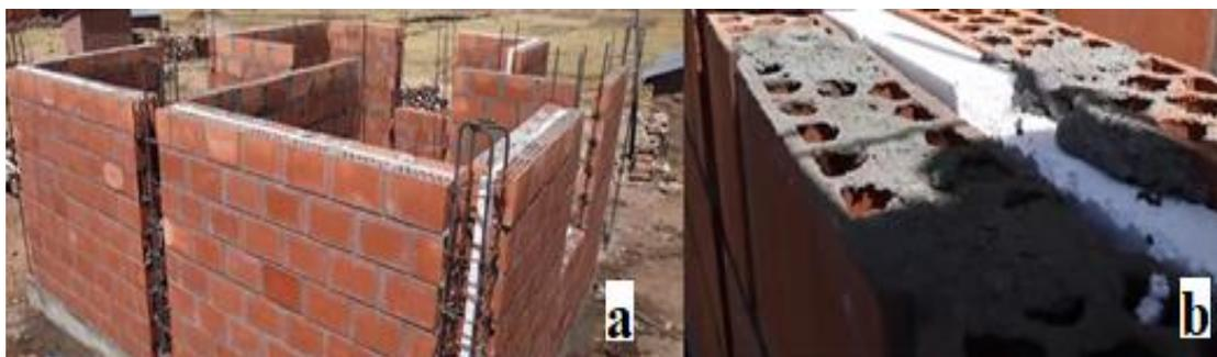
**Fig. 17.** Muros construidos en viviendas Sumaq Wasi, Cusco: (a) construcción de una vivienda Sumaq Wasi con doble muro de ladrillo y aislante térmico en medio [45], y (b) poliestireno expandido entre los muros de ladrillo [45].
