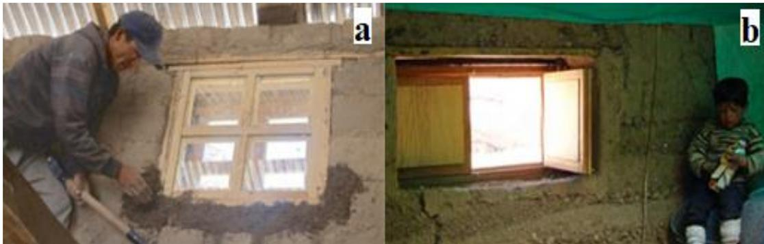
**Fig. 20.** Aislamiento de ventanas y uso de contraventanas: (a) sellado con barro sobre las rendijas entre el marco de la ventana y el muro de adobe [48], (b) contraventana abierta hacia el interior para que ingrese la ventilación hacia el interior del dormitorio [17].
