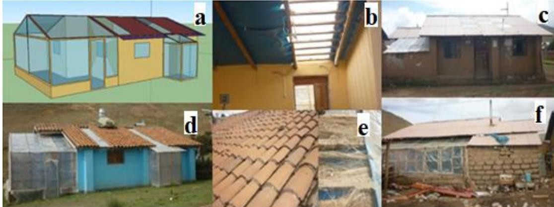
**Fig. 9.** Albergue construido y vivienda mejorada en San Francisco de Raymina: (a) diseño en *SketchUp* de la vivienda, (b) vista interior de las claraboyas en el techo, (c) claraboyas en el techo, vista desde el exterior, (d) albergue construido, vista desde el exterior, (e) tejas sobre el ichu y plástico, que van por encima del techo, y (f) vista del invernadero adosado a la segunda vivienda [7].
