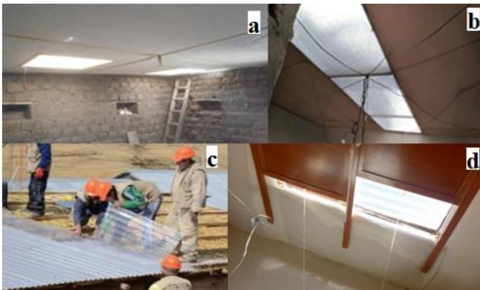
**Fig. 19.** Cielo raso y claraboyas en los techos: (a) cielo raso elaborado con tela arpillera debajo del techo con espacio para el ducto solar [48], (b) cielo raso elaborado con triplay como base y al medio con material de policarbonato alveolar traslúcida [49], (c) plástico como base y al medio con material de policarbonato alveolar traslúcida [49], (d) plástico transparente sobre el techo en el lugar de la claraboya [49].
