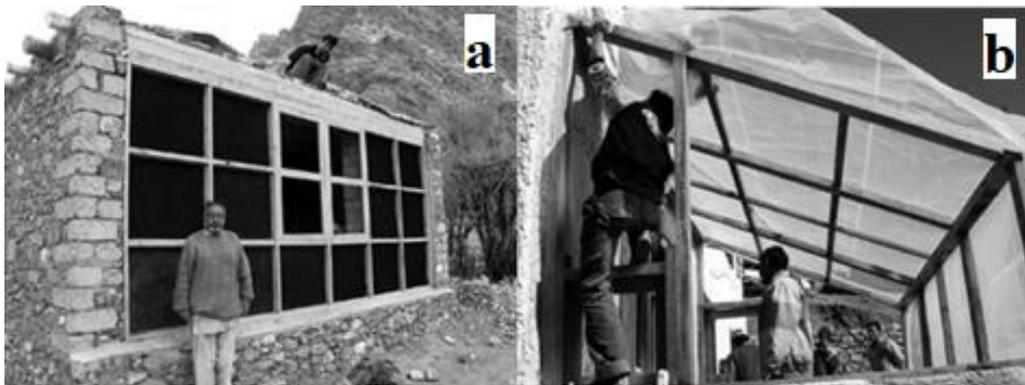
**Fig. 3.** Tecnologías bioclimáticas implementadas: (a) muro Trombe orientado hacia el sur de la vivienda, ubicada en el estado de Himachal Pradesh, y (b) construcción del invernadero adosado a la vivienda con orientación hacia el sur, ubicada en el estado de Himachal Pradesh [4].
