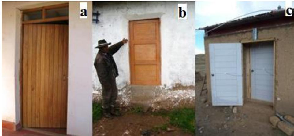
**Fig. 21.** Tipos de puertas de madera en viviendas Altoandinas: (a) puerta de madera sin oquedades [17], (b) sellado del marco de madera [16], y (c) esclusa conformada por dos puertas [6].
