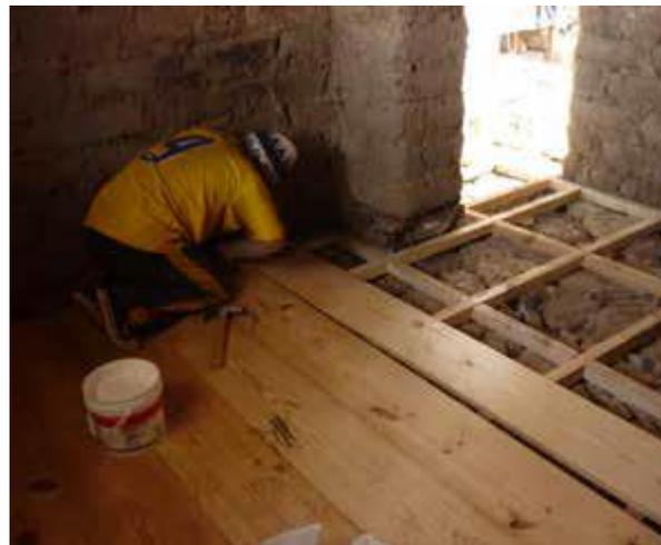
**Fig. 13.** Piso con cama de piedras y tablas de madera machihembrada [26].
