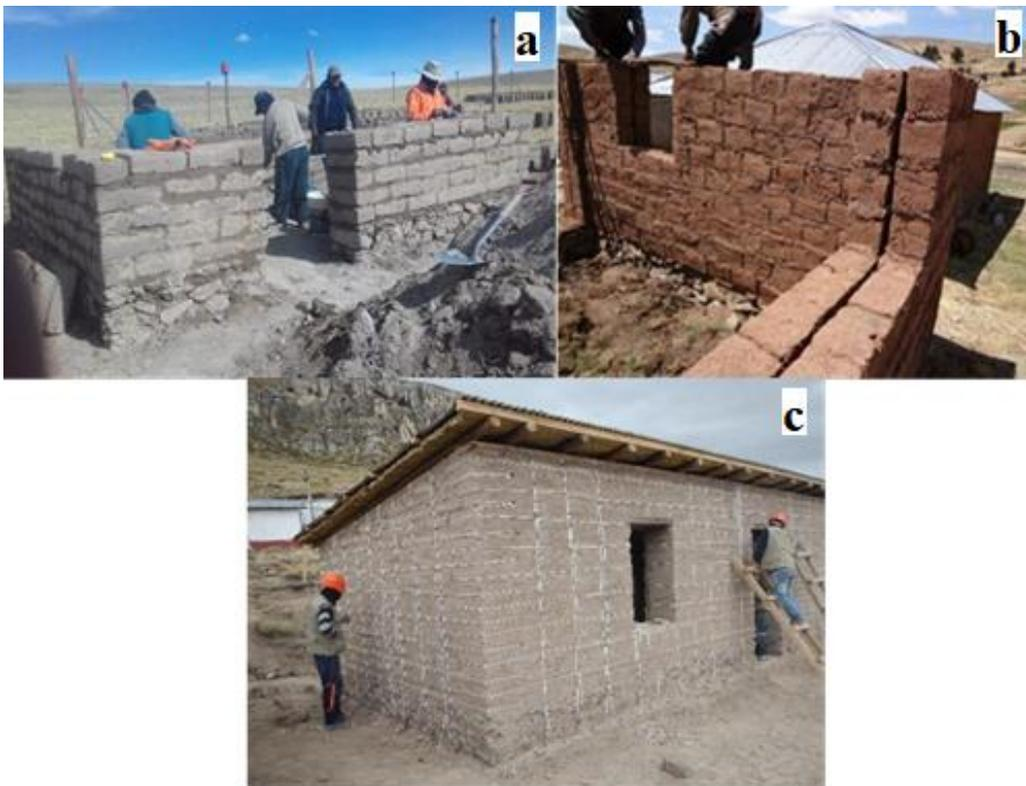
**Fig. 15.** Tipos de muros construidos de adobe: (a) muro simple de adobe en Imata, Arequipa [33], (b) doble muro con espacio de aire separado entre ellos en Ilave, Puno [8], y (c) muro de adobe reforzado con sogas de nylon (driza), Orduña, Puno [44].
